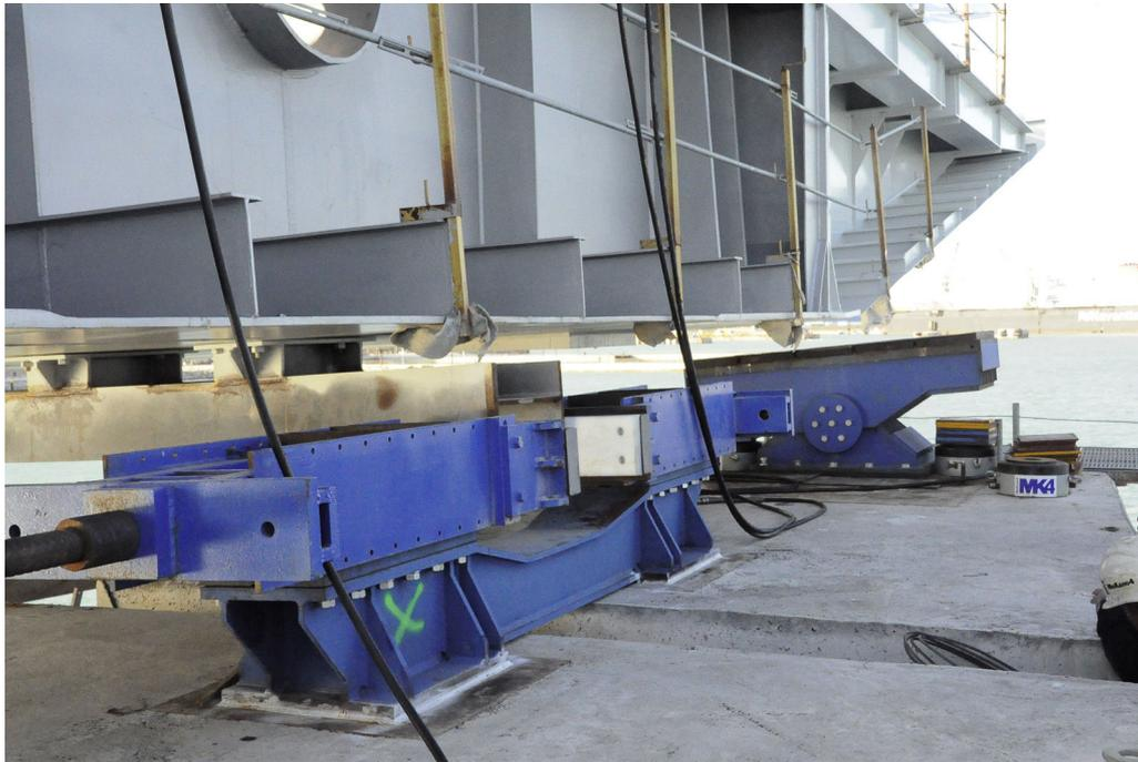
Figura 4. Detalle de guiadera longitudinal.
