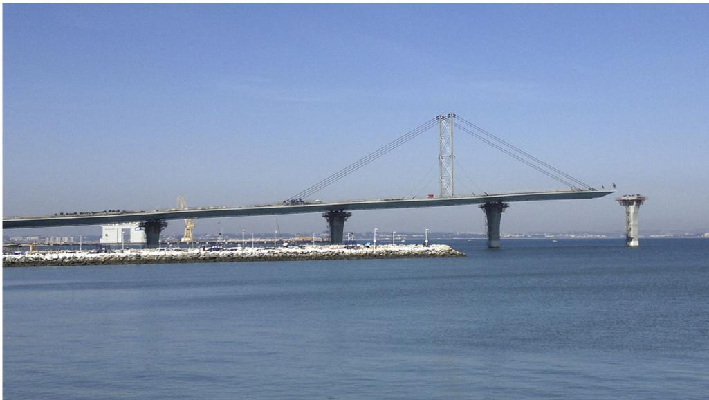
Figura 9. Sistema de atirantamiento provisional.
