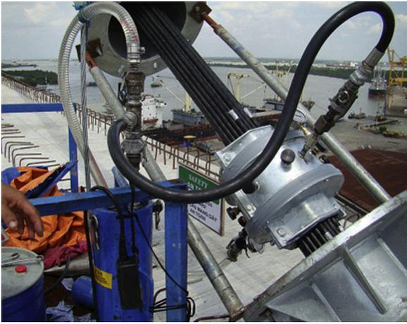
Figura 8. Montaje de los amortiguadores.
