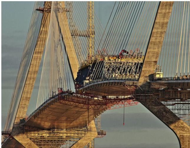
Figura 5. Vista del tablero durante la construcción.
