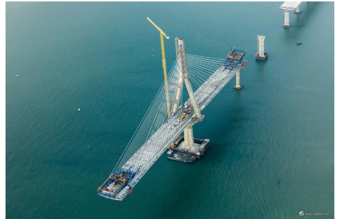
Figura 3. Voladizo máximo de la torre de la Bahía (cortesía de Objetivo Aéreo).
