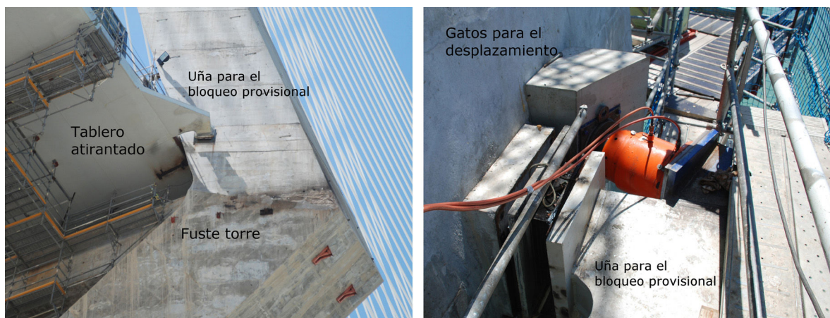
Figura 9. Uñas para el bloqueo provisional del tablero y sistema de gatos.
