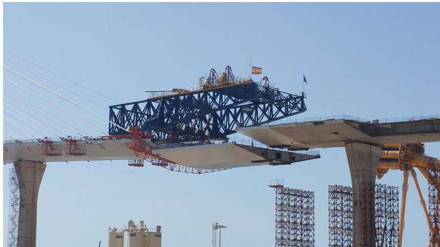
Figura 24. Colocación de la última dovela del tramo atirantado.
