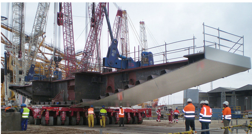
Figura 3. Balancín especial para el izado de la dovela de pila.
