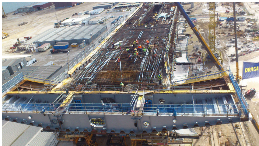
Figura 21. Dovelita de transición (17DP13) con el tramo de núcleo ferrallado, previo al hormigonado.
