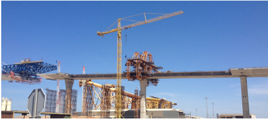
Figura 23. Carro de alas situado sobre la pila 16 para ejecutar los voladizos de la sección del vano 15-16.
