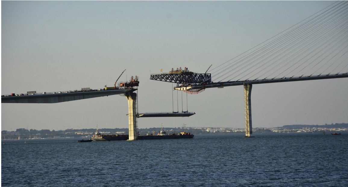
Figura 14. Izado de la dovela 16IP12.
