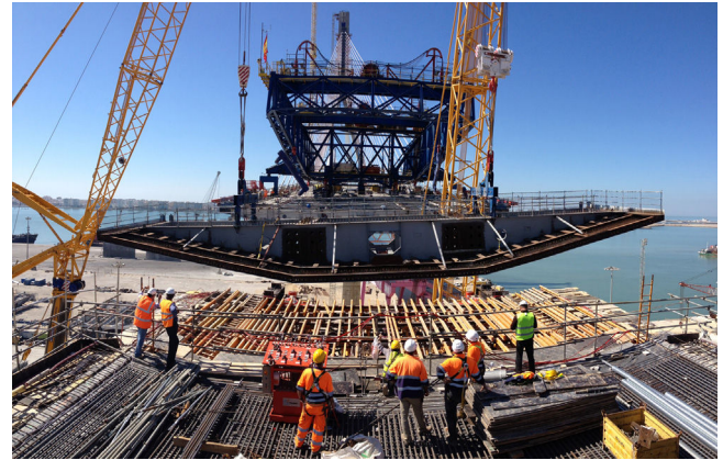
Figura 20. Colocación de la dovela de transición (17DP13) sobre la cimbra.
