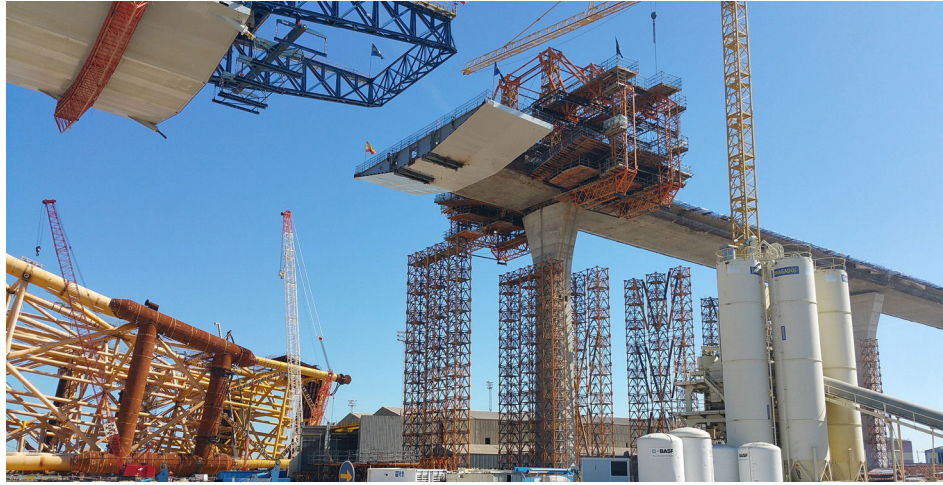
Figura 22. Carro de alas situado sobre la pila 15 para ejecutar los voladizos de la sección hasta la dovela de transición.
