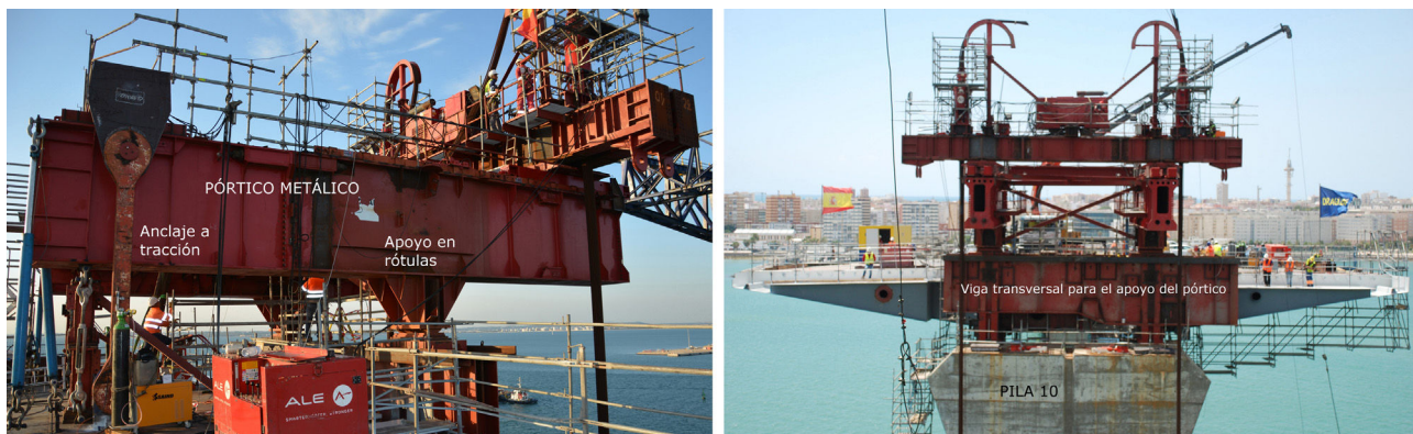
Figura 15. Pórtico de izado situado sobre la pila 10 y anclado al tramo desmontable.
