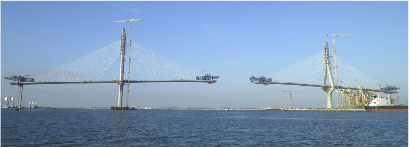
Figura 12. Fase constructiva con el tablero ya apoyado en las primeras pilas de retenida.
