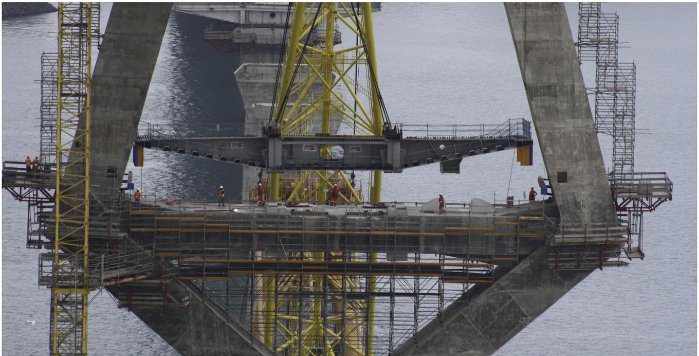
Figura 3. Colocación de la dovela 0P12.
