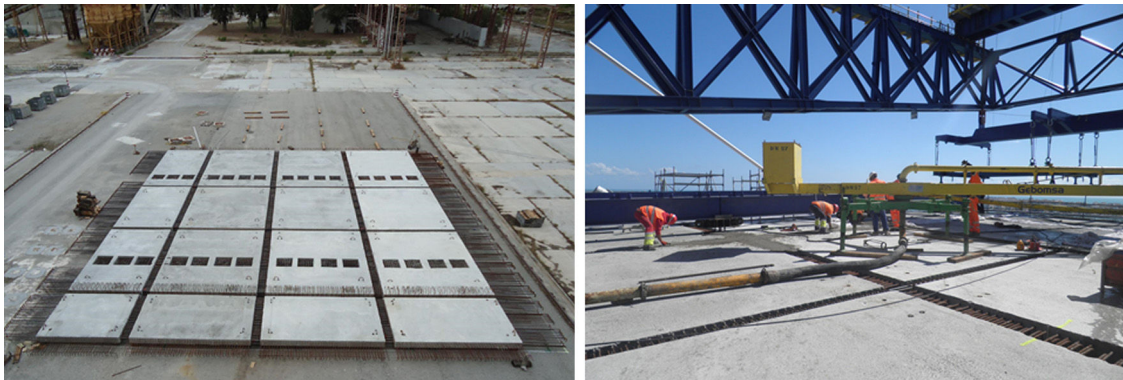
Figura 13. Configuración tipo de losas prefabricadas.
