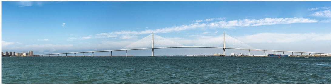
Figura 2. Vista general del puente.
