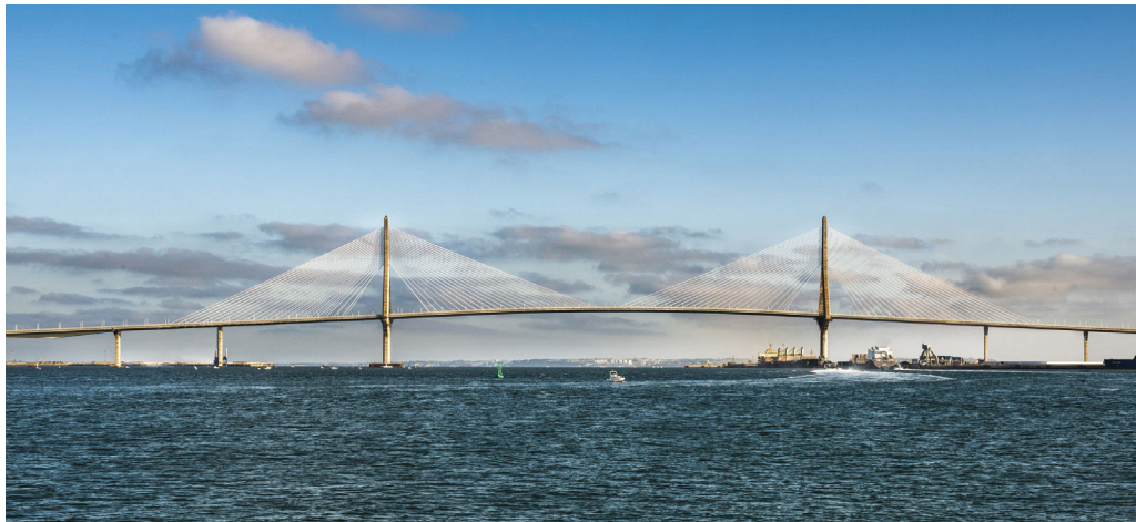
Figura 3. Vista parcial del puente.
