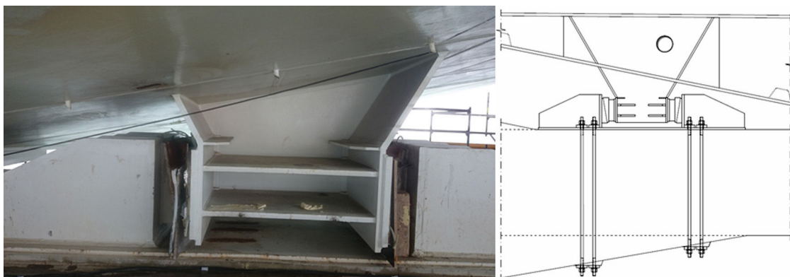
Figura 24. Topes transversales entre tablero y torres.
