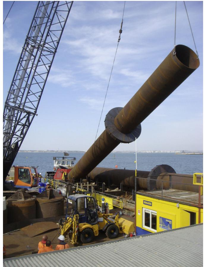
Figura 6. Camisas de pilotes, collarín de apoyo y conexiones.
