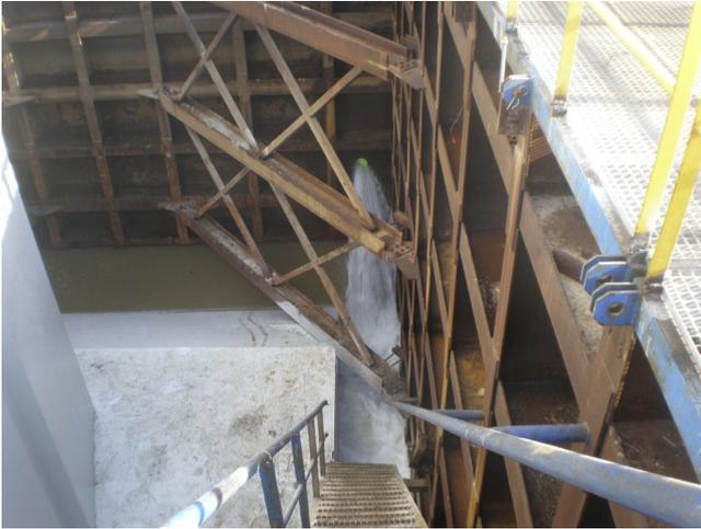
Figura 10. Inundación del recinto previa a desmontaje.
