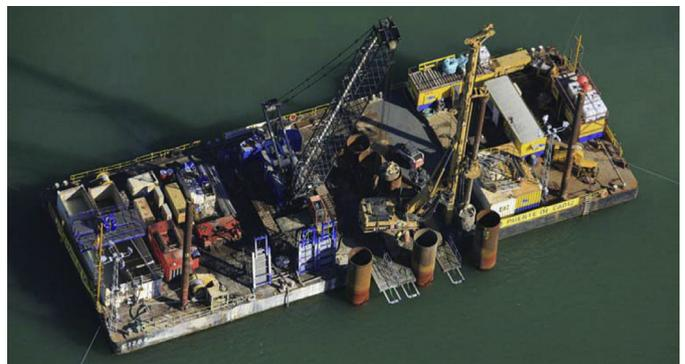
Figura 4. Ejecución de los pilotes desde pontona.
