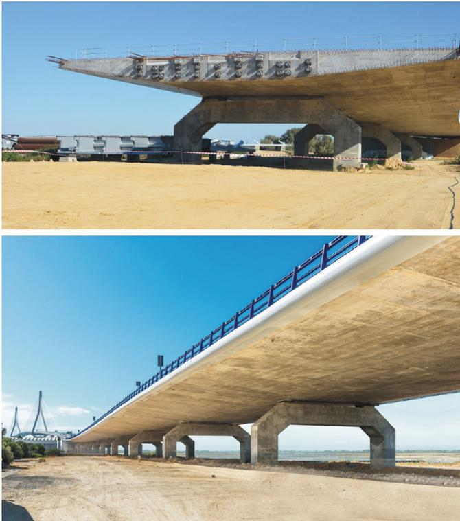
Figura 32. Vista del viaducto de acceso lado Puerto Real, canto 2,00 m.
