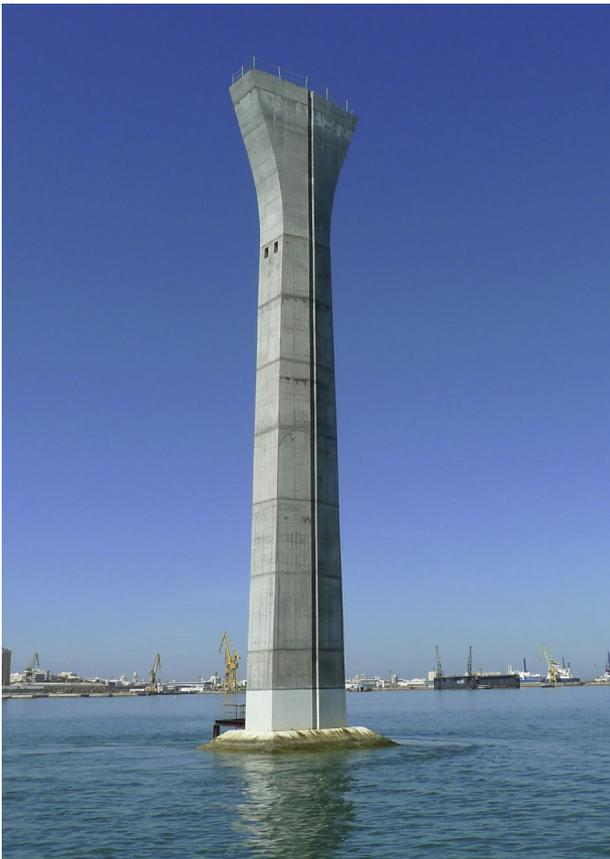
Figura 15. Fuste de las pilas.
