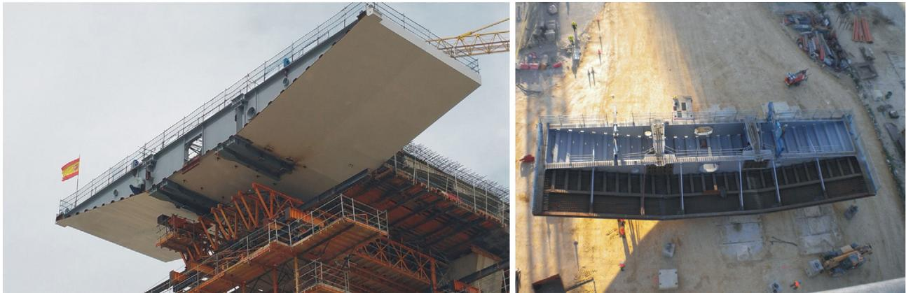
Figura 34. Dovela de conexión dintel mixto–dintel hormigón.
