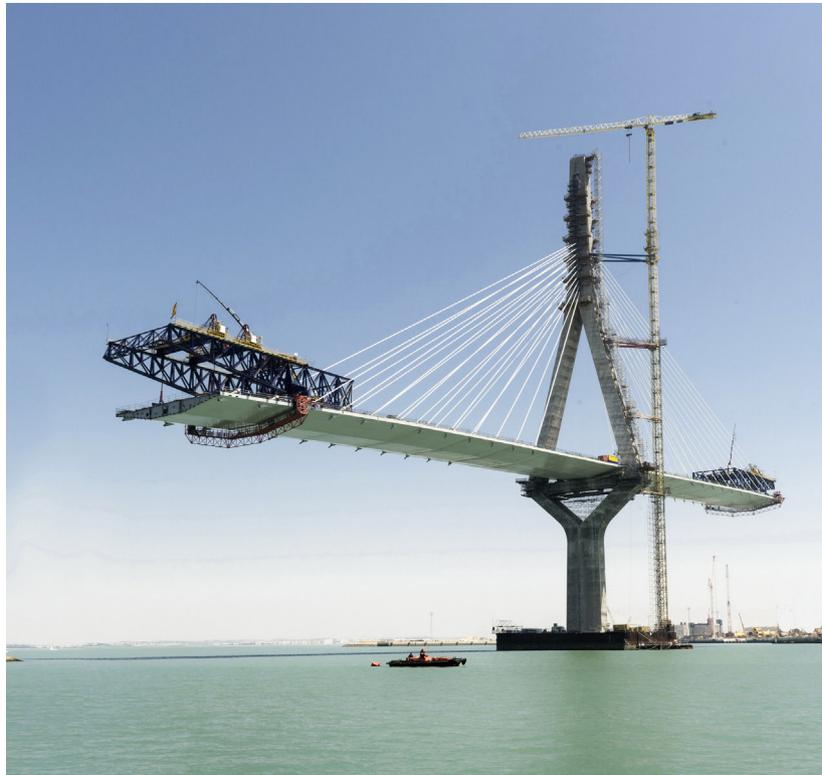
Figura 26. Construcción por avance en voladizo simétrico.
