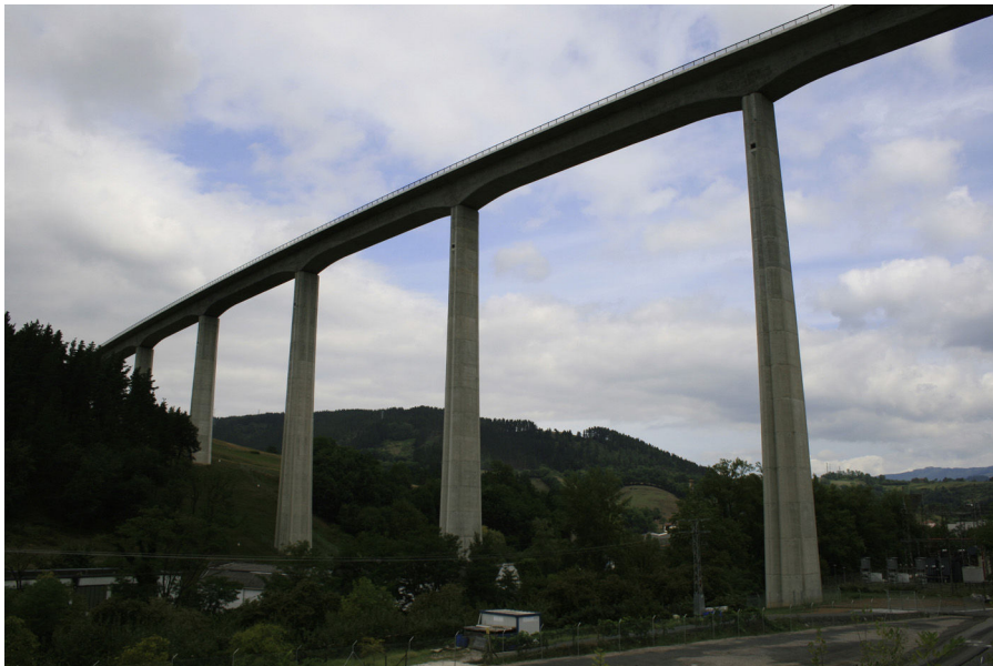
Figura 44. Imagen del viaducto concluido.
