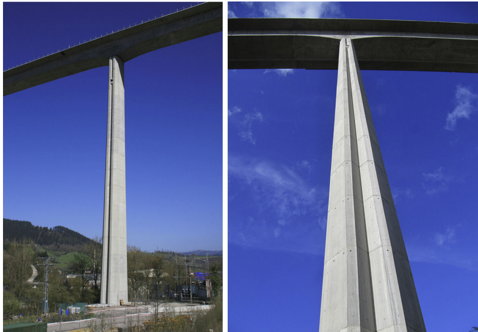
Figura 15. Imágenes de las pilas más altas con el viaducto concluido.
