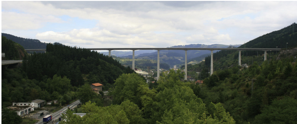
Figura 11. Imagen del viaducto construido de hormigón pretensado.
