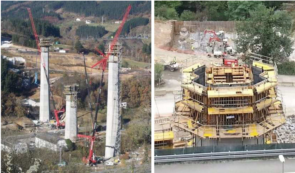
Figura 18. Vista general y de detalle de la ejecución de las trepas del fuste de las pilas.
