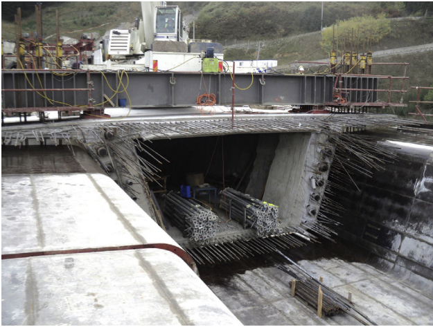
Figura 26. Vista del frente de fase, con los anclajes de tendones de negativos, de tendones parabólicos de continuidad y el sistema de cuelgue de la cimbra del extremo del voladizo.
