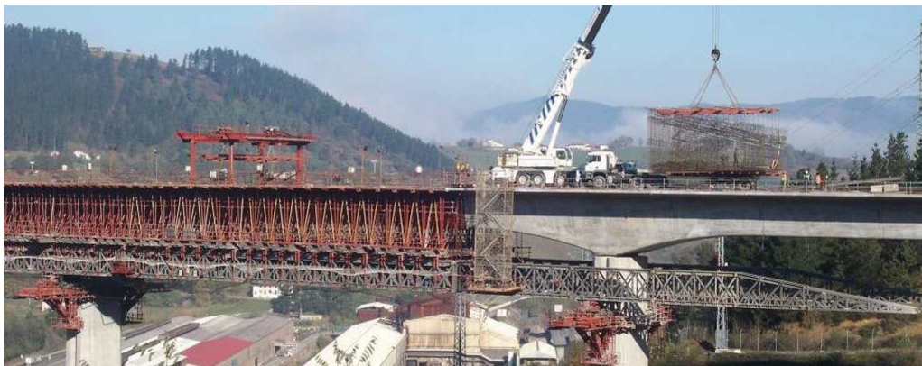
Figura 29. Vista de colocación de ferralla prearmada sobre el tablero.
