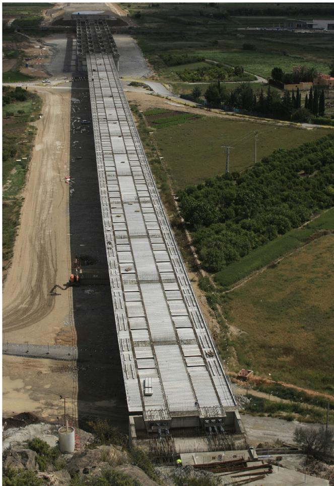
Figura 9. Fotografía Viaducto Callosa-Cox en construcción.
