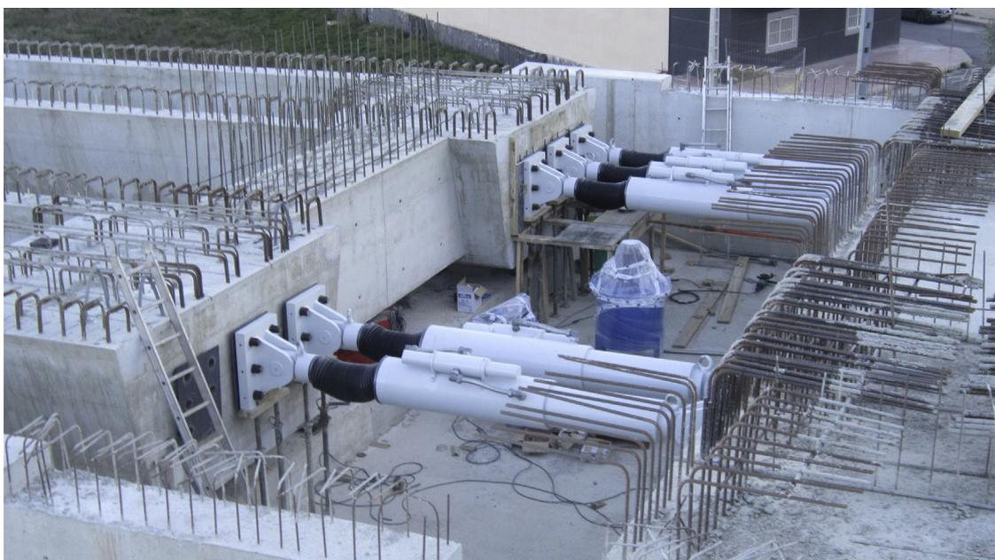
Figura 10. Fotografía detalle dispositivos antisísmicos en Viaducto Callosa-Cox.
