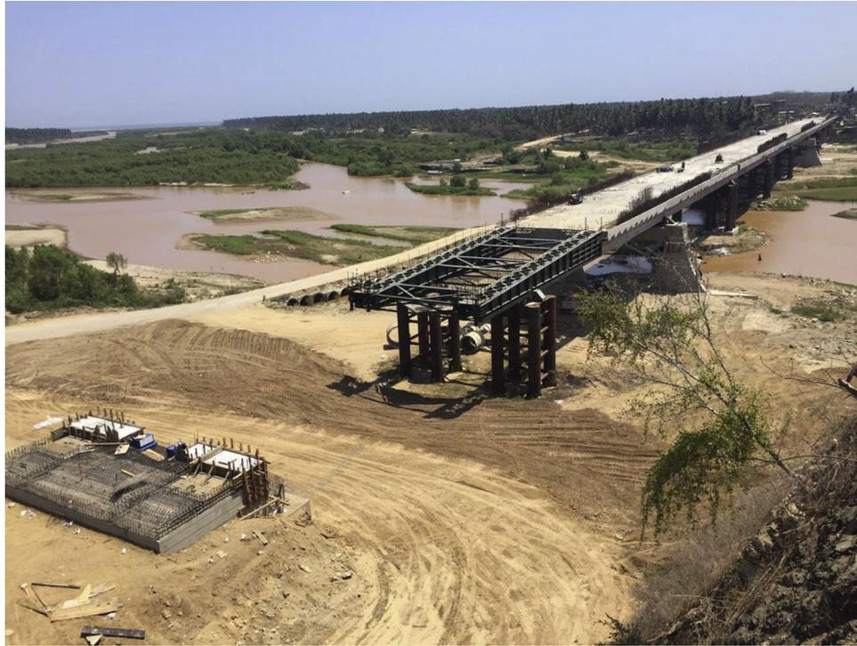
Figura 12. Puente Barra Vieja. Empuje del tablero donde se ven los topes transversales.
