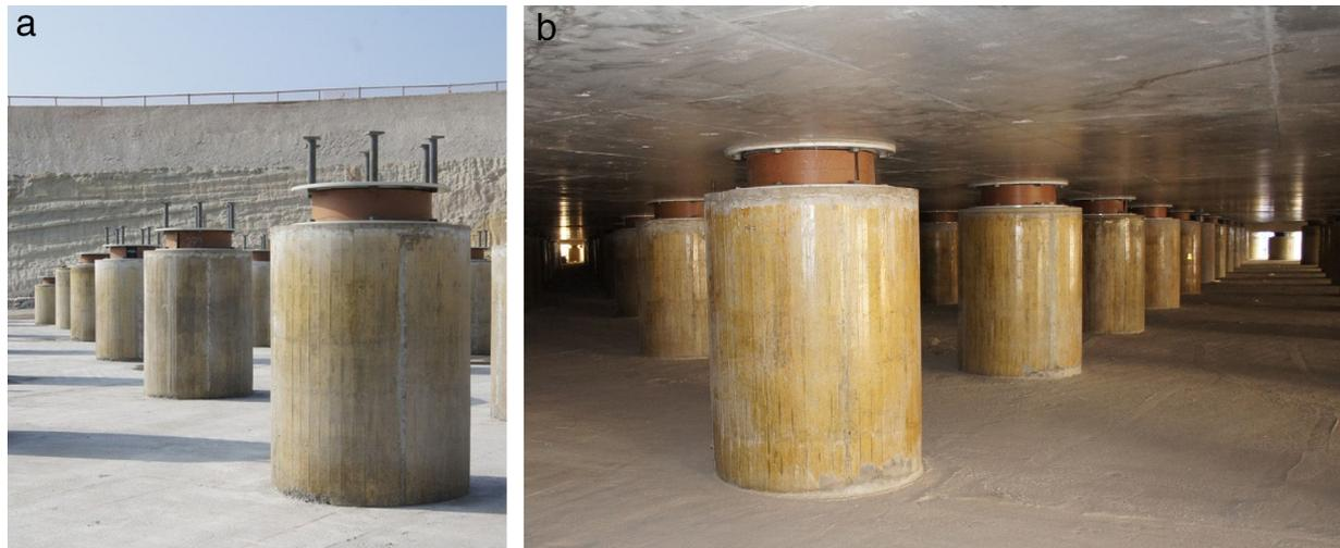
Figura 9. Aisladores sísmicos sobre pedestales de hormigón, antes y después del hormigonado de la losa superior.
