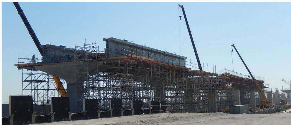
Figura 4. Vano cimbrado isostático de ancho variable.
