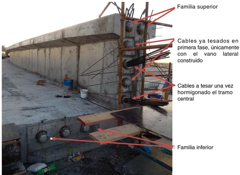
Figura 13. Cables desde extremo del puente.
