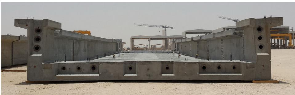
Figura 2. Sección transversal en U para vanos prefabricados.
