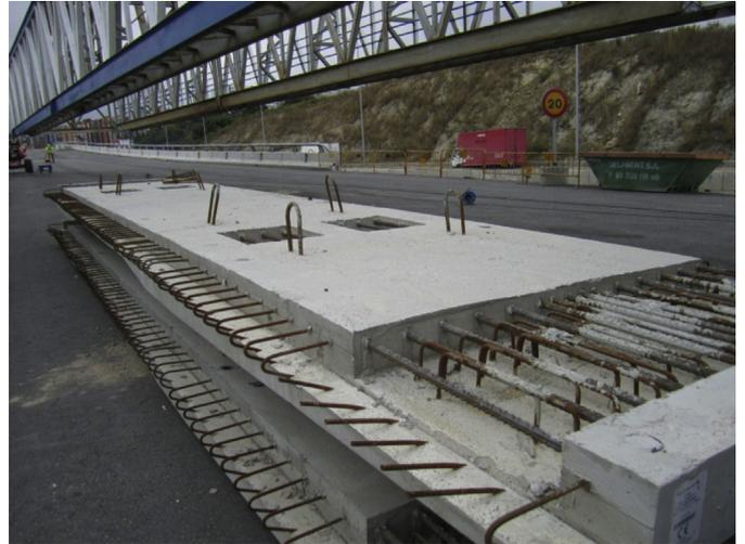
Figura 12. Losas prefabricadas de tablero.
