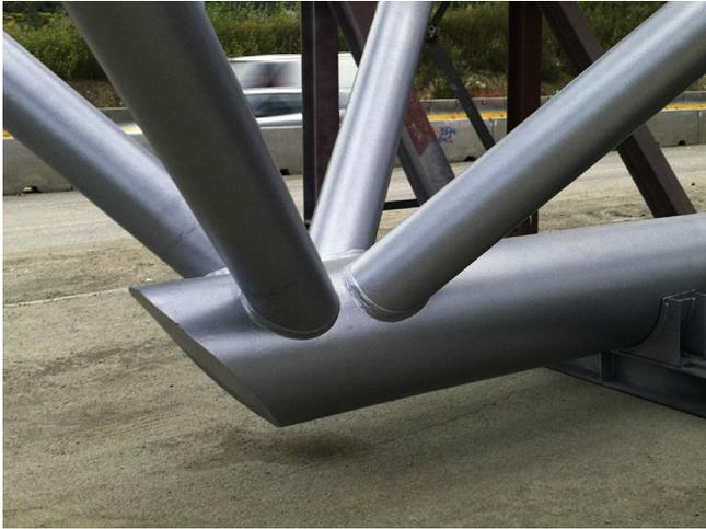
Figura 9. Nudo en uno de los extremos del cordón inferior de una celosía.
