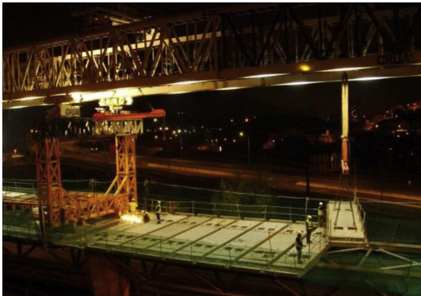
Figura 26. Montaje de losas prefabricadas con el lanzador.
