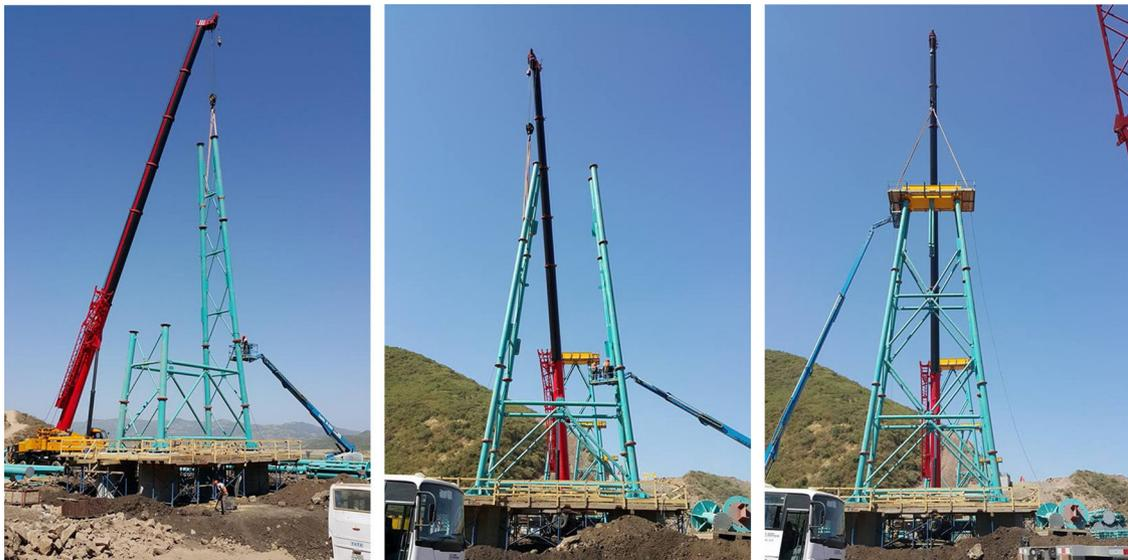
Figura 3. Montaje de las pilas in situ.
