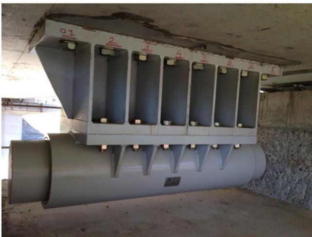
Figura 8. Ejemplo de dispositivo sísmico tipo PDS.
