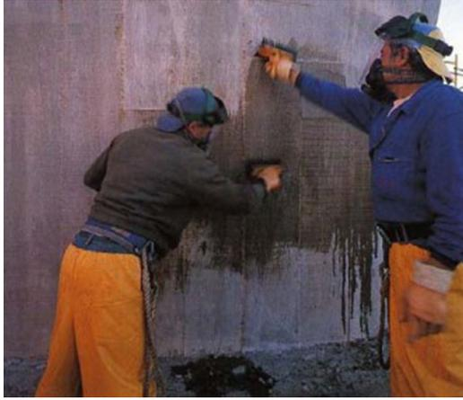
Figura 9. Limpieza final del hormigón.
