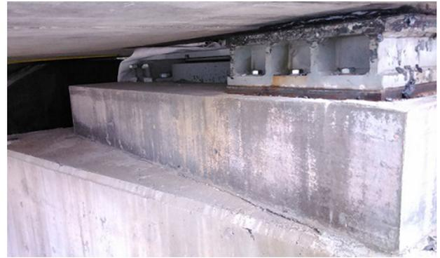
Figura 5. Detalle de chapas bajo apoyo temporal.
