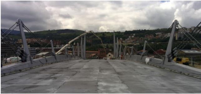
Figura 50. Hormigonado de la losa.
