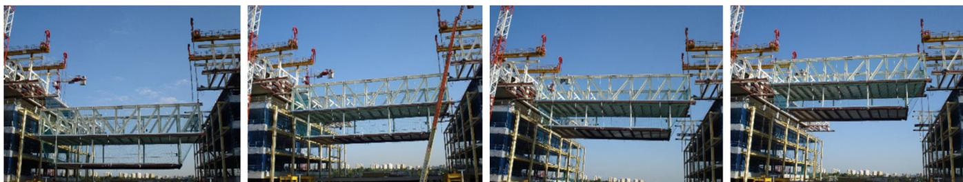
Figura 34. Izado de puente sur.
