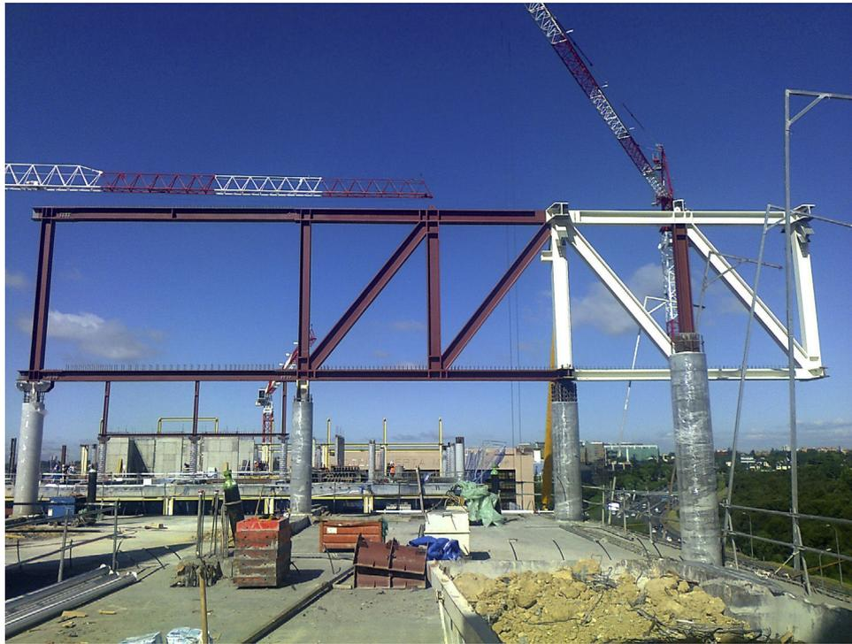
Figura 32. Montaje de celosías sobre soportes mixtos.
