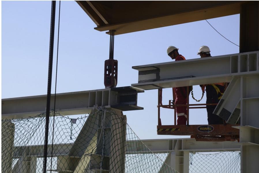
Figura 35. Unión a ejecutar en obra mediante cubrejuntas soldados.
