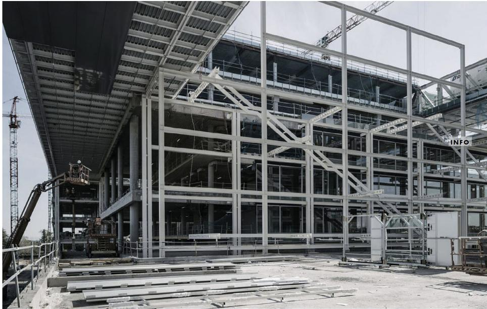
Figura 21. Estructura metálica exterior y escaleras de evacuación.
