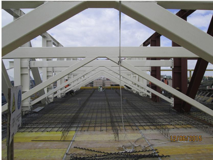
Figura 25. Bancadas integradas en la estructura de cubierta.
