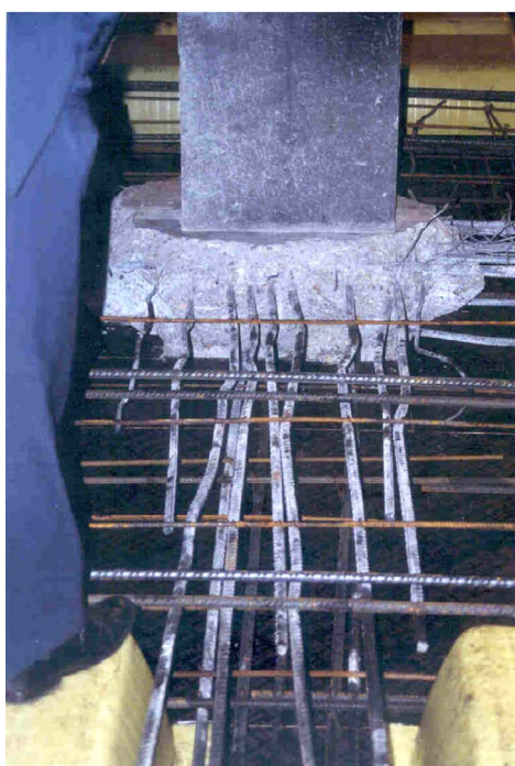
Demolición en el entorno del soporte. Se están dejando en los bordes superficies inclinadas descendentes alejándose del pilar.
