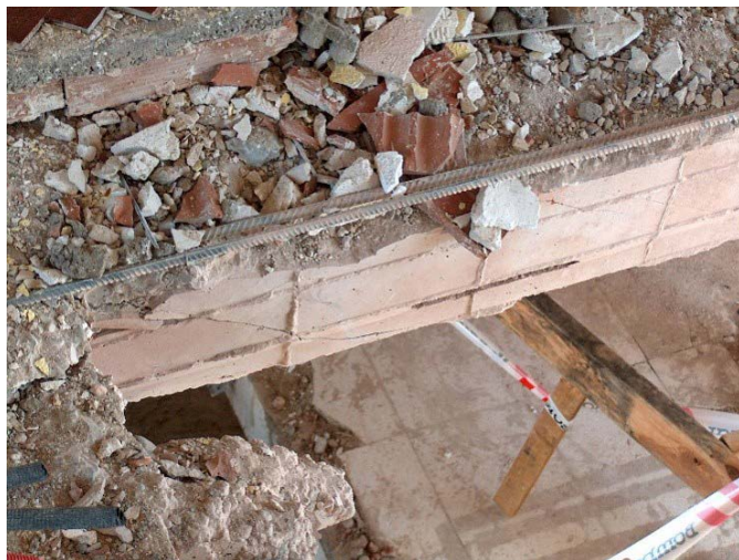
Figura 10. Colapso por inversión de esfuerzos en forjado de techo sobre el foco de la explosión (Edif. C/ Martín Gaité, Leganés (Madrid), 2004).
