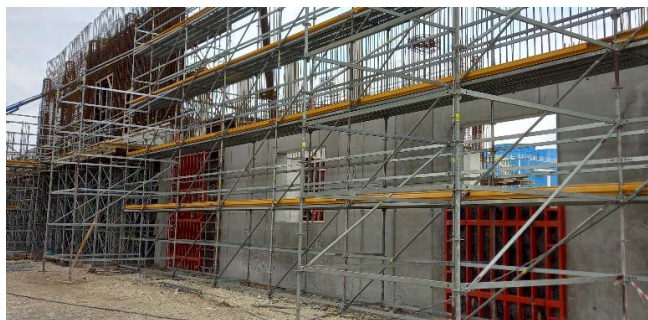
Figura 10. Subestación eléctrica “in situ” durante la fase de ejecución. Se aprecian los medios auxiliares y los distintos niveles de hormigonado para la construcción de huecos.
