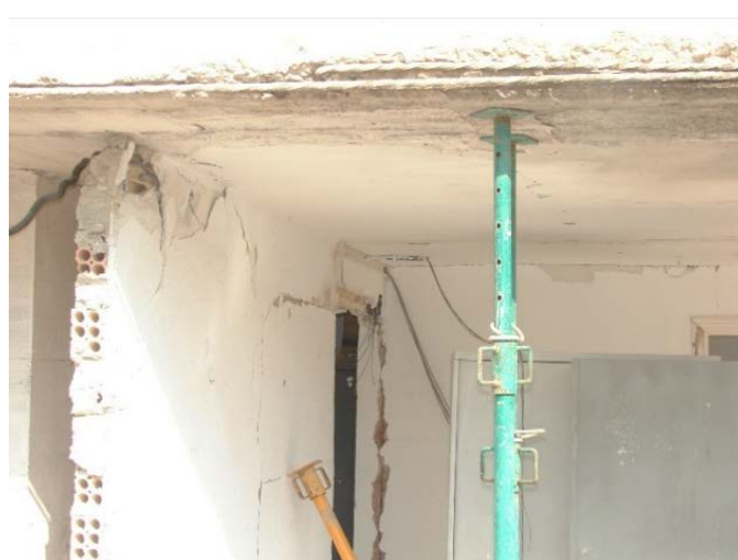
Desconchones en el hormigón.
