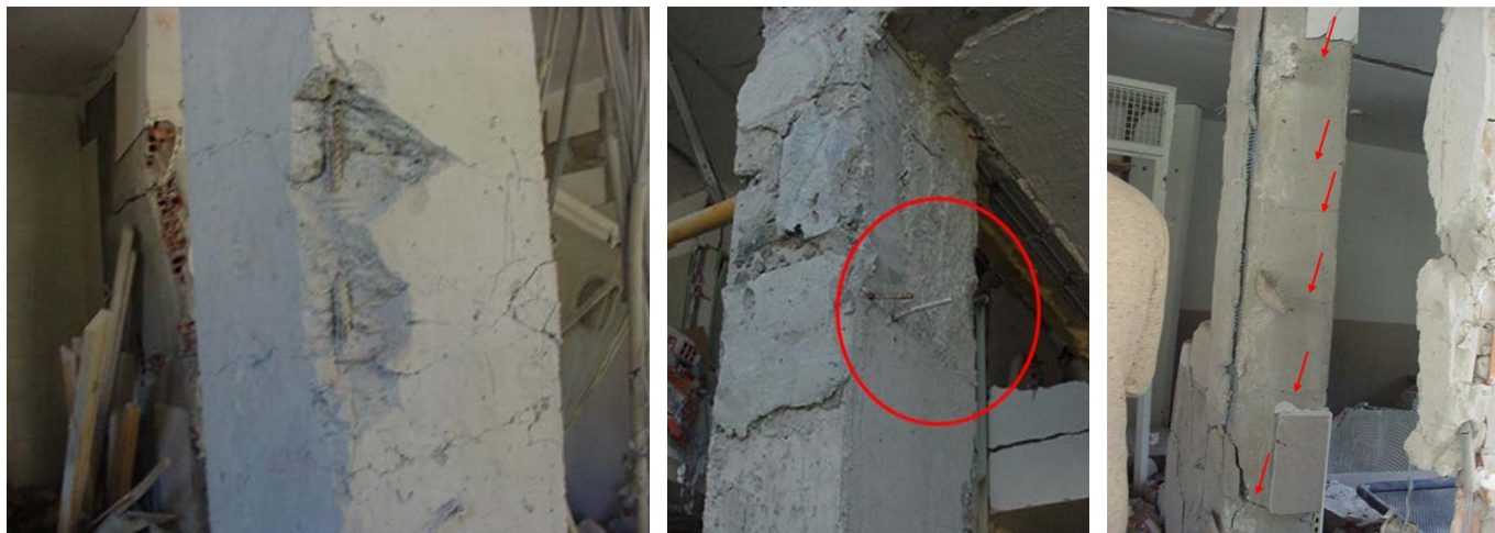
Fisuración por flexión en un pilar (fotografía superior izquierda) en un soporte al que el cerramiento estaba referido con llaves ancladas a los soportes.
