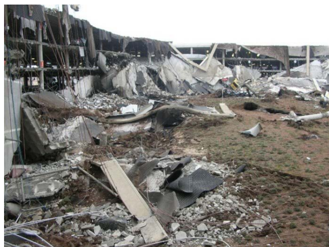
Figura 14. Colapso progresivo en un edificio de aparcamiento tras la explosión (Aparcamiento de Barajas, Madrid, 2006).
