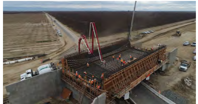
Figura 2. Trabajos de hormigonado de la losa inferior del tablero del puente isostático de un vano.
