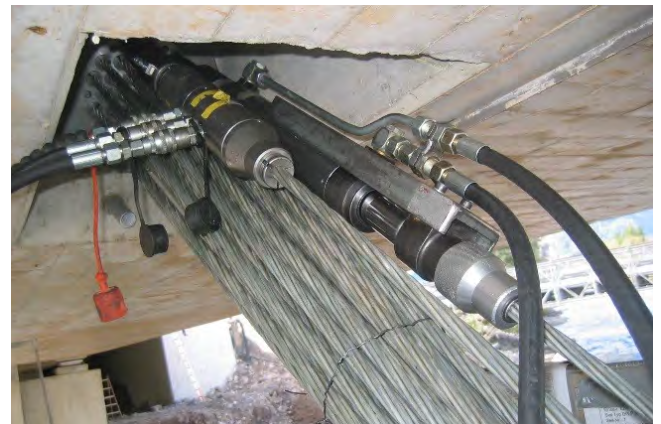
Figura 2. Sistema de tesado ConTen®.
