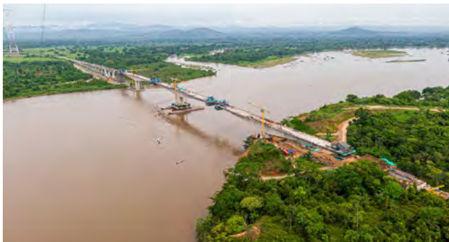
Figura 1. Vista aérea del puente sobre el Río Magdalena en construcción.
