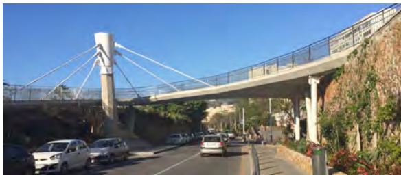
Figura 2. Vista de la pasarela desde la vía inferior.
