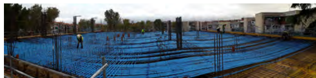
Figura 2. Vista trazado tendones monocordón en losa de 60cm para apeo de pilares sobre polideportivo.
