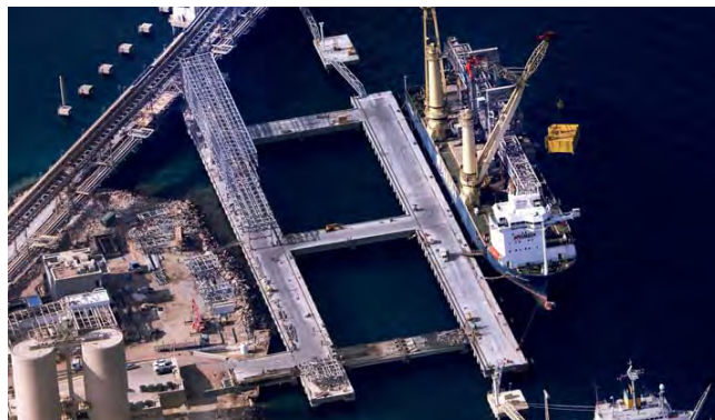
Figura 1. Vista general del muelle durante su construcción.
