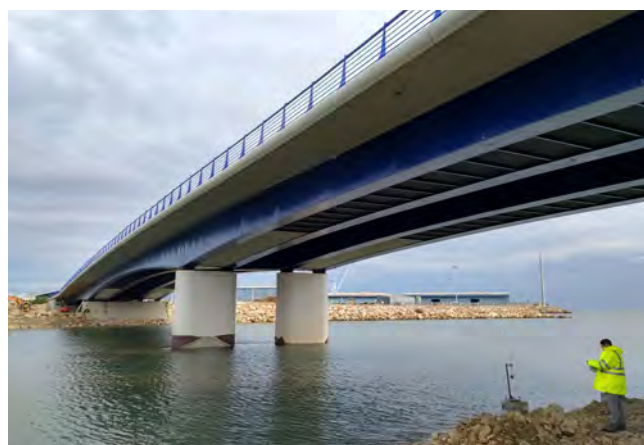
Figura 1. Vista del viaducto construido.
