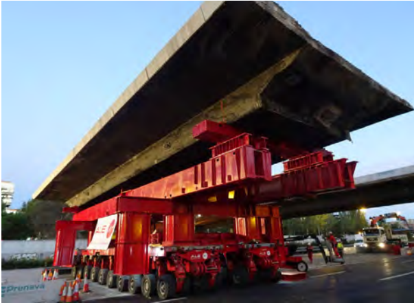
Figura 1. Maniobra de retirada Vano Sur
