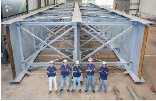
Figura 1. Vista de la estructura metálica del puente Oxec durante su construcción en taller.
