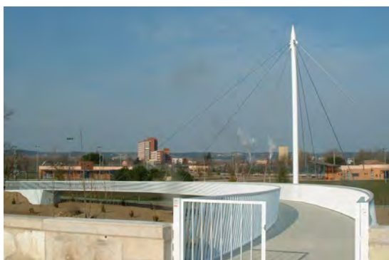
Figura 2. Pasarela de San Juan de la Cruz sobre el río Carrión, Palencia. (Cortesía de FHECOR).
