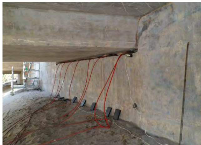
Figura 1. Vista de estribo, gatos hidráulicos instalados para maniobra de sustitución de apoyos.
