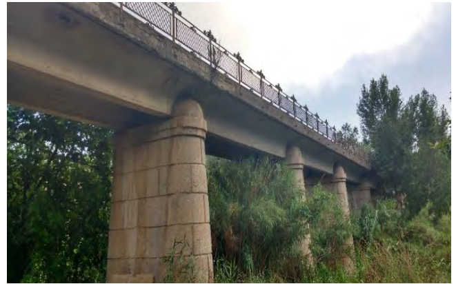
Figura 1. Vista general del puente estudiado.
