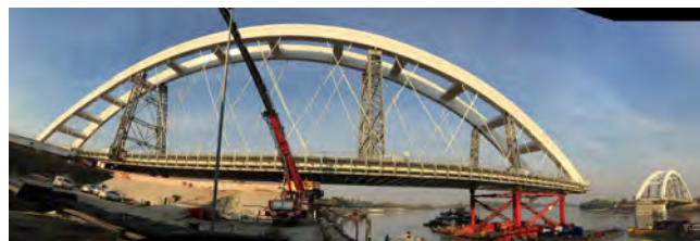
Figura 2. Vista del puente durante el empuje del segundo arco.
