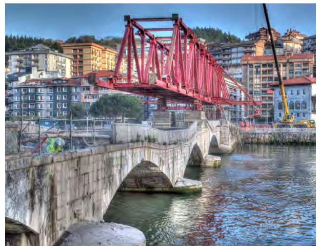
Figura 1. Vista del puente en fase de lanzamiento de cimbra.
