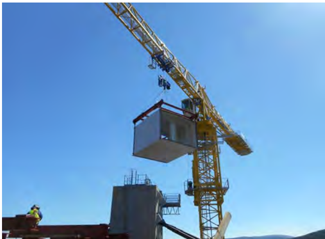
Figura 1. Izado de una de las piezas que forma parte del dintel.
