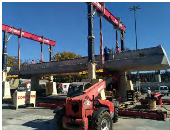
Figura 1. Izado de uno de los dinteles prefabricados.
