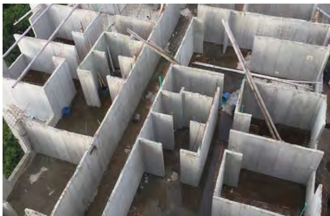
Figura 2. Edificación de MDCR de la base de datos.
