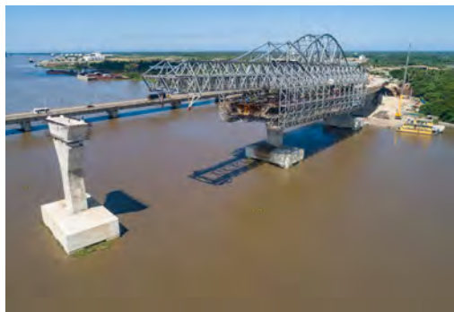
Figura 1. Vista de los viaductos de acceso en construcción (foto: David Ruiz).
