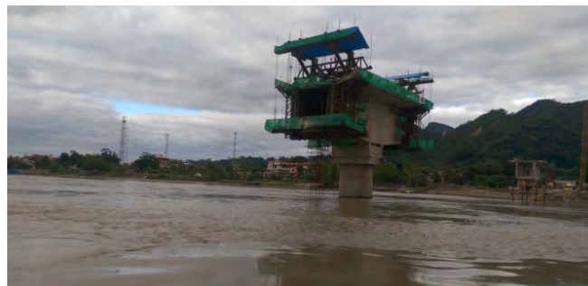
Figura 2. Vista dovelas "1" P3.
