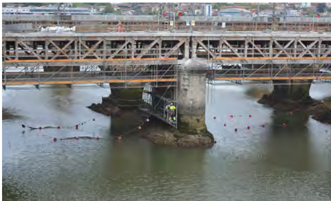
Figura 2. Montaje de andamios para inicio de trabajos de rehabilitación.
