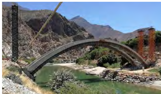
Figura 1. Cimbra del puente de Chacanto. L=100 m.
