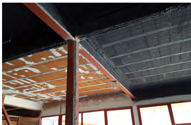
Figura 2. Refuerzo de pilares con estructura metálica en edificio 2.
