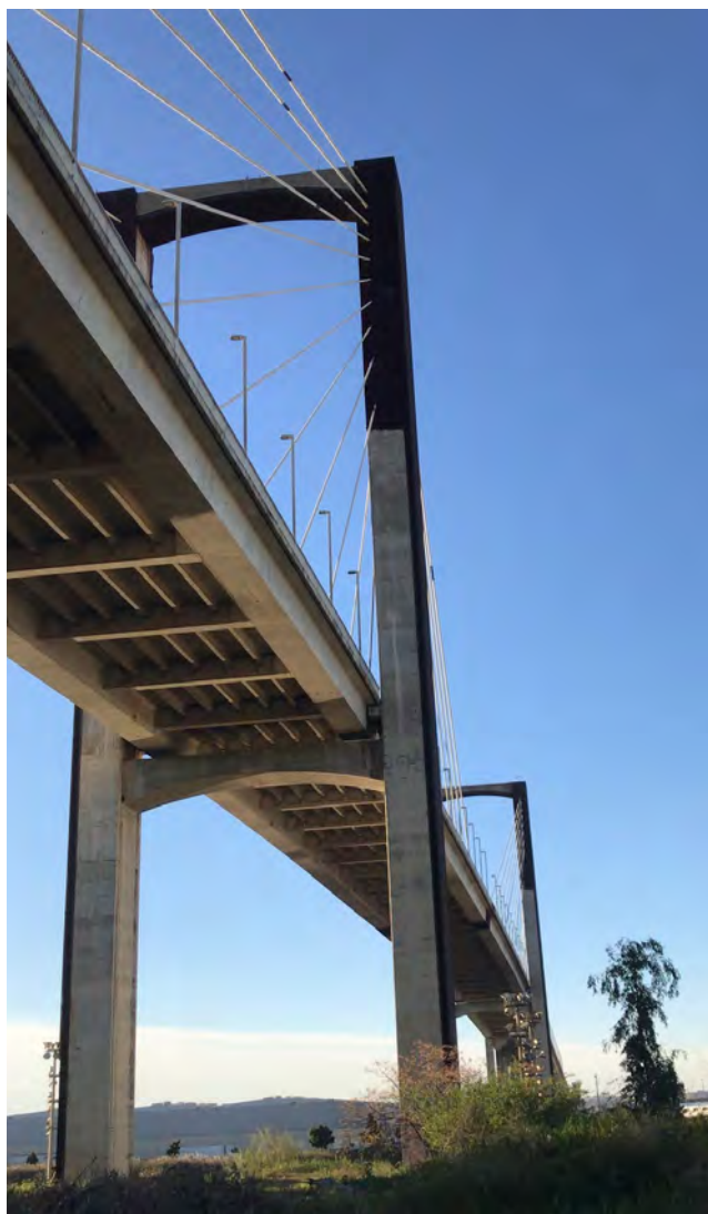
Figura 1. Vista del Puente del Centenario desde la pila intermedia.
