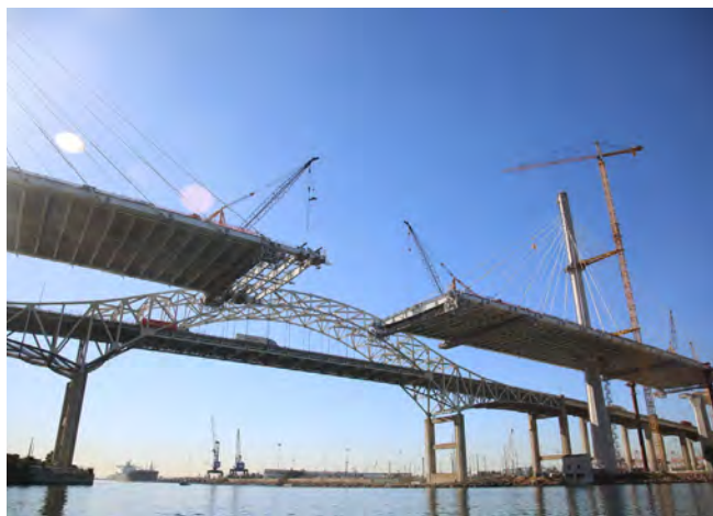
Figura 2. Nuevo puente de Gerarald Desmond en construcción junto a puente existente.
