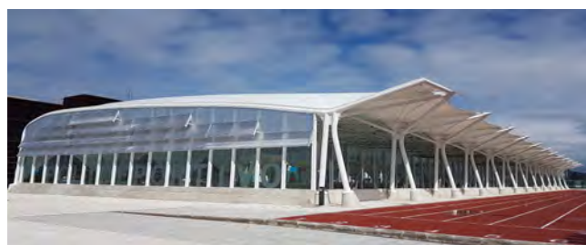
Figura 2. Vista de fachada sur.
