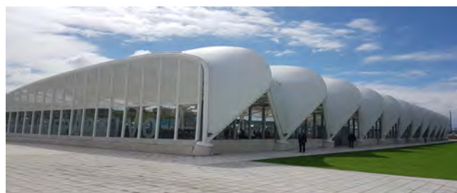
Figura 1. Vista de fachada norte.
