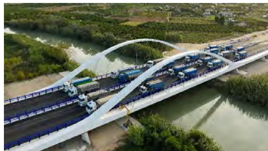
Figura 1. V-22 Durante la ejecución de la prueba de carga.
