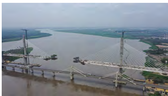
Figura 2. Vista del tramo atirantado en construcción (foto: David Ruiz).
