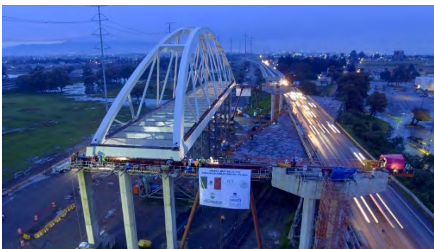
Figura 2. Vista de la obra. Viaducto en construcción.
