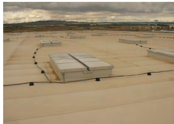
Figura 1. Vista general de la nave.
