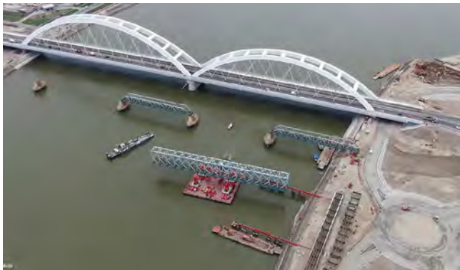
Figura 1. Vista área durante maniobra de navegación de vano de 102 m.
