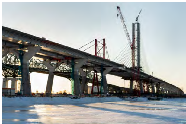
Figura 2. Proceso constructivo Mainspan. Cierre con torre de atirantamiento provisional.
