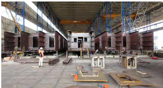
Figura 1 Vista de los cajones principales del tablero durante su fabricación en taller.
