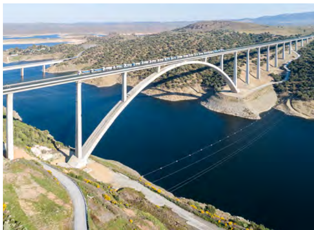
Figura 1. Viaducto sobre el Río Tajo durante la Prueba de Carga.
