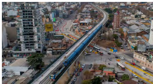
Figura 2. Vista general del viaducto.
