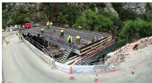
Figura 2. Armado del tablero previo al hormigonado.
