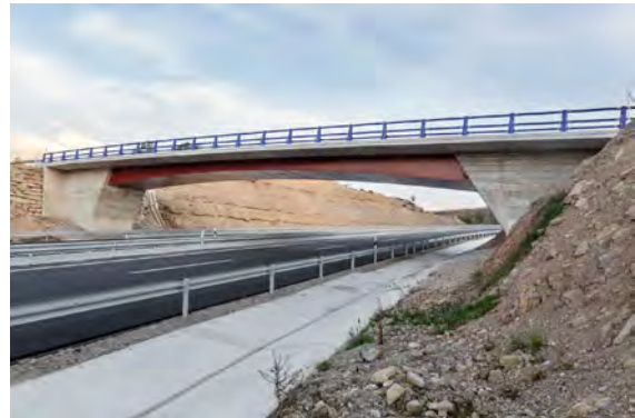
Figura 1. Vista general del paso superior.
