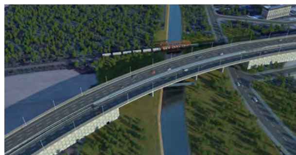
Figura 2. Puente de la Refinería.
