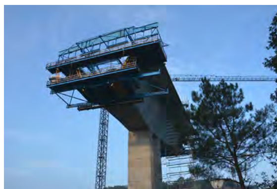
Figura 2. Vista de la construcción en voladizo con carros de avance.
