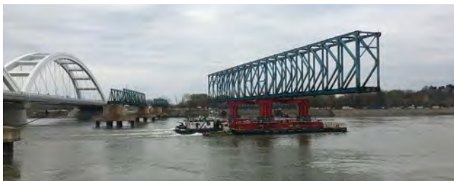
Figura 2. Vista de pontona y sistema de gatos durante maniobra de navegación de vano de 102 m.
