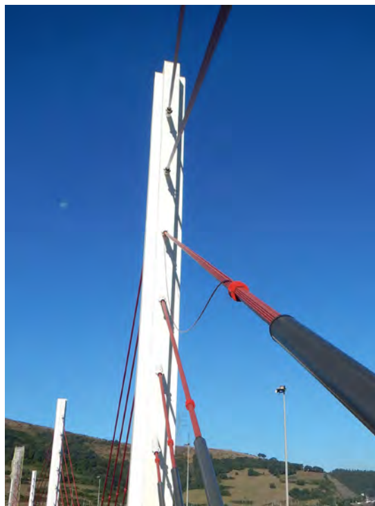
Figura 1. Vista general - Estado inicial.
