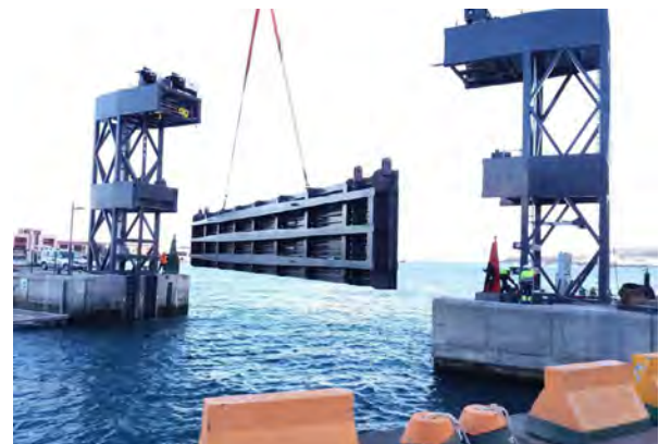
Figura 1. Alzado de la Compuerta y Torres de Cuelgue durante el montaje.
