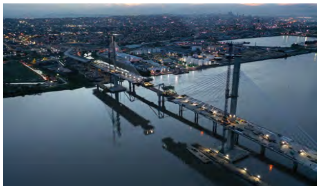
Figura 1. Vista del viaducto en construcción (foto: David Ruiz).
