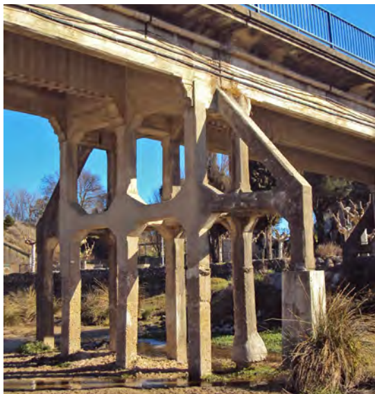
Figura 2. Vista de una pila.
