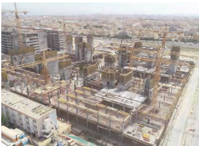
Figura 2. Ejecución de la obra..
