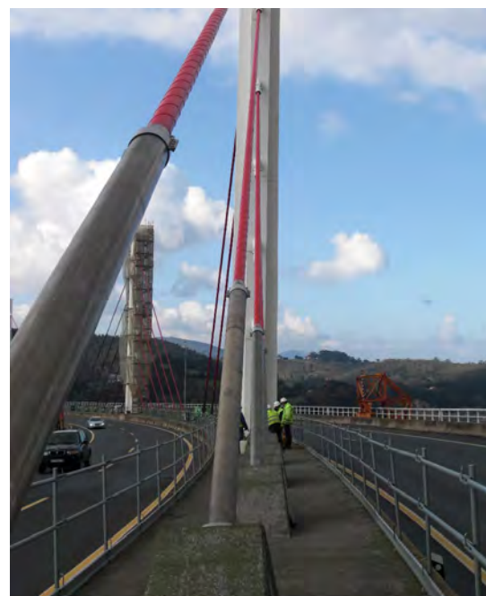
Figura 2. Vista general - Estado final.
