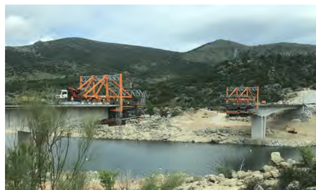
Figura 1. Construcción por avance en voladizo del vano central.
