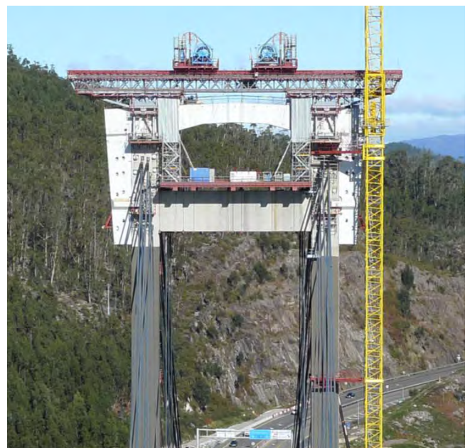
Figura 1. Pórtico para izado de cabecero de mástil.
