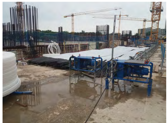
Figura 2. Zona de prefabricación y acopio.
