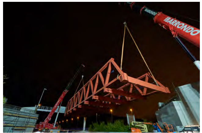
Figura 1. Montaje del Paso Superior sobre la VSM de Bilbao.
