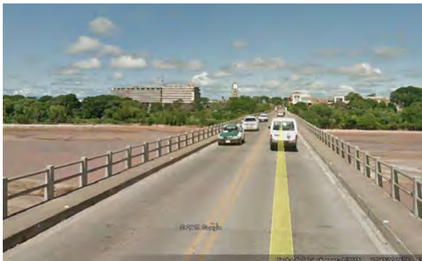
Figura 1. Vista del puente Foianini, único puente existente en la actualidad.
