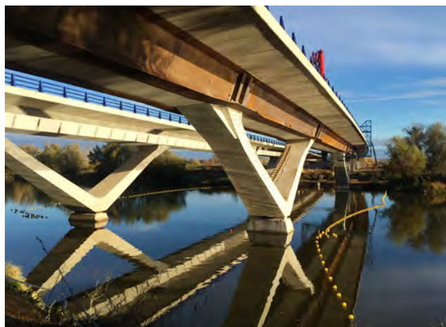
Figura 2. Vista general de estructura donde se puede observar el aspecto del cajón actual, con el nuevo alma metálica. A la izquierda, estructura original sin reforzar.
