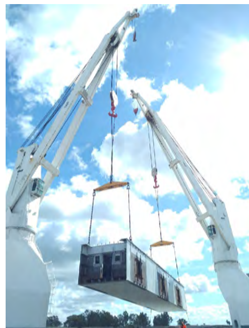
Figura 2. Carga en barco mediante dos grúas de un elemento del tablero en el Puerto de Sevilla. Empleo de pescantes y cáncamos. (Fotografía de los autores).
