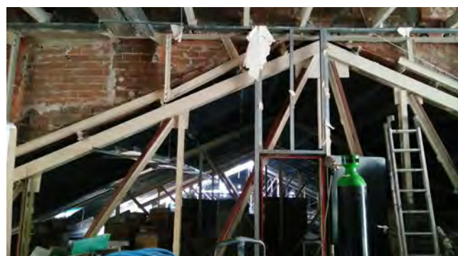
Figura 2. Cercha en cubierta con refuerzos.
