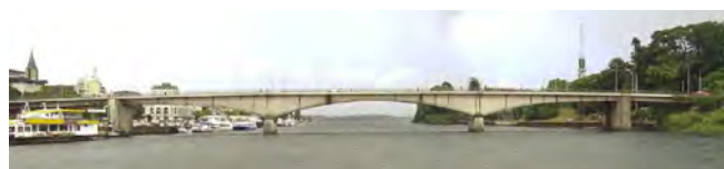
Figura 1. Panorámica Puente Pedro Valdivia. Situación actual.
