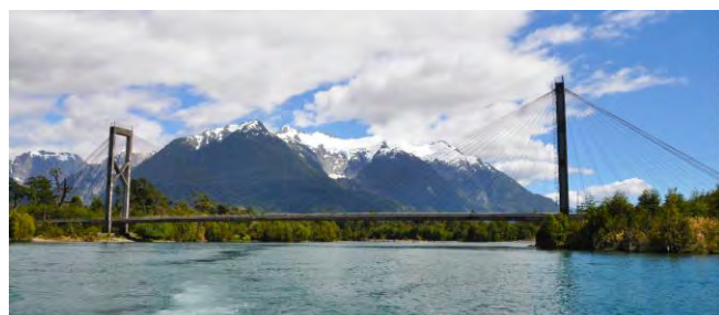
Figura 1. Vista del Puente Yelcho.
