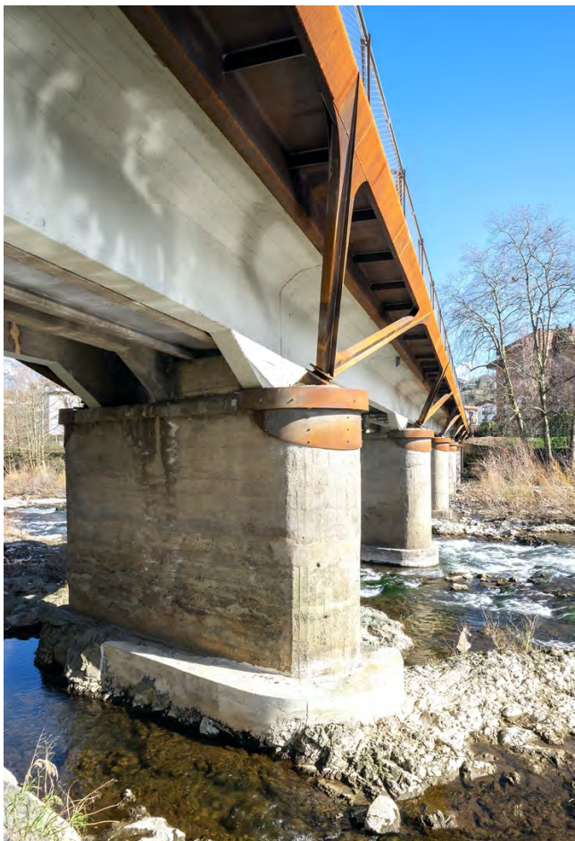
Figura 2. Vista inferior de la ampliación.
