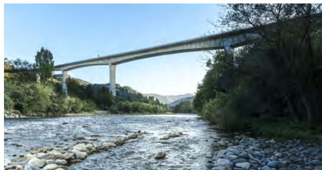
Figura 2. Vista desde el cauce.
