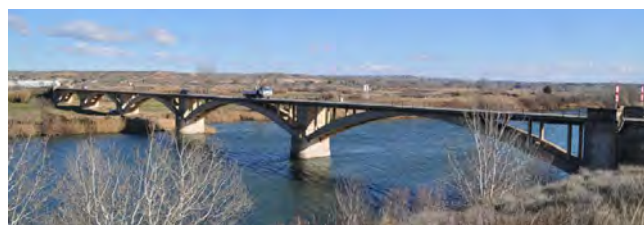
Figura 1. Vista del puente antes de la intervención.
