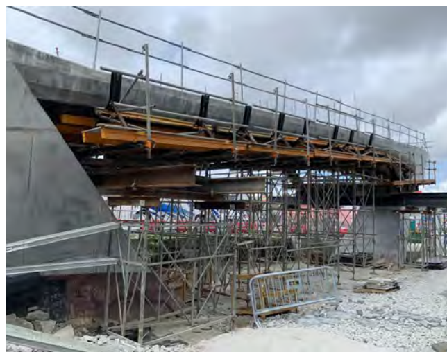
Figura 2. Vista de un vano lateral durante la construcción.
