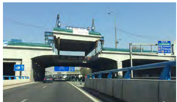
Figura 2. Vano isostático levantado para reparación de apoyos a media madera.
