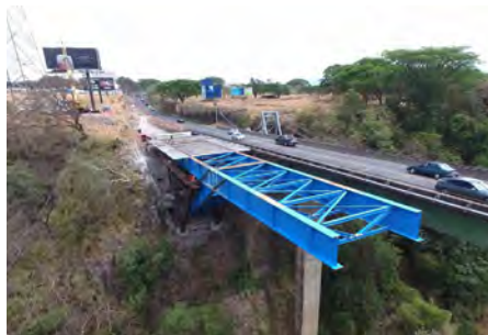
Figura 1. Vista del viaducto en construcción. Tablero completamente lanzado antes de unirse a las pilas inclinadas.
