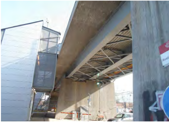
Figura 2. Vista inferior del tablero mixto.
