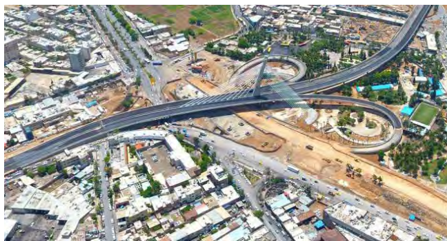
Figura 1. Foto aérea del puente terminado
