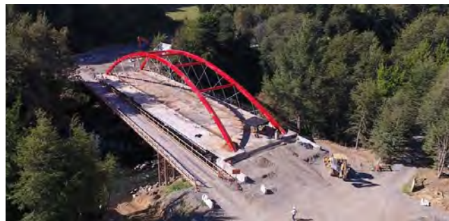
Figura 1. Puente Manchuria en construcción.
