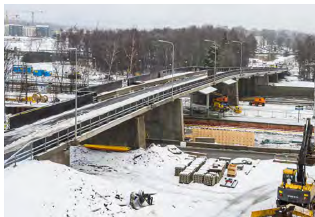
Figura 1. Vista lateral del puente.
