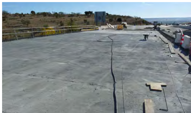
Figura 2. 2 Losas tapadera sobre los rellenos de suelo reforzado en los viaductos de Hocecillas I y II.
