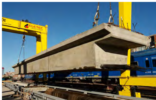
Figura 1. Fabricación de una viga artesa en las instalaciones junto a las vías.
