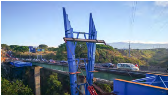
Figura 2. Vista del viaducto en construcción. Construcción vertical de las pilas y mecanismo de abatimiento.
