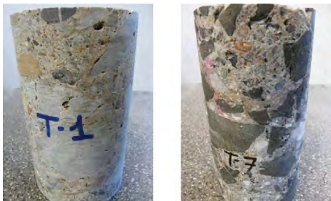
Figura 1. Testigos de hormigón de los muros del dique. Hormigón árido pétreo (izquierda), hormigón con árido de naturaleza heterogénea (derecha).
