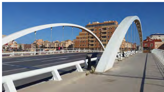
Figura 1. Ejemplo de péndolas articuladas. Puente del cañuelo, España. Fuente: Juan José Jorquera Lucerga.
