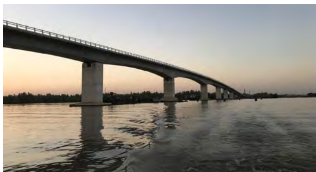
Figura 2. Puente SeneGambia en servicio.
