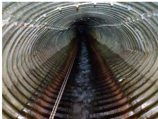
Figura 2. Ovalización de la sección y plastificación de las generatrices horizontales.
