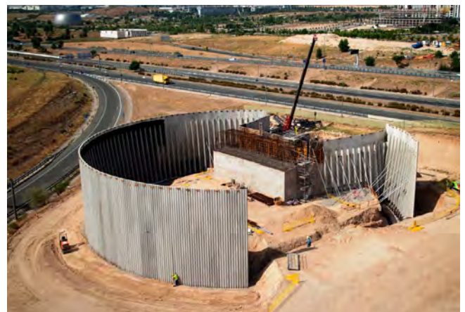
Figura 2. Vista del E-2 del puente singular de Valdebebas sobre la M-12, tras el montaje de los muros de glorieta y falso estribo.
