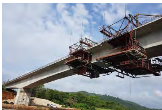
Figura 1. Vista del puente durante construcción.
