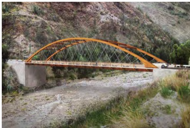
Figura 2. Vista del puente de Urubamba terminado.
