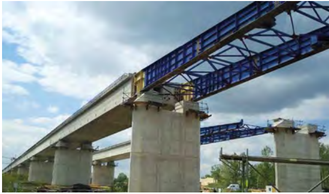
Figura 1. Viga-cajón en fase de empuje.
