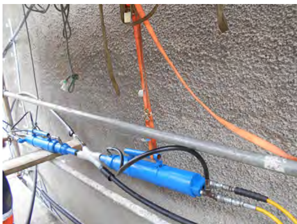
Figura 2. Tesado simultáneo de monocordón con dos gatos.
