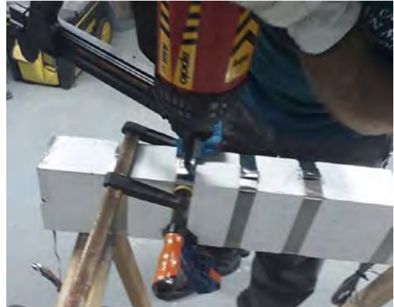
Figura 1. Colocación del refuerzo en las vigas rectangulares.
