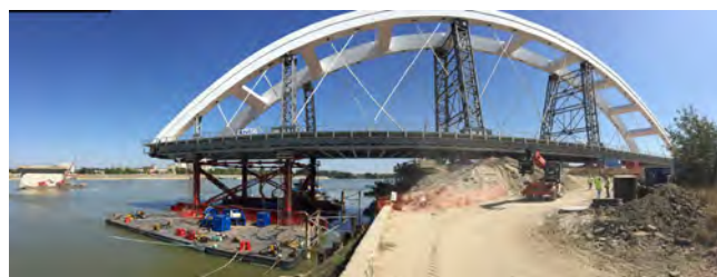
Figura 1. Vista del puente durante el empuje del primer arco.
