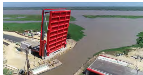
Figura 2. Puente finalizado en posición abierta.
