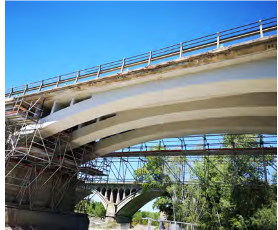
Figura 2. Vista general de arco reforzado y pintado.
