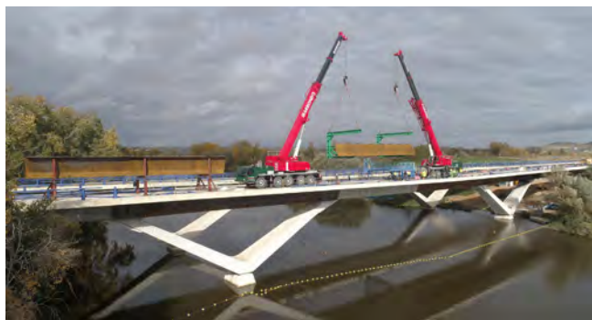
Figura 1. Vista general de la estructura durante una operación de izado y colocación de una pieza metálica.
