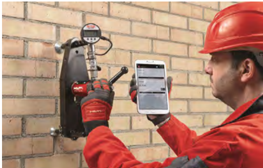
Figura 2. Ensayo en obra de anclajes en mampostería
