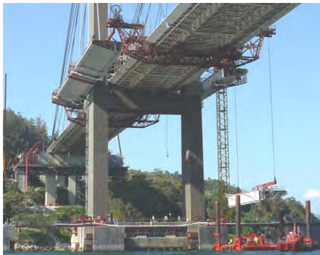
Figura 2. Carros delantero y trasero para izado de dovelas.
