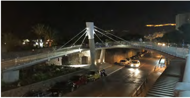
Figura 1. Vista general de la pasarela construida desde Paseo de la Marina.
