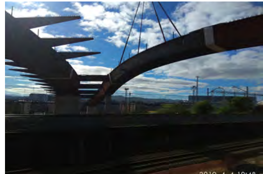
Figura 2. Vista de las riostras entre cajones metálicos.
