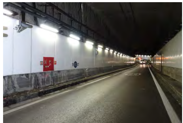
Figura 1. Vista ramal 18RU de los túneles de Calle 30.
