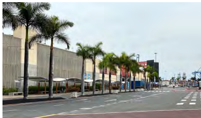
Figura 1. Vista general del muelle y marquesinas.
