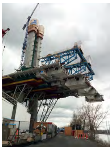
Figura 2. Apoyo de primeras dovelas del Mainspan sobre el delta frame (apeo inclinado).
