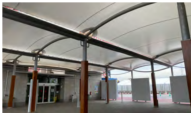
Figura 2. Vista general de la carpa.
