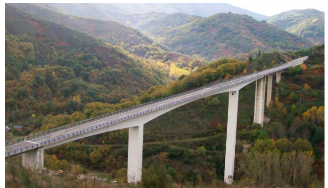
Figura 1. Vista general una vez sustituido el pretil.
