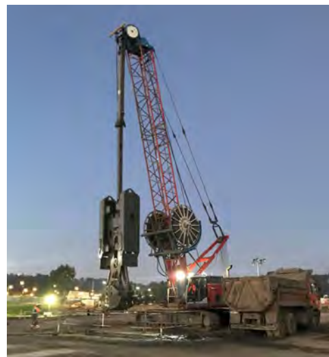
Figura 2. Ejecución de las pantallas del bloque de la torre.
