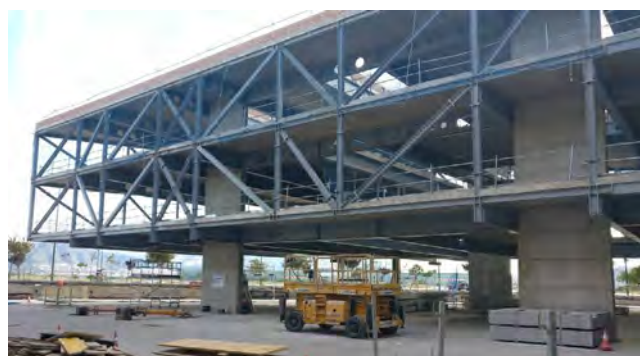
Figura 2. Vista general exterior. Ejecución de la estructura. Estructura mixta de forjados y celosía metálica de fachada en las zonas de grandes vuelos.
