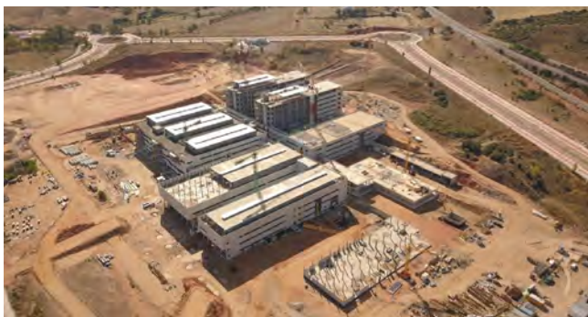
Figura 1. Vista general de la estructura del hospital desde el oeste.
