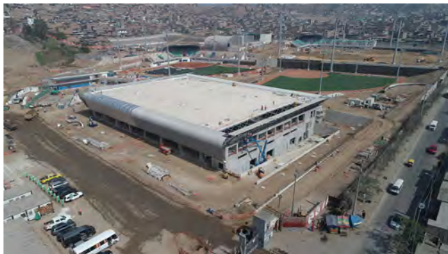
Figura 1. Vista general de la cubierta en fase de construcción.
