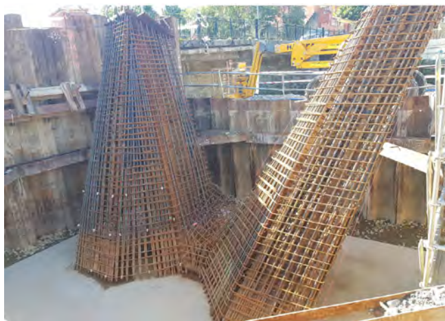
Figura 1. Ferrallado de la pila singular.
