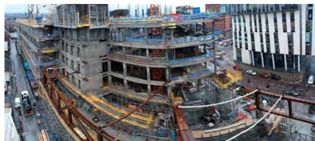
Figura 1. Imagen durante la construcción.
