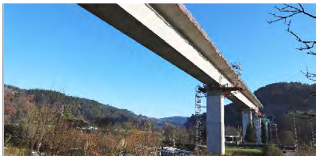
Figura 1. Vista durante el lanzamiento (3).
