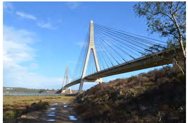
Figura 1. Vista global del puente antes del inicio de los trabajos de rehabilitación.
