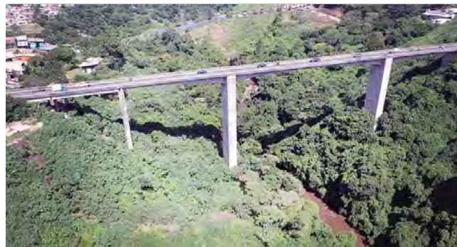
Figura 1. Vista aérea del puente existente.
