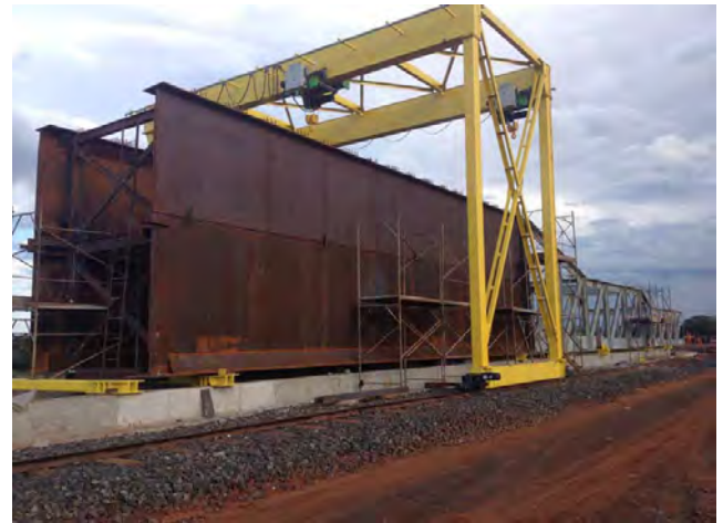
Figura 2. Montaje sección transversal en parque de empuje
