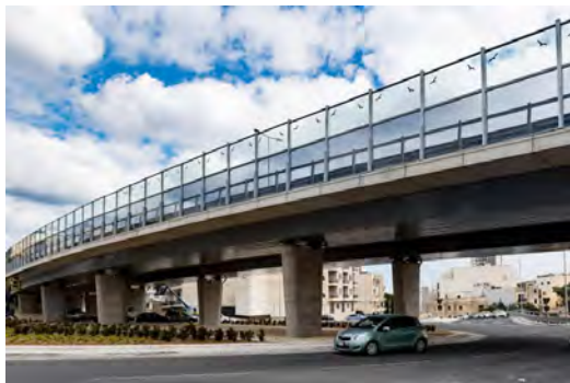
Figura 1. Vista de la obra terminada a su paso sobre la glorieta.
