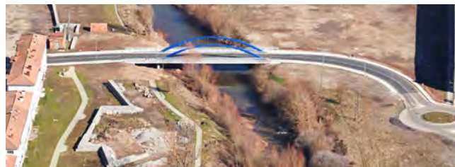
Figura 1. Vista aérea de la estructura terminada.
