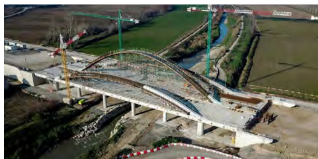
Figura 2. Estado de la construcción.
