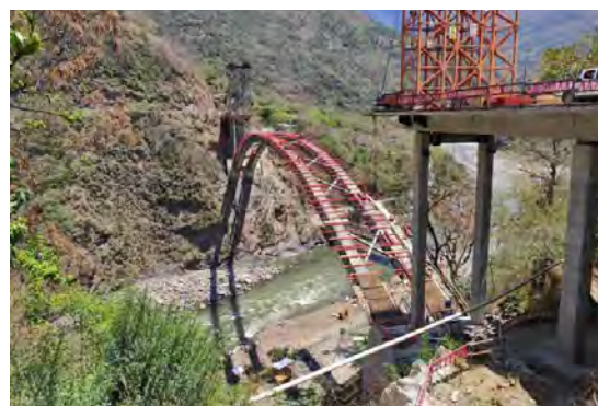
Figura 2. Cimbra del puente Maranura. L=150 m.
