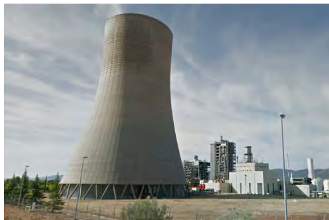
Figura 1. Vistas de la Torre de Gasificación y Torre de Refrigeración a demoler.
