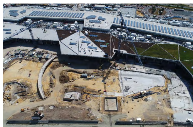
Figura 2. Vista aérea general de las cubiertas Verde y Deck.
