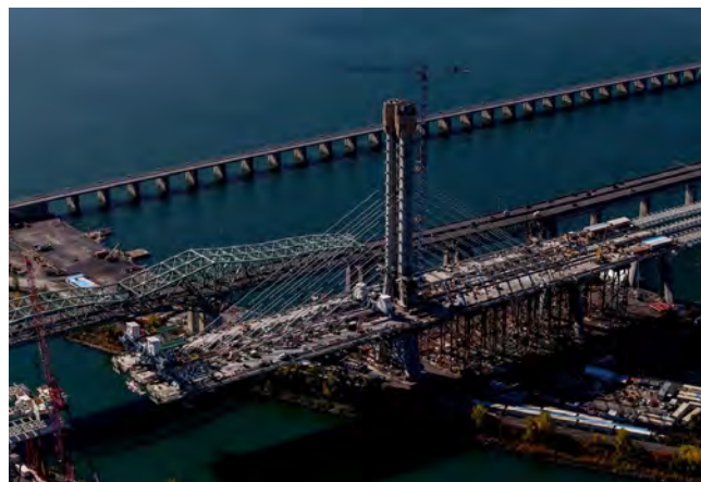
Figura 1. Vista del tramo atirantado en ejecución.
