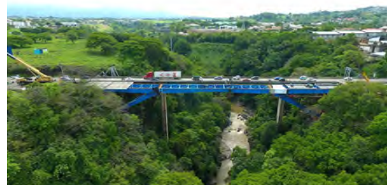
Figura 2. Proceso constructivo del nuevo puente en la RN-147. Tablero metálico terminado.
