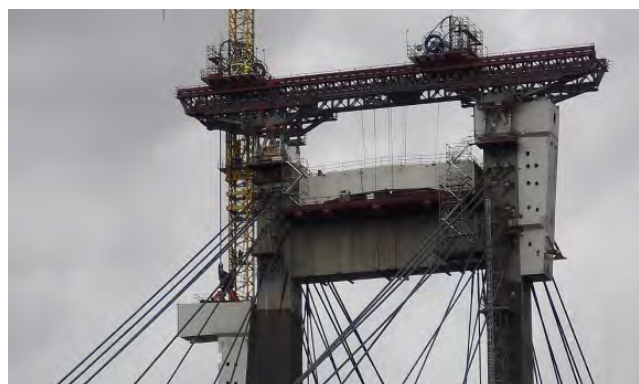
Figura 2. Dovela "0" NE con la grúa torre atravesándola.
