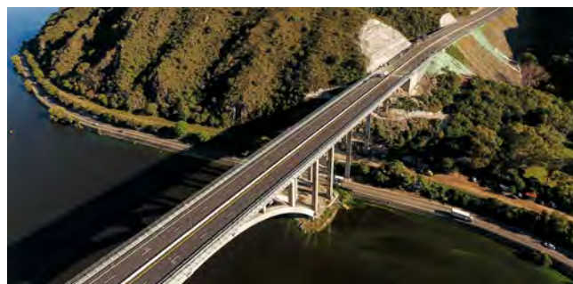
Figura 1. Vista parcial del puente terminado.
