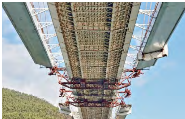
Figura 1. Vista del tablero durante construcción.
