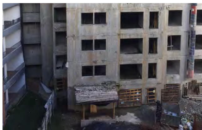
Figura 1. Edificación de MDCR de la base de datos.
