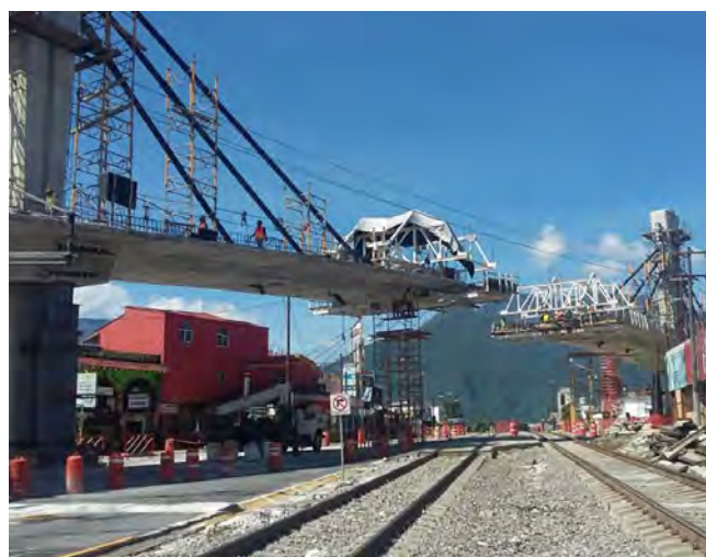
Figura 2. Construcción por voladizos sucesivos del vano principal.
