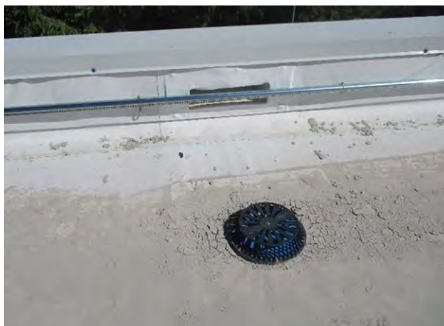
Figura 2. Sistema de drenaje sifónico.
