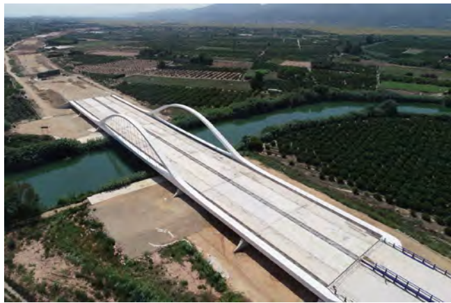
Figura 1: Vista general del viaducto sobre el Río Júcar.
