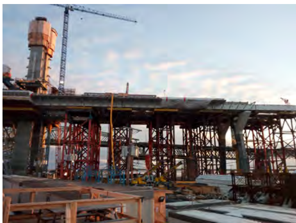
Figura 1. Proceso constructivo Backspan sobre torres de apeo.
