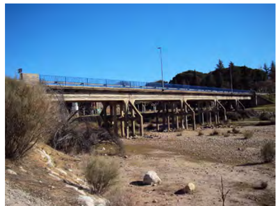
Figura 1. Vista del puente.
