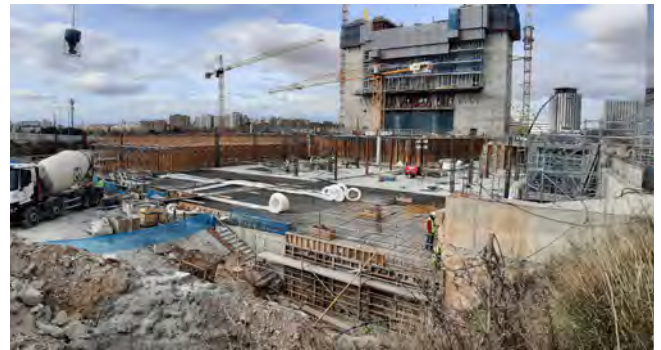
Figura 1. Vista general obra.
