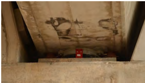
Figura 2. Apoyos pendulares en viaducto sobre el Tránsito Tajo-Segura.
