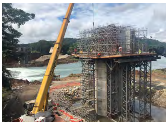
Figura 2. Cimbra para dovelas 0 y 1.
