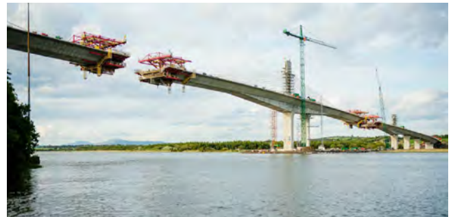
Figura 1. Vista de la construcción, desde el lado Oeste (carro de avance en voladizo).
