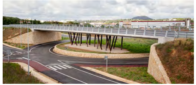
Figura 1. Vista general del paso superior.
