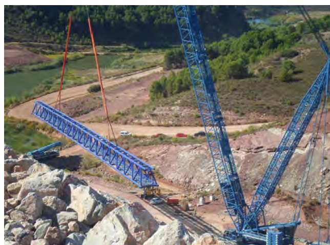
Figura 2. Izado y montaje de la pasarela mediante grúa de cadenas.
