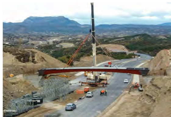
Figura 2. Trabajos de colocación del cajón metálico mediante grúa.
