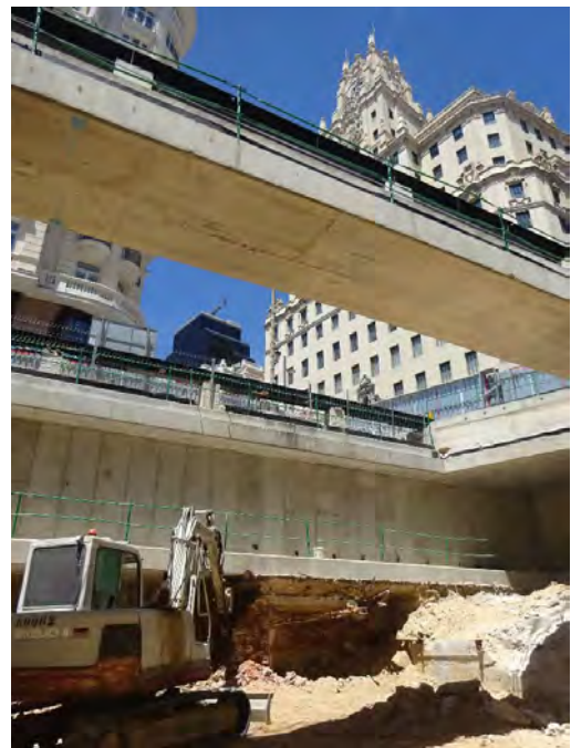
Figura 1. Proceso de excavación y demolición del vestíbulo de 1919.
