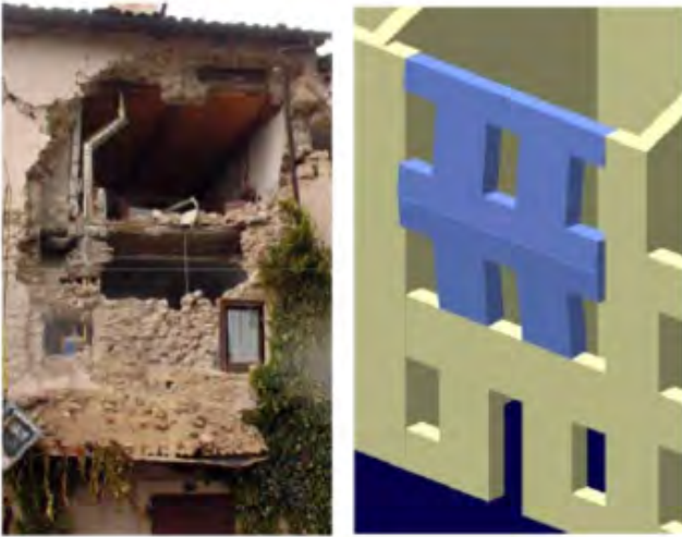
Figura 2. Fallo de fábrica por flexión perpendicular a su plano.
