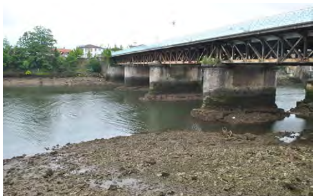
Figura 1. Vista general del puente en bajamar viva antes de la intervención
