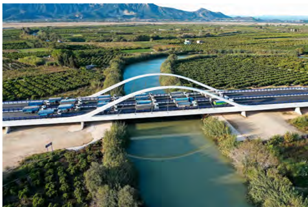
Figura 2. Ejecución de la prueba de carga estática.
