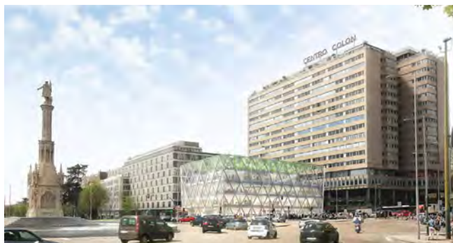
Figura 1. Vista exterior del edificio AXIS.
