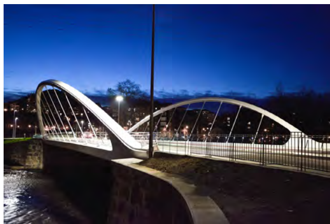
Figura 1. Vista de la obra terminada
