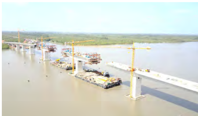
Figura 1. Construcción de la estructura por avance en voladizos sucesivos.
