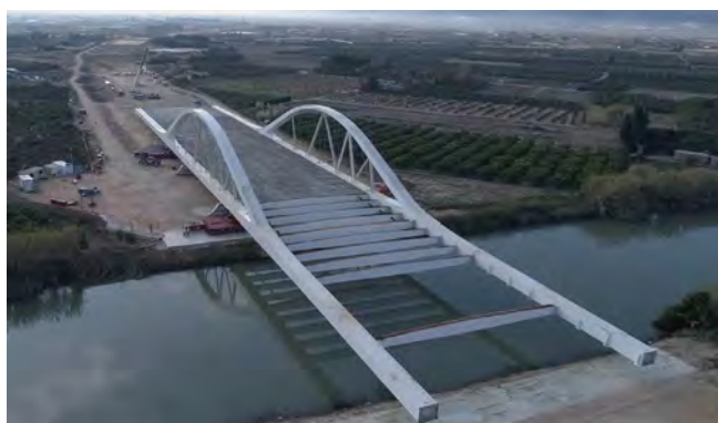
Figura 1. Vista del puente en fase de máximo voladizo.
