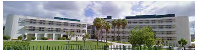
Figura 1. Alzado general del edificio principal del complejo.
