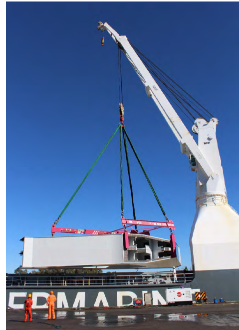
Figura 1. Carga en barco mediante una sola grúa de un cabecero de pila (Fotografía de los autores).
