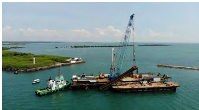
Figura 2. Ejemplo de "tilting table" usada para el izado de las jaulas de armado.
