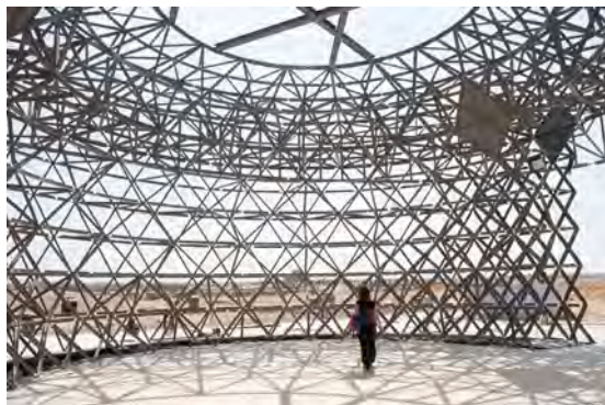
Figura 1. Vista interior del volumen. Reticula estructural triangular metálica.
