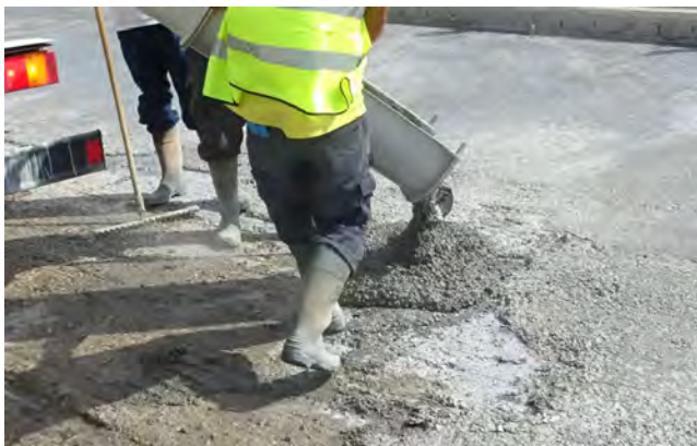
Figura 2: Ejecución de hormigón de refuerzo e impermeabilización.
