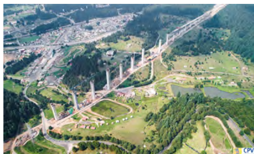
Figura 2. Vista aérea del Viaducto 4 durante la construcción.
