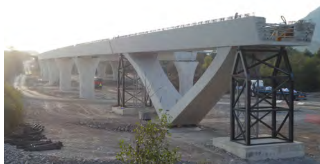
Figura 1. Montaje del Viaducto sobre el Río Aragón-Subordán.
