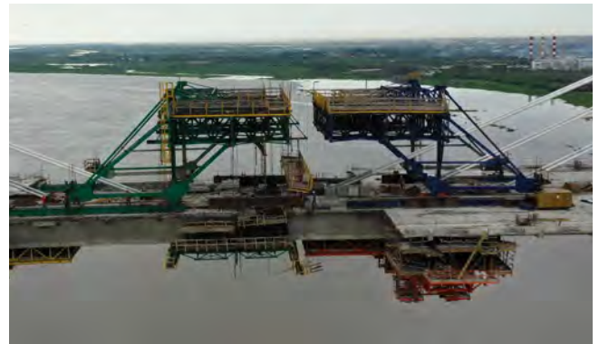
Figura 2. Vigas de continuidad en cierre vano principal.
