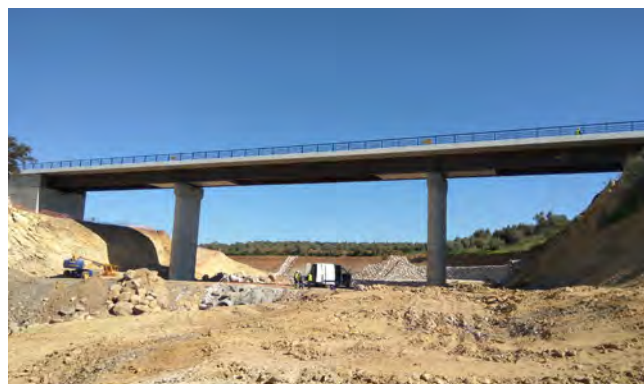
Figura 2. Vista de la estructura terminada.
