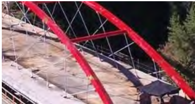
Figura 1. Puente Manchuria en construcción.
