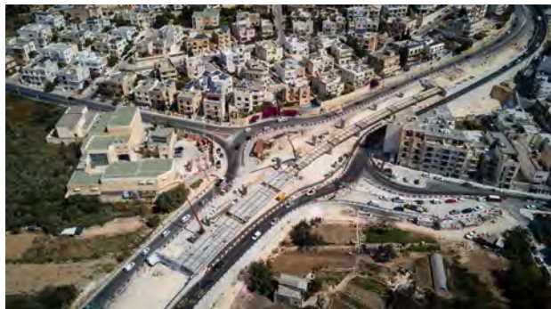
Figura 2. Vista aérea de la construcción del viaducto.
