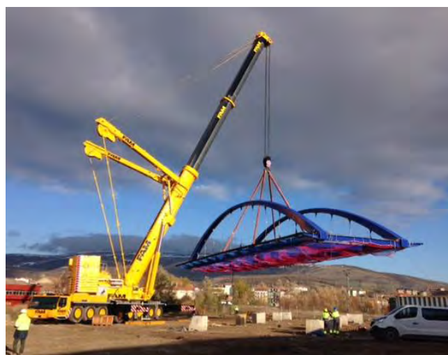
Figura 2. Montaje de estructura metálica mediante grúa (fase 1, grúa de 500 t).
