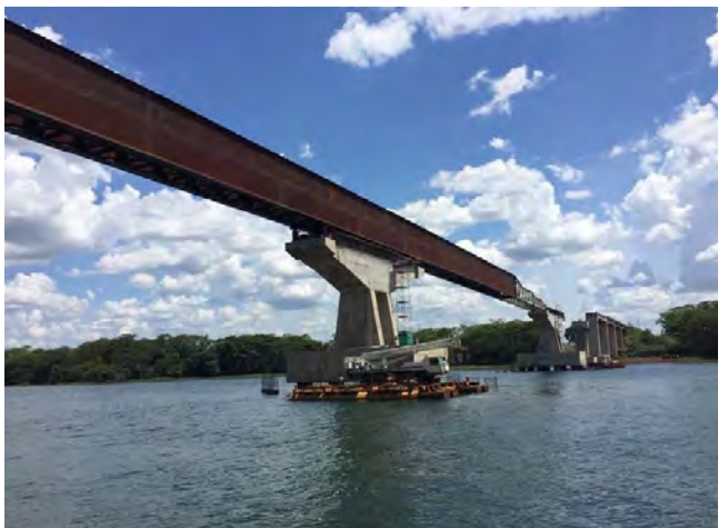
Figura 1. Alzado del puente durante el empuje
