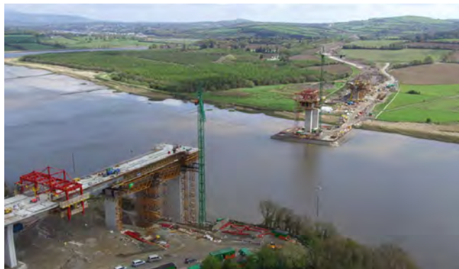
Figura 1. Vista aérea de la construcción, desde el lado Oeste (carro de alas y cimbra en vano 3).
