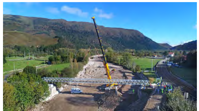
Figura 2. Montaje de la pasarela provisional de Ruento.
