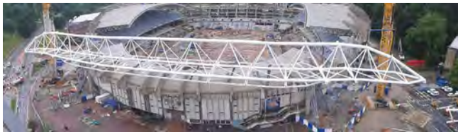
Figura 1. Izado de la cercha Norte.
