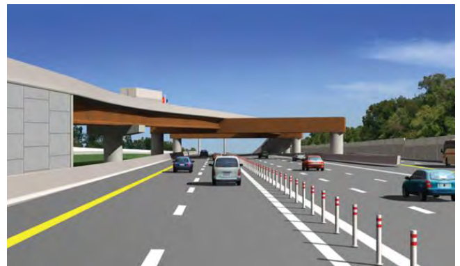
Figura 2. Infografía del diseño conceptual. Puente mixto con pórtico metálico integral.
