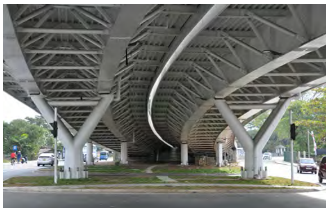
Figura 2. Vista inferior del puente terminado.
