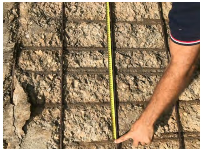
Figura 2. Medición separación barras.
