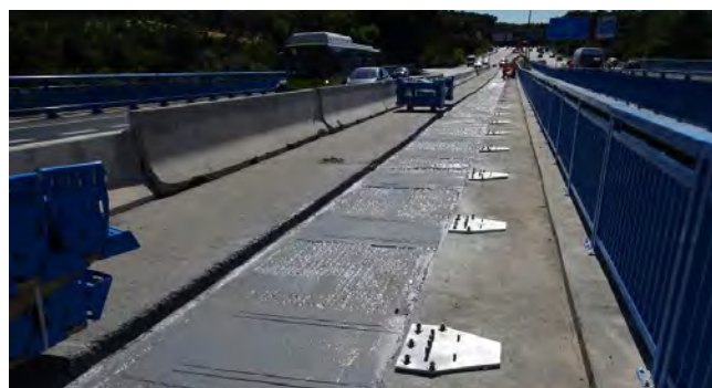
Figura 1. Impermeabilización sobre refuerzos de fibra de carbono mediante poliurea. (Rehabilitación de los puentes de O'Donnell en Madrid; agosto 2018).
