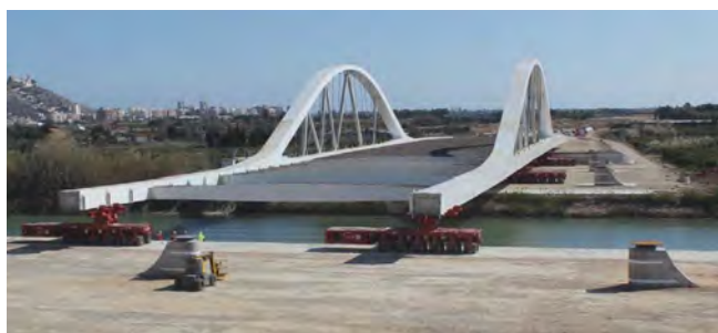
Figura 2. Vista del puente apoyado a ambos lados del río, girado para esquivar las pilas.
