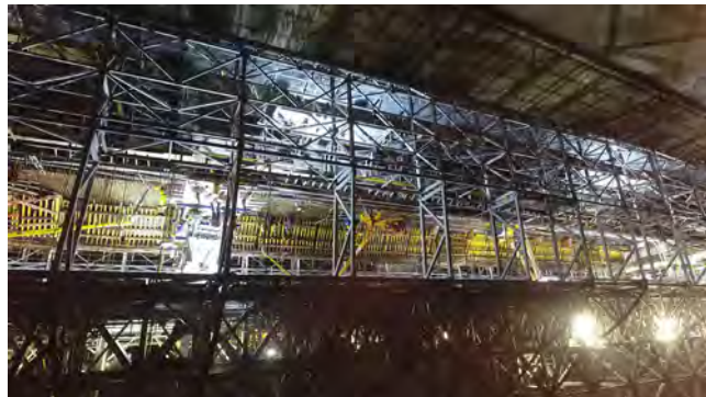
Figura 1. Vista fundida sección "U" con autocimbra.
