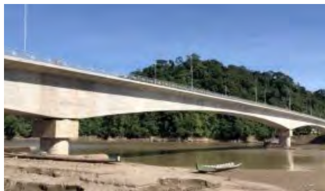
Figura 1. Vista general del Puente ya finalizado.
