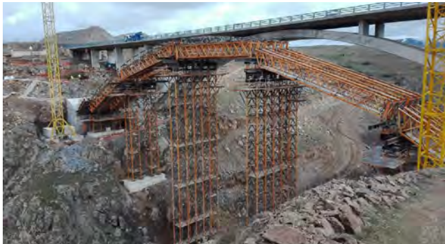
Figura 1. Vista general de la cimbra del arco.
