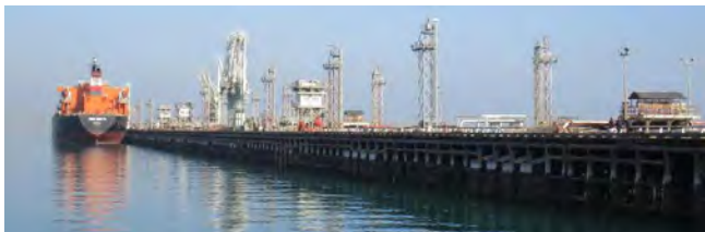
Figura 1. Vista general del muelle del “North Pier”.
