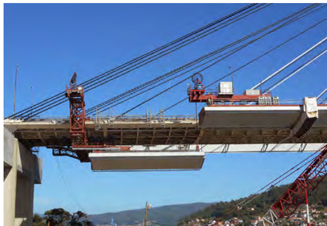
Figura 2. Izado compartido entre los dos carros.
