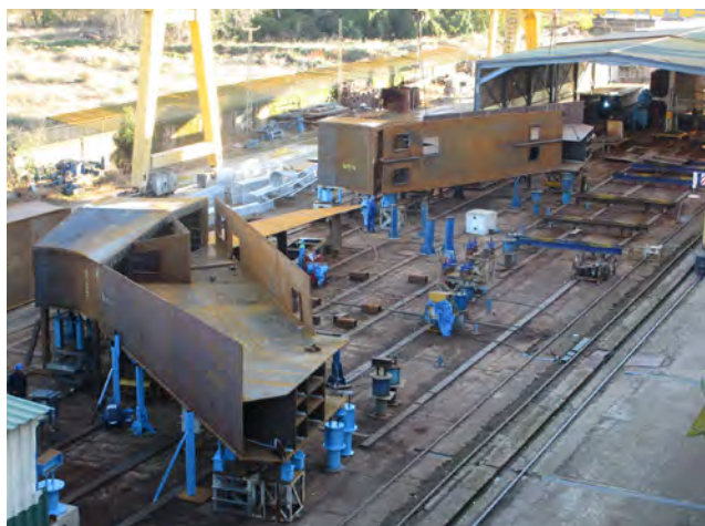
Figura 2. Vista del dintel de pila durante su fabricación en taller.
