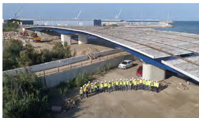
Figura 2. Vista del viaducto durante la construcción.
