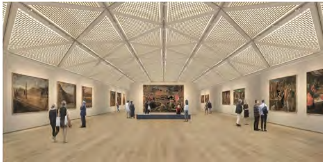
Figura 2. Cubierta abovedada en diagrid.
