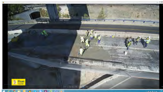
Figura 1. Losas sobre el tablero de los pasos superiores de la A-1 sobre la M-40.
