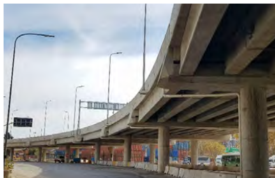
Figura 2. Vista inferior del Viaducto Norte.
