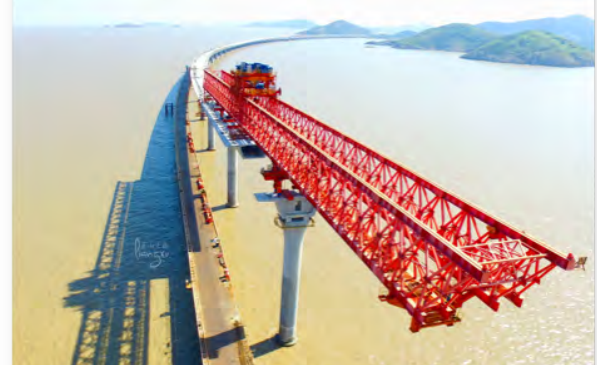
Figura 2. Ejecución de viaducto con Launching Gantry.
