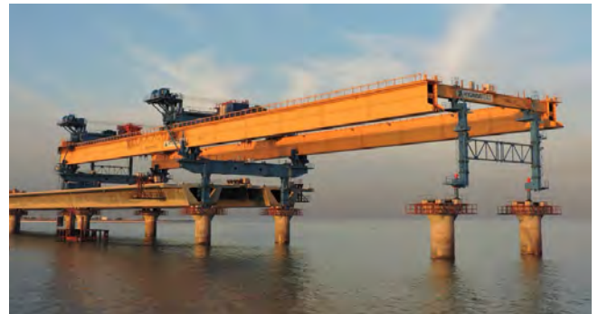
Figura 1. Lanzadera de tableros completos, o lanzaderas Full Span.
