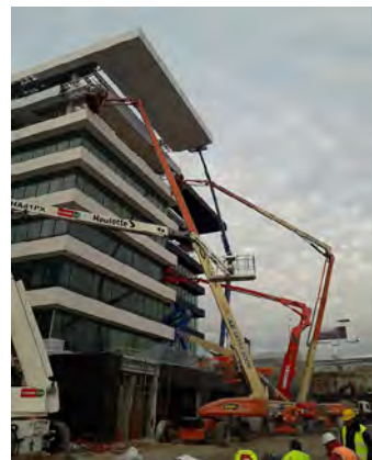
Figura 2. Montaje de fachada.
