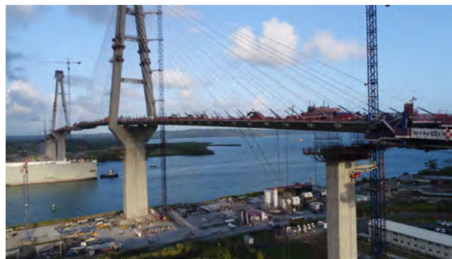
Figura 2. Paso del carro por encima de las pilas de retención.
