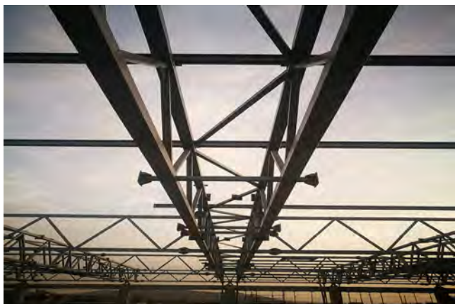
Figura 2. Detalle de una de las celosías dobles en su cruce con las celosías transversales .
