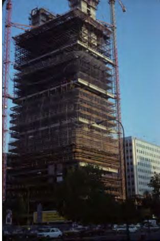
Figura 1. Construcción del edificio.
