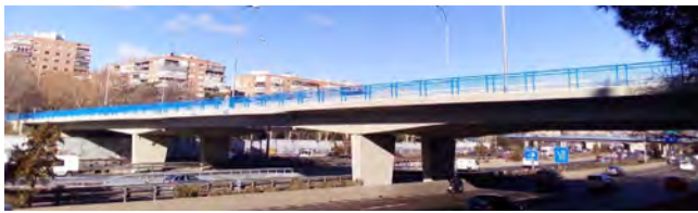
Figura 2. Vista de la estructura terminada
