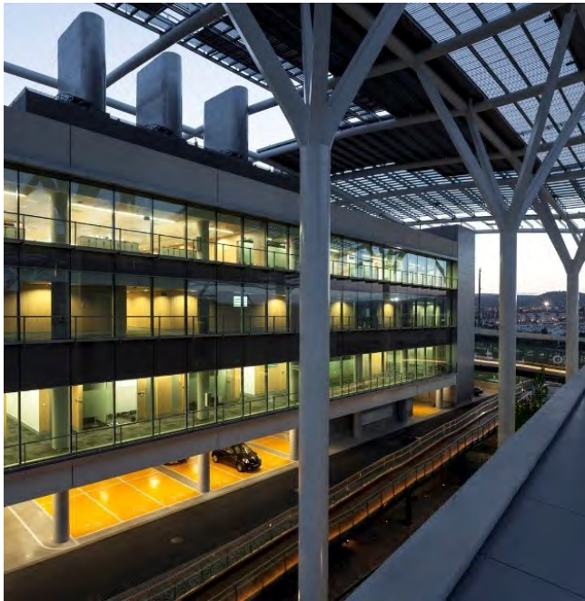
Figura 2. Pasarelas de conexión entre edificios.
