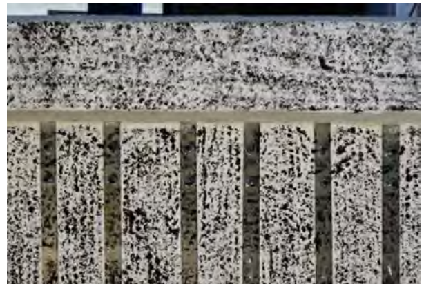
Figura 2. Refuerzo en U colocado en el alma de las vigas de sección en T, anclado mediante dos anclajes mecánicos.
