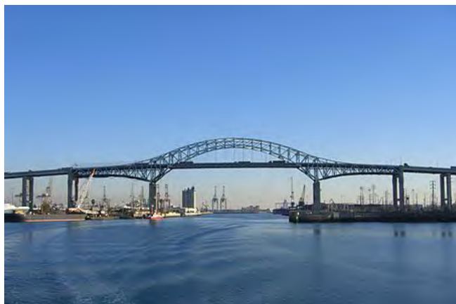
Figura 1. Puente existente de Gerald Desmond.
