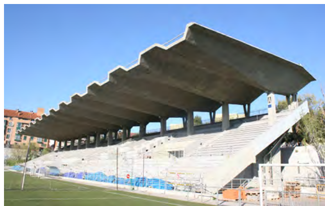
Figura 1. Imagen de la cubierta en abril de 2017.
