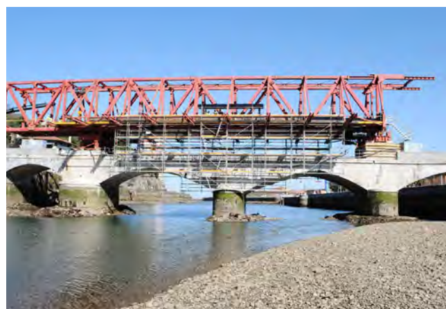
Figura 2. Vista del puente en marzo de 2019 con la estructura de cuelgue colocada.
