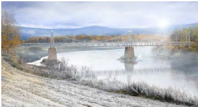
Figura 1. Vista de la pasarela peatonal de Neby.
