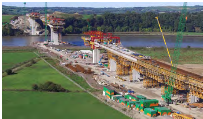
Figura 2. Vista aérea de la construcción, desde el lado Este (carro de alas en vano 6, cimbra en vanos 6, 7 y 8).
