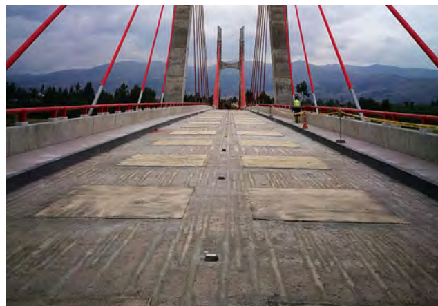
Figura 1. Vista general del tablero tras los trabajos de reparación y refuerzo
