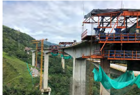
Figura 2. Vista del puente Pipiral durante la construcción.
