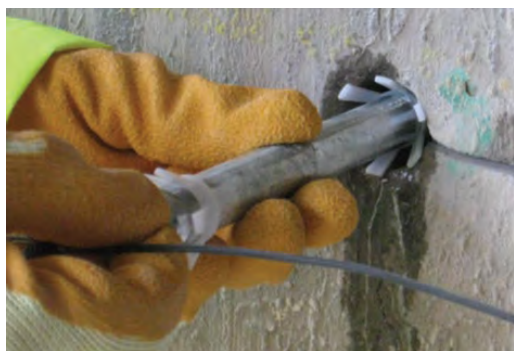
Figura 1. Ejemplo de ánodo de sacrificio.
