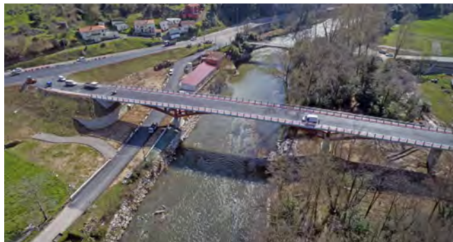
Figura 2. Imagen aérea de la nueva estructura con el puente de Ribera al fondo.
