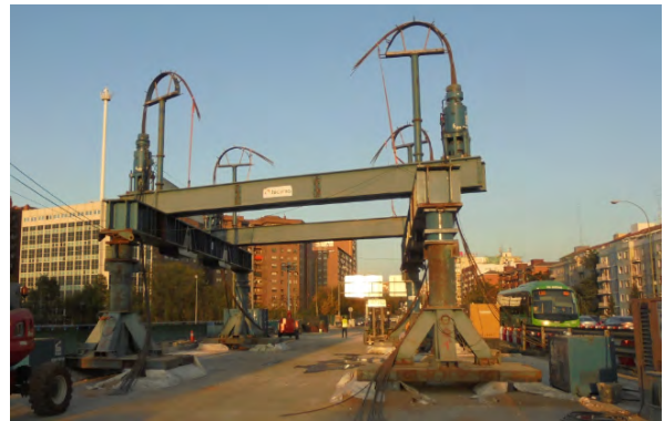
Figura 1. Sistema de izado colocado sobre la estructura.
