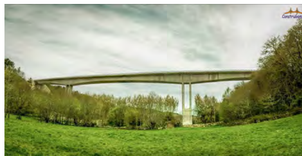
Figura 1. Vista de la obra terminada
