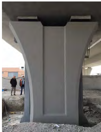
Figura 2. Pila 13 del Viaducto de Acceso Sur al Aeropuerto de Málaga reparada.
