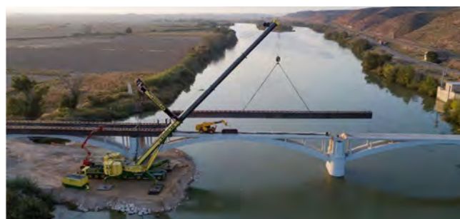
Figura 2. Montaje de viga metálica desde la península.
