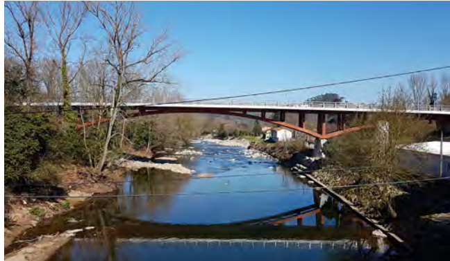
Figura 1. Nuevo Puente de Golbarado en servicio.
