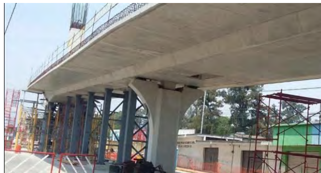
Figura 1. Vanos laterales sobre los apoyos provisionales.
