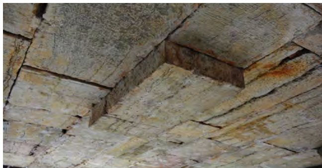
Figura 1. Sillar descolgado en intradós de bóveda.
