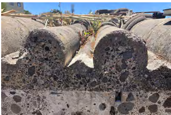
Figura 2. Detalle de la moldura prefabricada crucero. Restos de la Catedral. Ventura Rodríguez.
