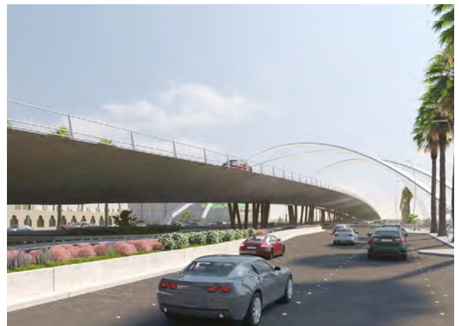
Figura 1. Vista en escorzo del tablero sobre el conjunto de tubos mixtos de distribución irregular.
