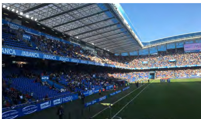
Figura 2. Vista interior de las nuevas cubiertas.
