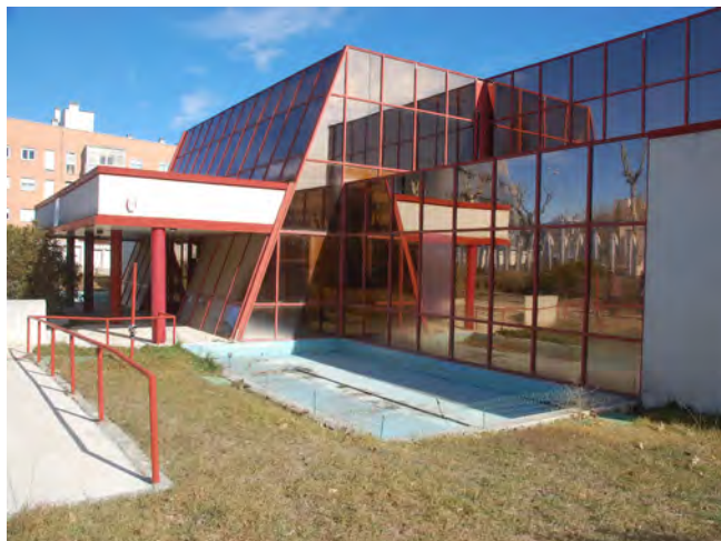
Figura 1. Estado original del edificio 1.
