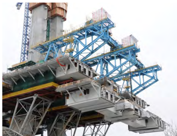
Figura 2. Sistema de colocación de dovelas.
