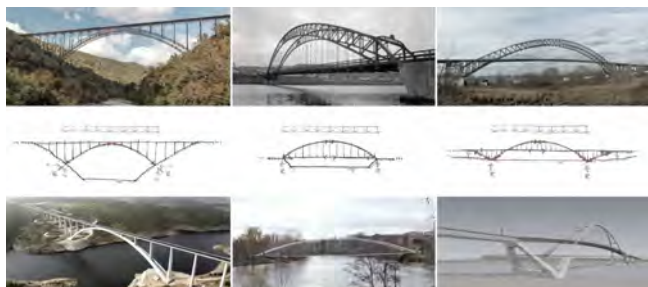
Figura 1. Fila superior: Puentes arco puros de tablero inferior, superior e intermedio. Fila intermedia: funcionamiento básico de las tres configuraciones. Fila inferior: Diseños del autor del artículo que responden a los tres tipos.
