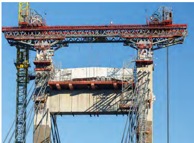
Figura 2. Vista del pórtico de izado instalado para el izado del cabece-ro de ampliación de las torres del puente.
