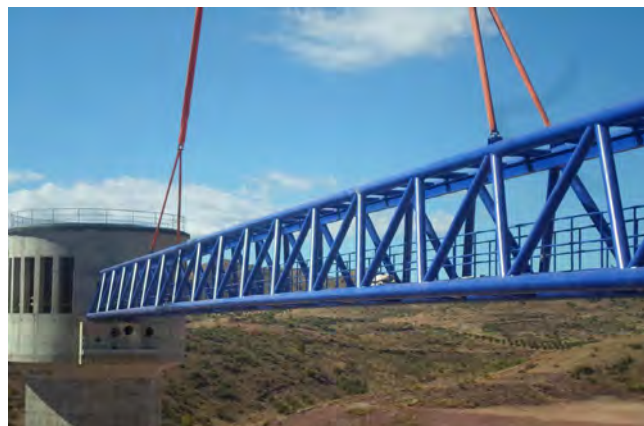
Figura 1. Vista lateral de la pasarela.
