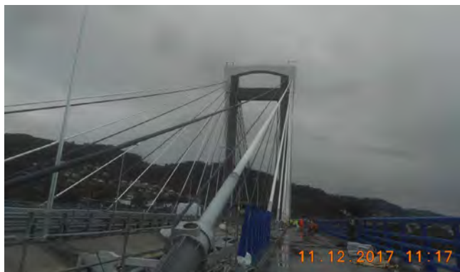
Figura 2. Tormenta "Ana" azotando el puente antes de su puesta en servicio.
