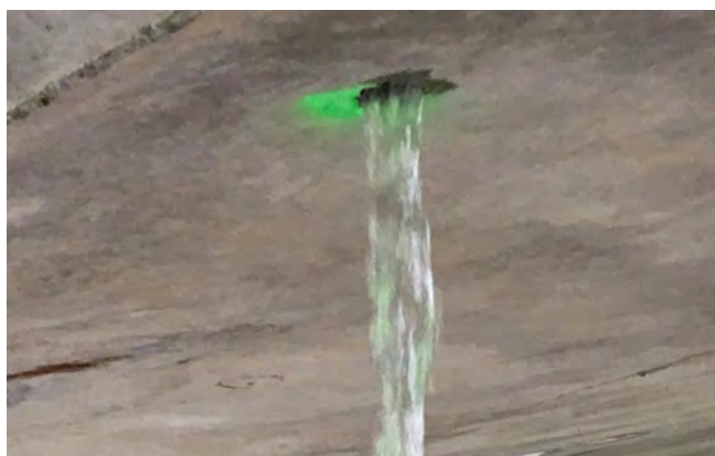
Figura 2. Recalce de cargaderos mediante micropilotes y detalle de salida de agua a presión de tablero.
