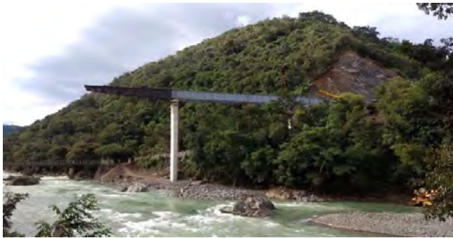
Figura 2. Vista del empuje del puente Oxec donde se aprecia la nariz de lanzamiento de canto variable.
