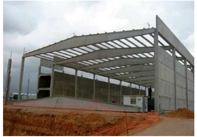
Figura 2. Vista de la estructura de una nave de uso industrial con elementos prefabricados.
