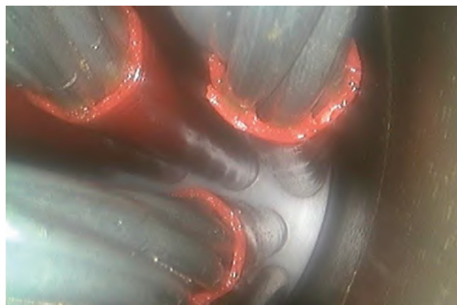
Figura 7. Interior de un anclaje vaciado.
