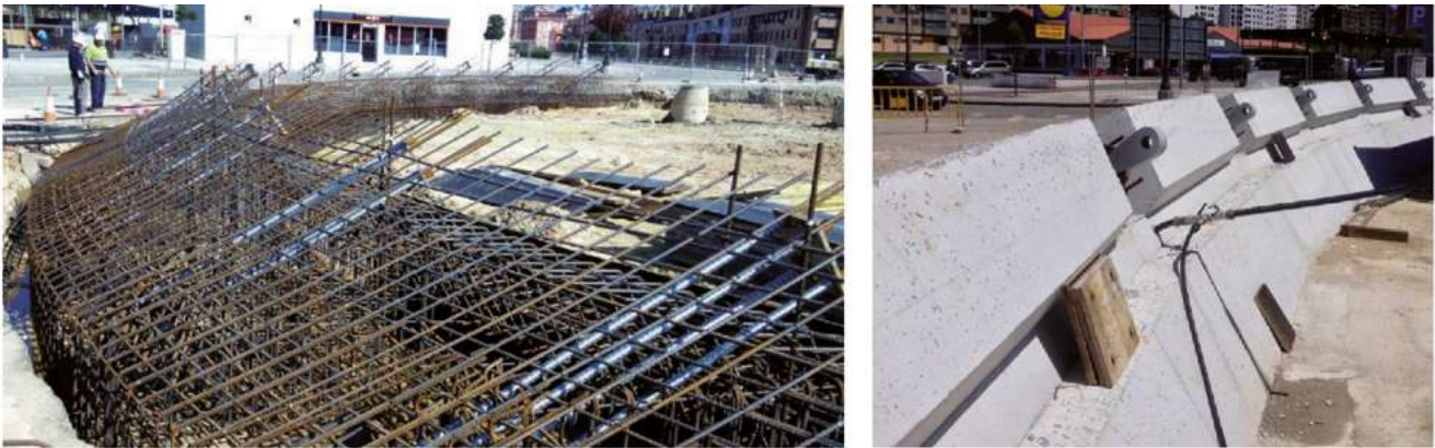
Figura 10. Fotografías del anillo de retenida.
