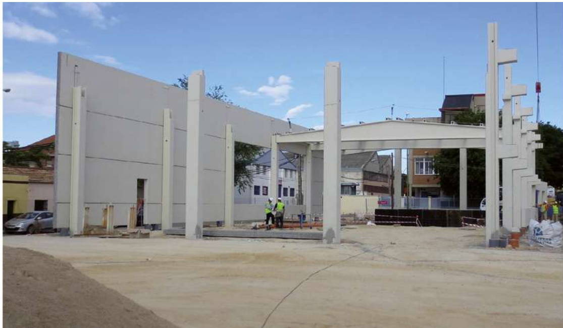
Figura 31. Nave en construcción con elementos prefabricados.
