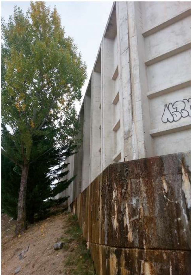
Figura 23. Sección y vista exterior de un depósito resuelto con paneles prefabricados.
