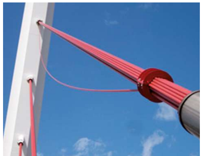
Figura 5. Rotura de un cordón.
