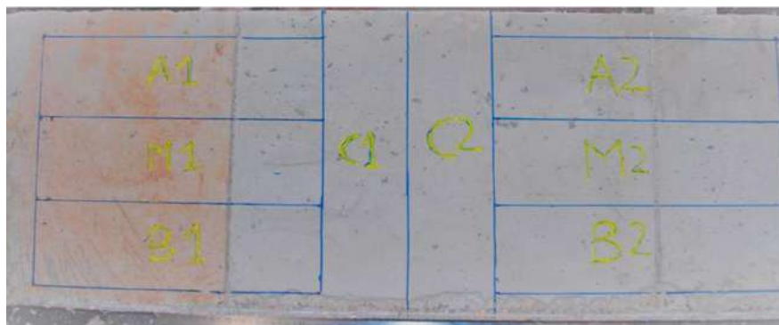
Figura 2. Muro con las probetas marcadas.
