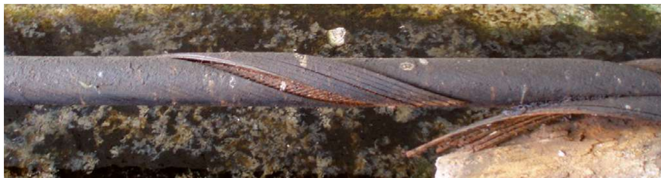
Figura 1. Hilos exteriores rotos en cable cerrado.
