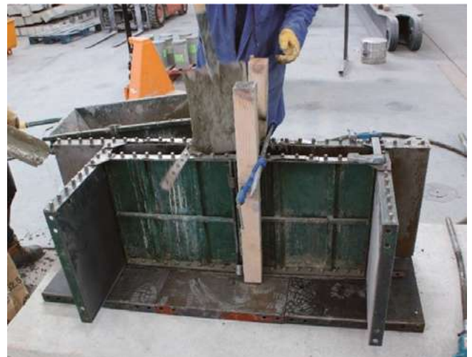
Figura 1. Fabricación del muro.
