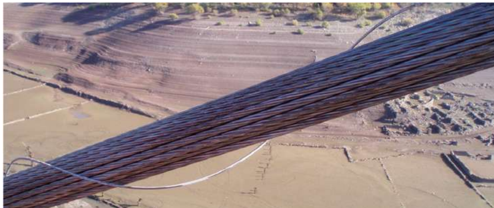
Figura 13. Tramo de tirante limpio (con hilo separador en forma de hélice).
