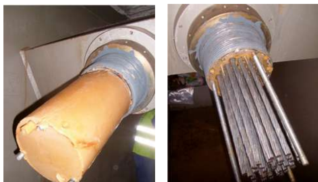
Figura 6. Vista de anclaje inferior, después de retirar el capot (izquierda) y la cera (derecha).
