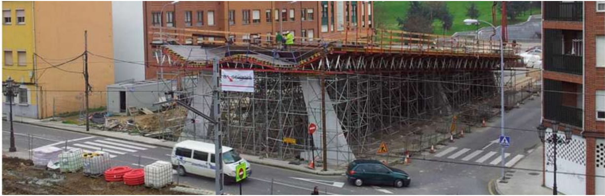
Figura 12. Cimbra y encofrado del viaducto de acceso.
