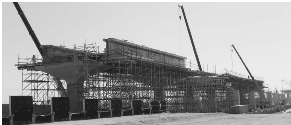
Figura 4. Vano cimbrado isostático de ancho variable.
