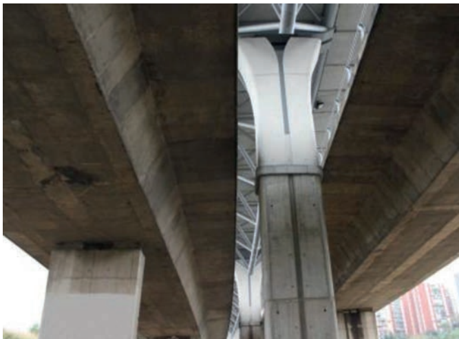
Figura 2. Pila del viaducto Bus-Vao.
