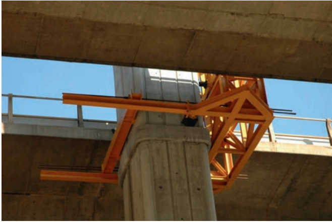
Figura 21. Sujeción de la estructura metálica auxiliar a la pila de hormigón.
