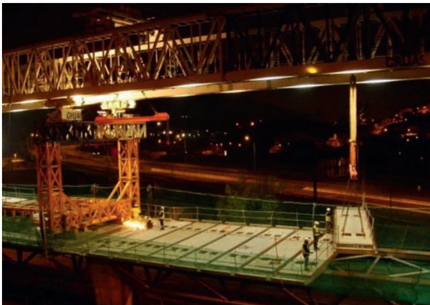
Figura 26. Montaje de losas prefabricadas con el lanzador.
