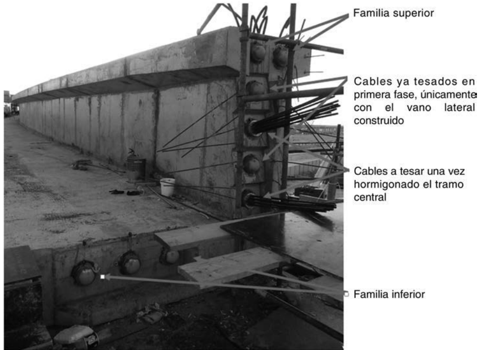
Figura 13. Cables desde extremo del puente.
