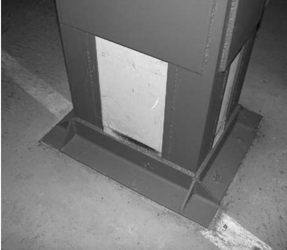
Figura 4. Apoyo de refuerzo sobre solera (foto tomada en Lorca).
