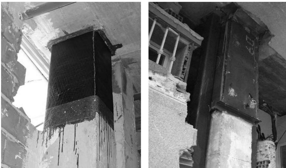
Figura 5. Actuaciones en cabeza de soportes (fotos tomadas en Lorca).
