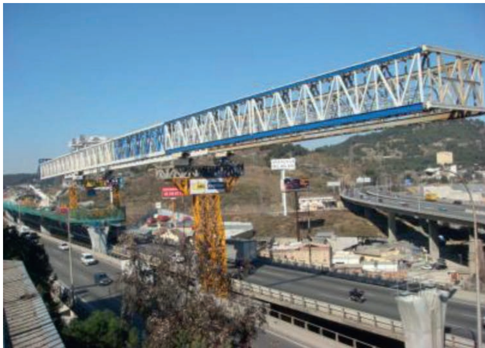
Figura 18. Viga de lanzamiento, de 120 m de longitud, con el extremo frontal en voladizo.
