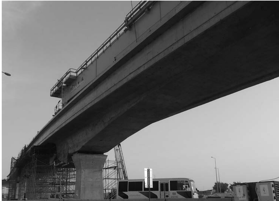
Figura 16. Vista inferior mientras el launching gantry atraviesa el tablero.
