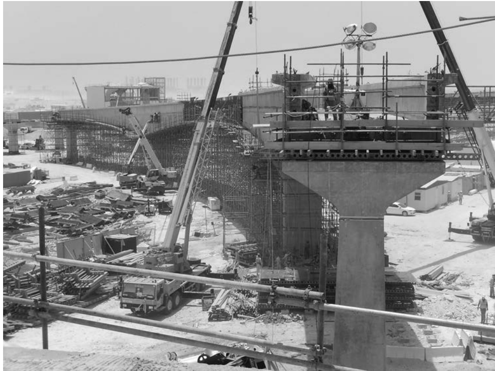
Figura 11. Vista frontal del puente en construcción.
