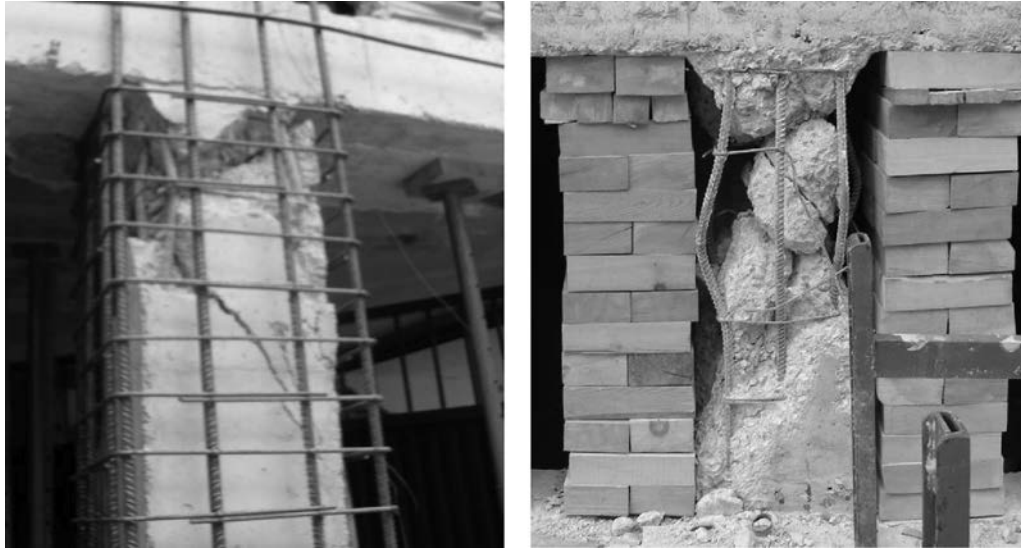
Figura 1. El daño en los pilares requiere la sustitución de los mismos (fotos tomadas en Lorca).
