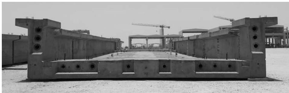
Figura 2. Sección transversal en U para vanos prefabricados.
