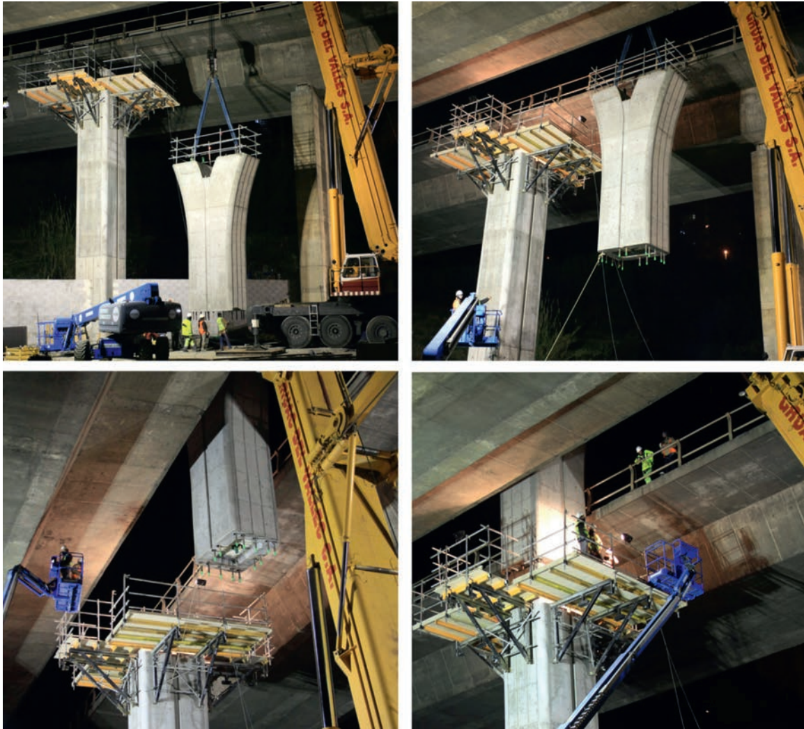
Figura 14. Montaje de la fracción superior de una pila.
