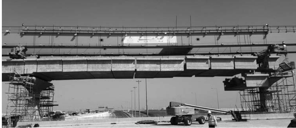
Figura 3. Montaje del vano de 44,3 m de luz sobre F-Ring.
