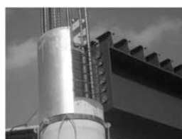
Figura 9. Detalle de apoyo de la parte metálica de vigas mixtas en soportes de hormigón sin equipo de soldadores en obra
