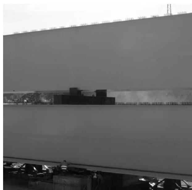
Figura 24. Detalle de vigas transversales de apoyo
