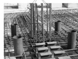
Figura 9. Detalle de apoyo de la parte metálica de vigas mixtas en soportes de hormigón sin equipo de soldadores en obra
