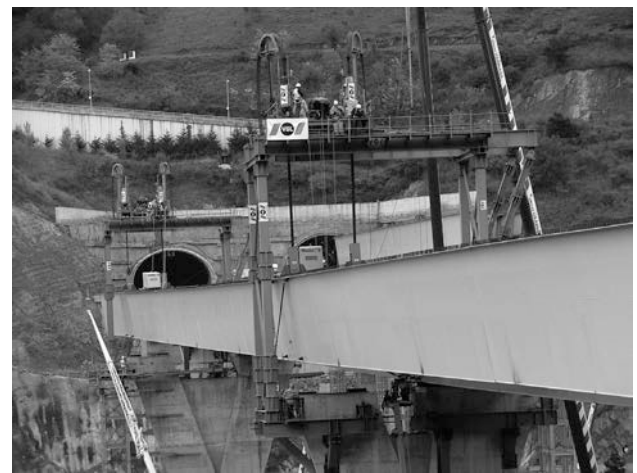
Figura 35B. Descenso del viaducto V4
