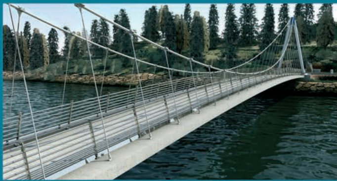
Pasarela colgada sobre el Esla en Sahechores (León), luz 75 m
