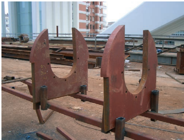
Figura 53. Chapas de acero de espesor 60 mm pertenecientes a las orejetas de unión arco fijo - costillas móviles y utilizadas para corregir las desviaciones de la posición de los ejes en el montaje con respecto a las posiciones teóricas
