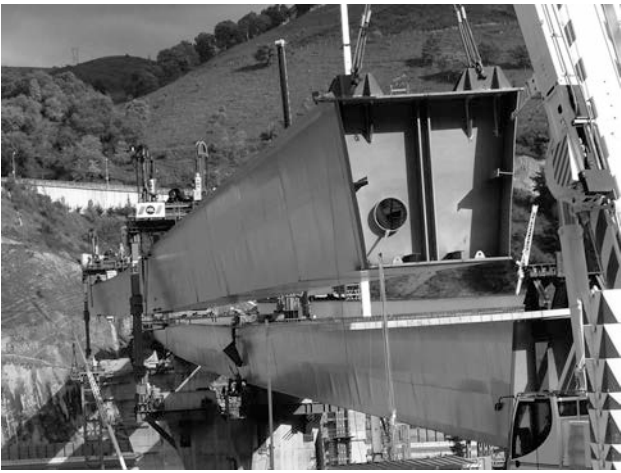
Figura 34A. Izado del viaducto V4 desde 3 puntos
