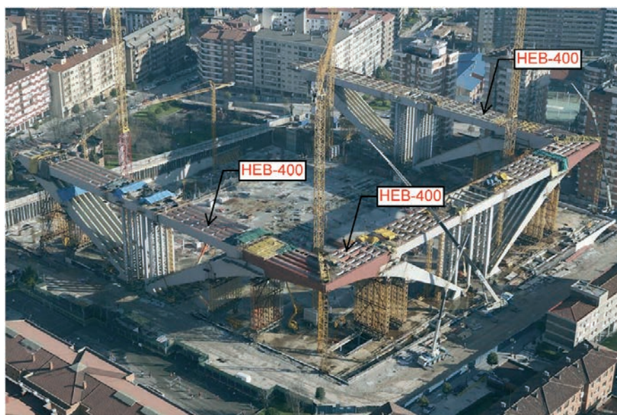
Figura 12. Vista aérea de los pórticos principales de los tres edificios con los arriostramientos mediante HEB-400 parcialmente ejecutados Figure 12. Aerial view of the main portals of the three buildings with the HEB-400 bracing partially executed
