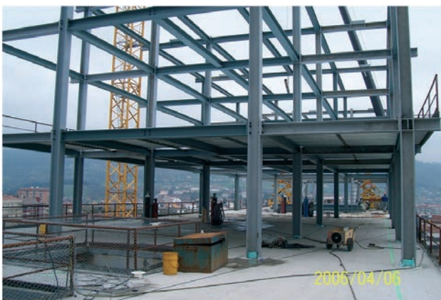
Figura 14. Entramado metálico de los edificios. Pórticos transversales unidos mediante vigas isostáticas Figure 14. Steel structure of the buildings. Transverse frames connected by longitudinal isostatic beams
