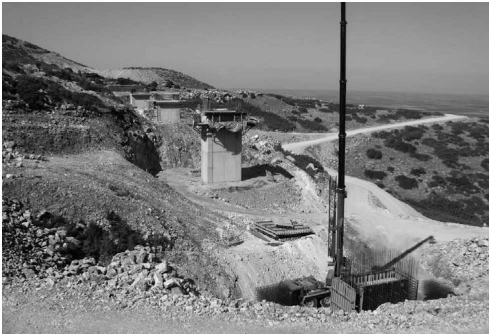
Figura 10. Pilas de la estructura SG27 en construcción
