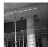
Figura 9. Detalle de apoyo de la parte metálica de vigas mixtas en soportes de hormigón sin equipo de soldadores en obra
