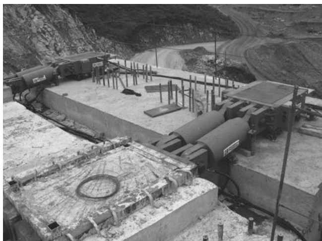
Figura 7. Estructura SG25. Gatos y teflones de lanzamiento en estribo
