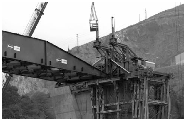
Figura 19. Recuperación de flecha con pórticos auxiliares
