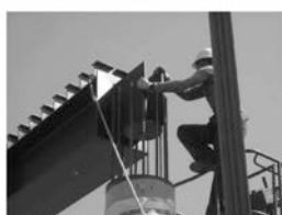
Figura 9. Detalle de apoyo de la parte metálica de vigas mixtas en soportes de hormigón sin equipo de soldadores en obra
