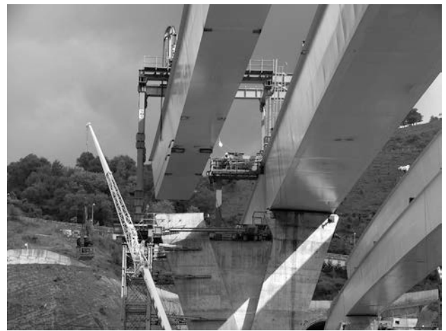
Figura 34B. Traslación del viaducto
