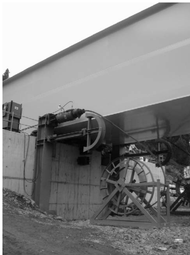
Figura 15. Sistema convencional de tiro en estribo E.1-1
