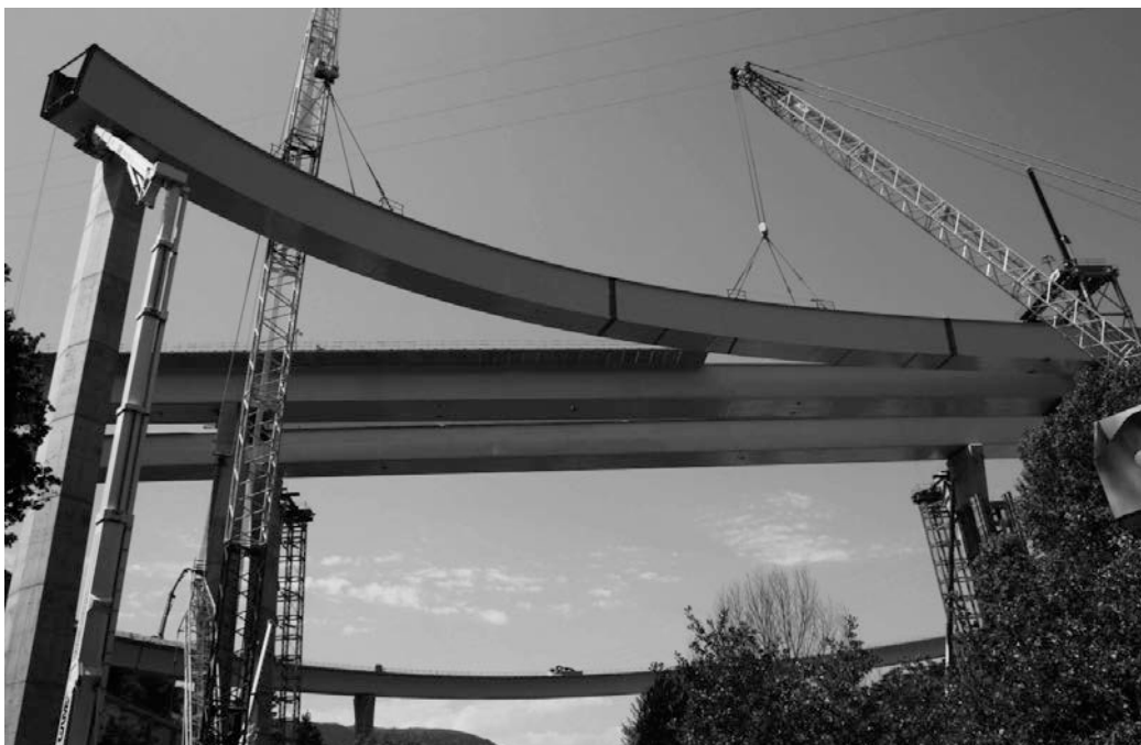
Figura 36. Montaje con grúa del resto del viaducto V4
