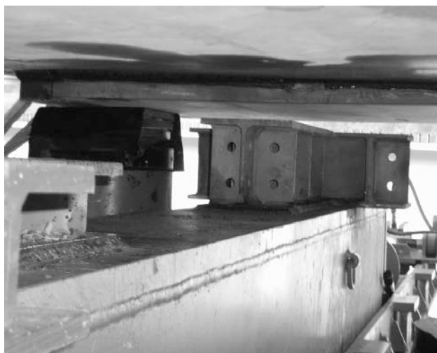
Figura 22. Carriles para el ripado
