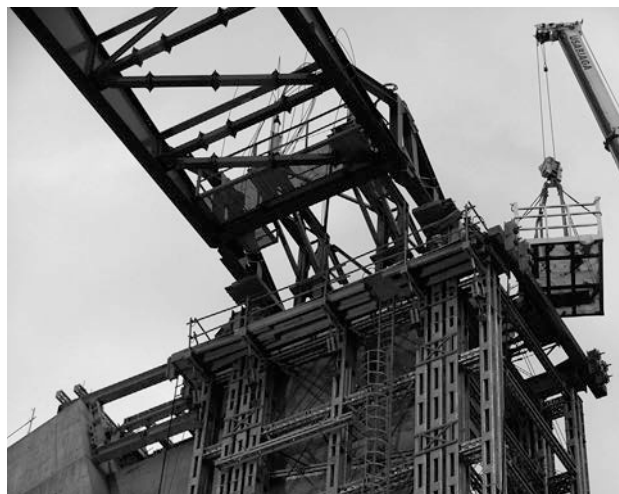
Figura 20C. Cierre de 2ª puerta y apoyo en gatos hidráulicos
