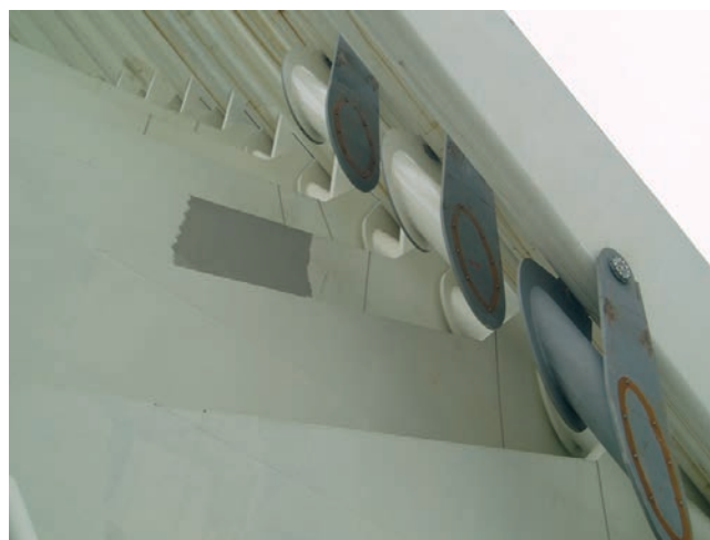
Figura 56. Tramos de arco móvil con orejetas ya montados en las costillas móviles
