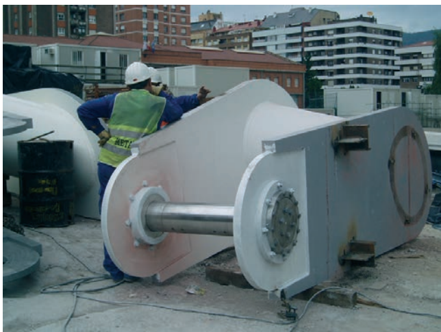
Figura 55. Tramo de arco móvil incluyendo las orejetas de unión a las costillas antes de ser izado y montado
