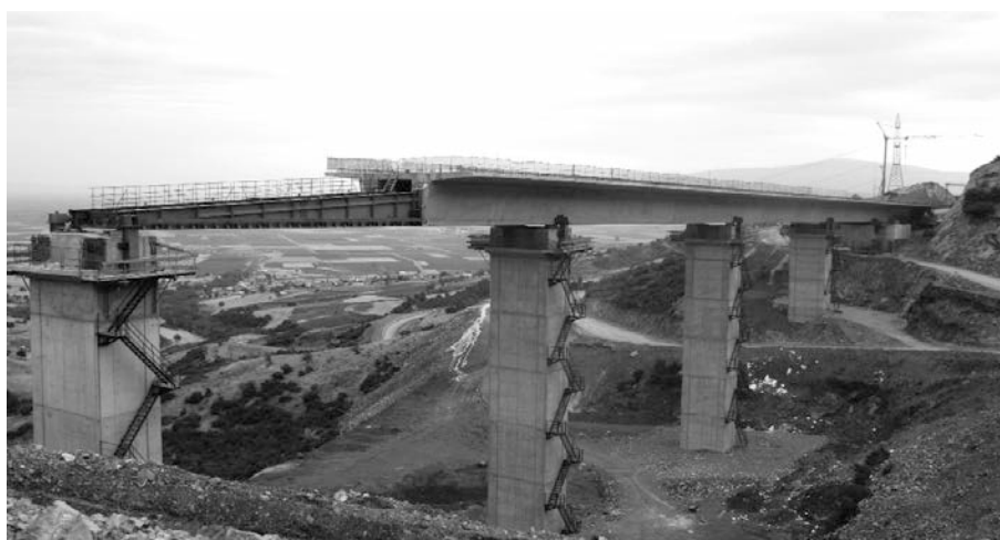
Figura 9. Empuje de la estructura SG25
