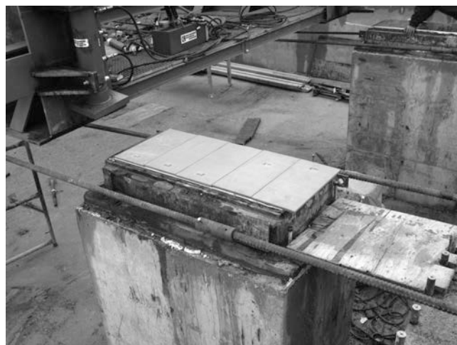
Figura 7. Estructura SG25. Gatos y teflones de lanzamiento en estribo
