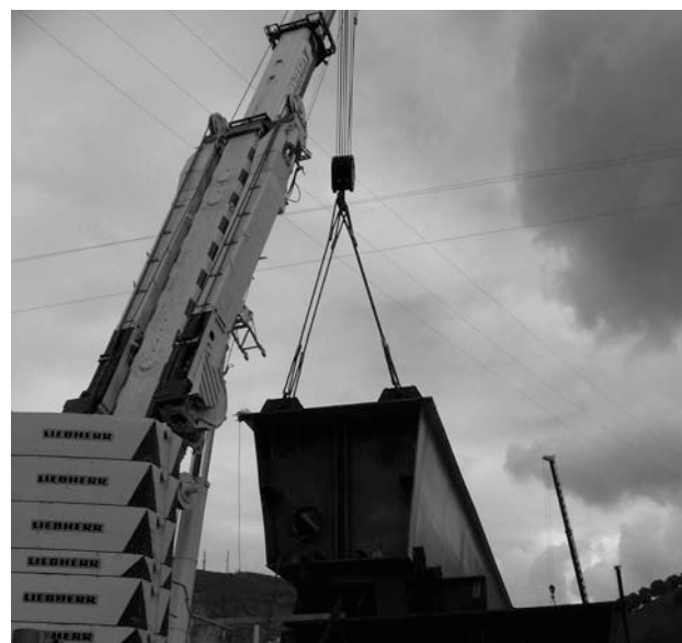
Figura 25. Grúa de apoyo en estribo
