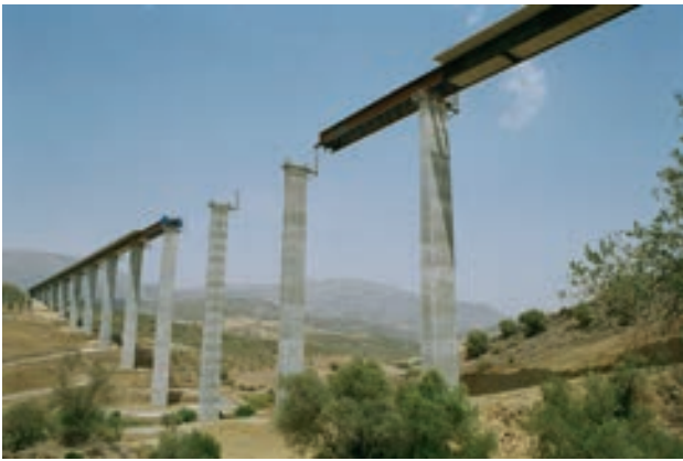
Figura 12. Vista inferior del viaducto durante el empuje
