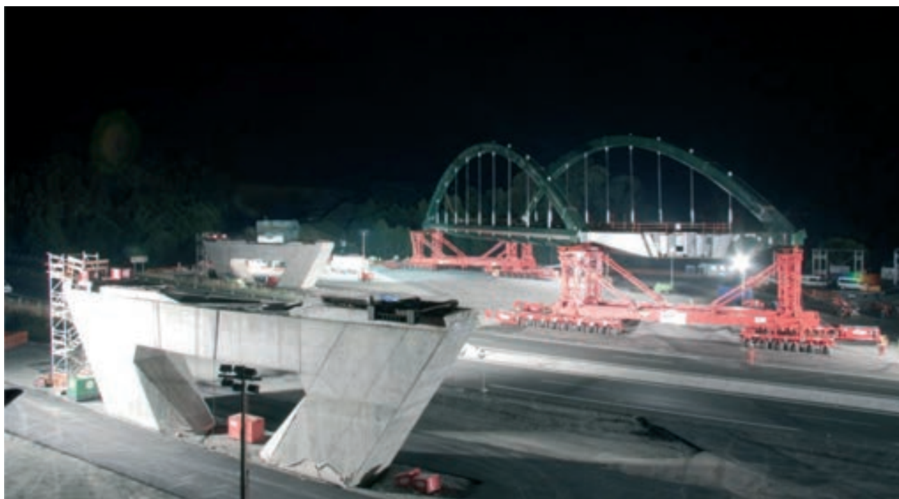
Figura 14. Fase previa al cruce sobre la autopista
