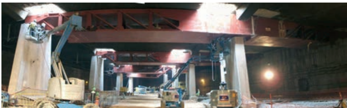
Figura 25. Montaje de pórticos de cabecera debajo de la losa nervada
