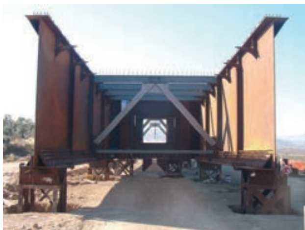
Figura 9. Estructura metálica apeada en el parque de empuje
