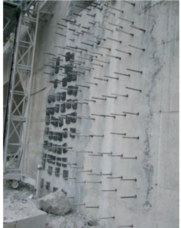
Figura 29. Refuerzo de muro
