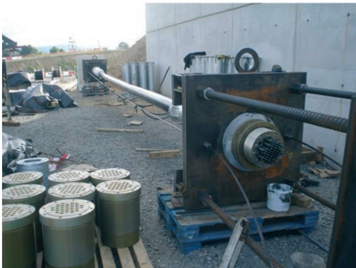
Figura 11. Bancada para tesado de péndolas
