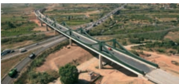
Figura 7. Puente de Sant Boi
