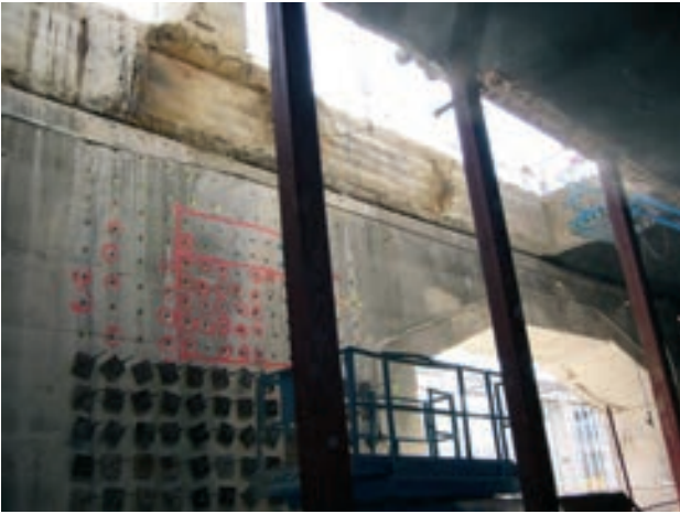
Figura 28. Huelco en muro, refuerzo muro y hueco en forjado
