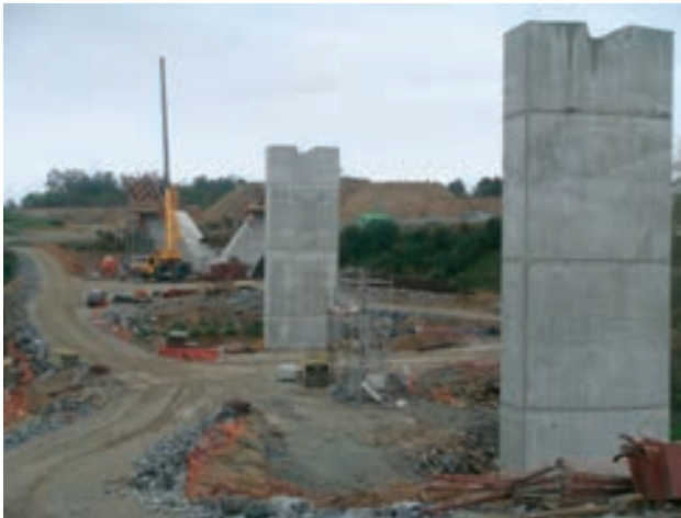
Figura 6. Pilas 1 y 2 durante la construcción
