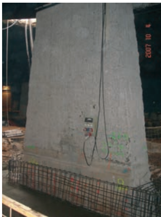
Figuras 13 y 14. Refuerzo de pilares
