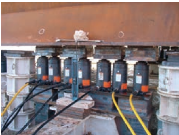
Figura 16. Aplicación de reacción localizada con gatos
