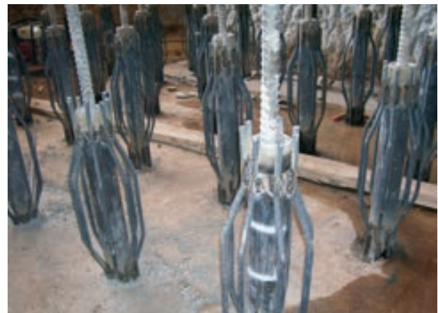
Figura 35. Ejemplo de conexión micropilote-estructura
