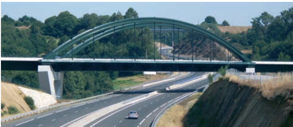
Figura 2. Vista del viaducto sobre la autopista
