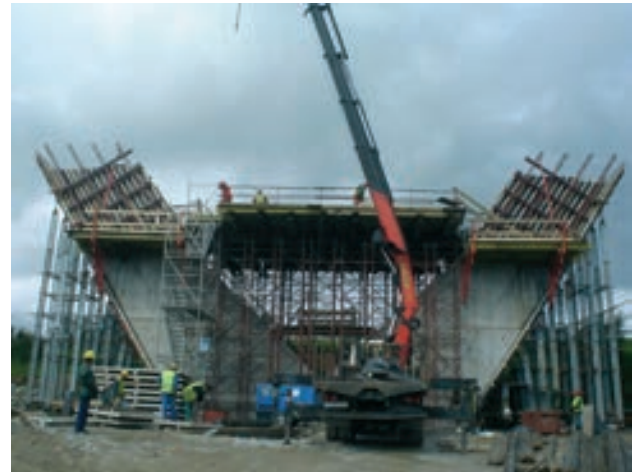
Figura 7. Pila 3 durante la construcción
