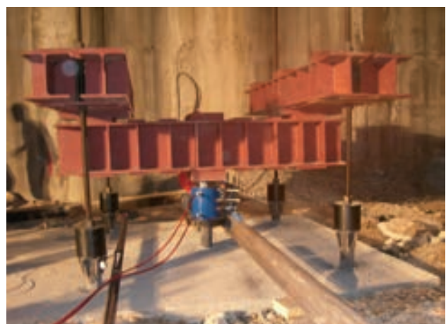
Figura 36. Prueba de carga de micropilote
