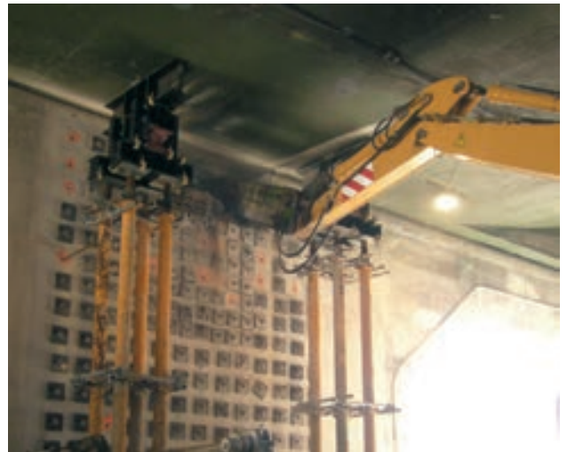
Figura 30. Refuerzo de muro
