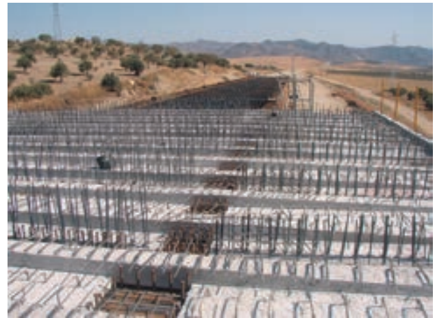
Figura 10. Vista de prelasas superiores
