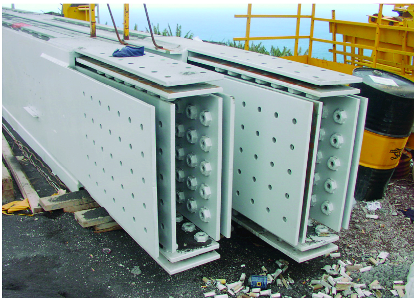
Figura 20. Unión machi-hembra. Figure 20. Box and pin.
