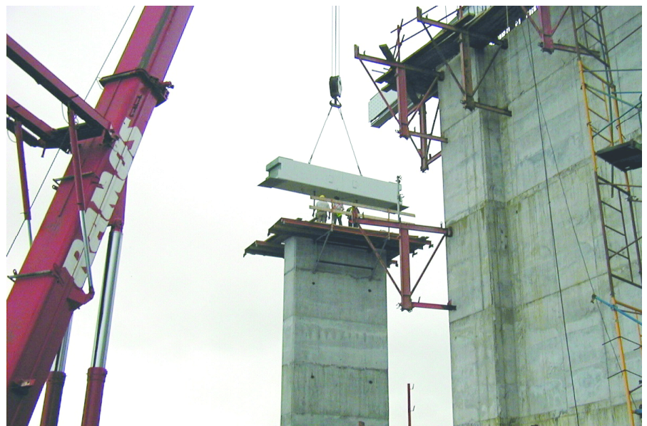
Figura 13. Colocación de traviesa Figure 13. Placing of sleeper.
