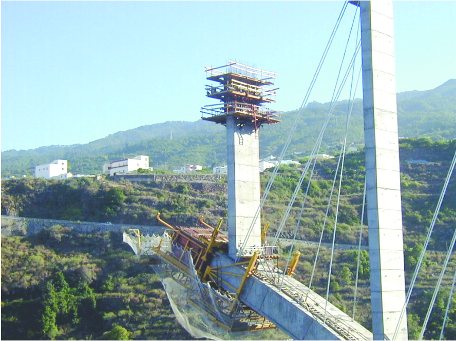
Figura 12. Trepado para hormigonar las pilas. Figure 12. Climbing process to concrete columns.
