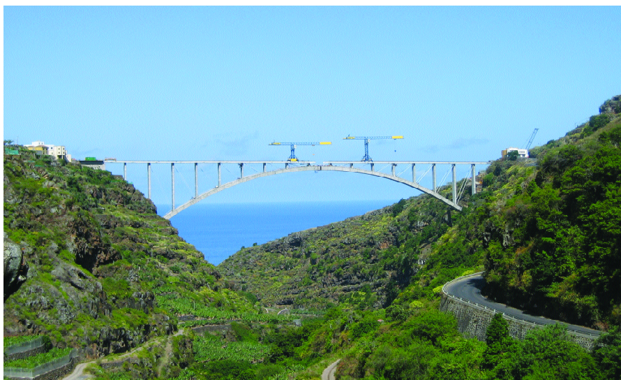
Figura 1. Vista general del arco de Los Tilos. Figure 1. General view of the Los Tilos arch.
