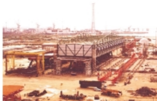
Fig 18: Vista de la estructura metálica en posición 5 y montaje de la ferralla sobre tablero. Fig 18: View of the steel structure at position 5 and assembly of reinforcement on the slab.
