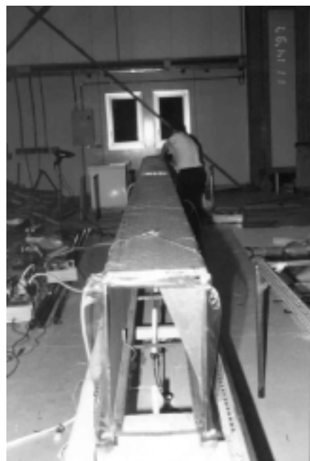
Foto 1. Proceso de curado del encofrado estructural.
