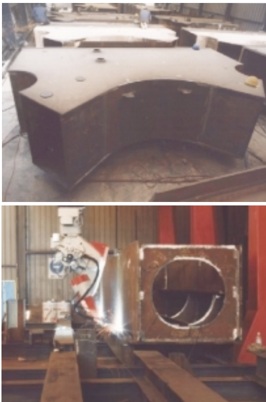
Fig. 15: Prefabricación en taller de componentes metálicos elementales: nudos y barras. Fig. 15: Workshop prefabrication of basic steel components: joints and bars.
