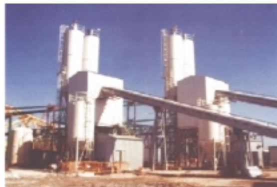
Fig. 11: Detalle de la nave de hormigonado y de las plantas de producción de hormigón. Fig. 11: Detail of the concrete-placing shed and concrete-production plants.
