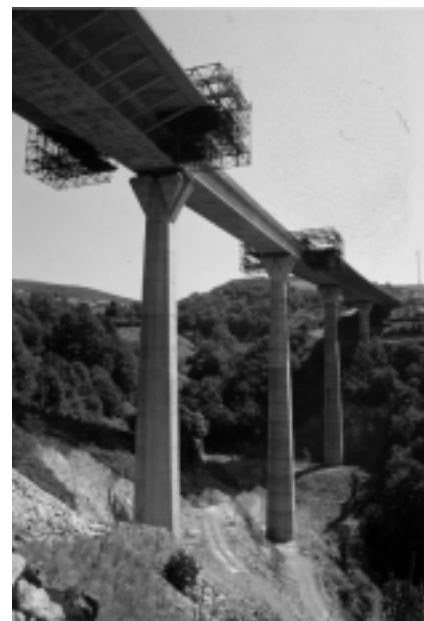
Figura 2. Hormigonado de vuelos.
