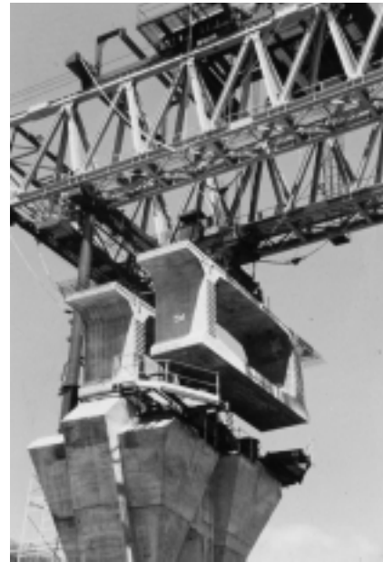
Figura 1. Detalle del montaje de la dovela 1.
