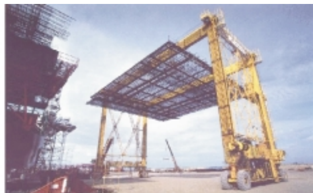
Fig 13: Vista de la zona de montaje de ferralla y pórtico sobre neumáticos para su traslado. Fig 13: View of the reinforcement assembly area and frame crane on tyres used to transport it.
