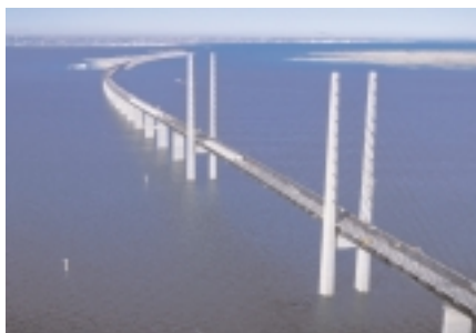
Foto de portada: Puente de Oresund. Vista general del puente central atriantado y del puente de aproximación oeste durante su pavimentación.
