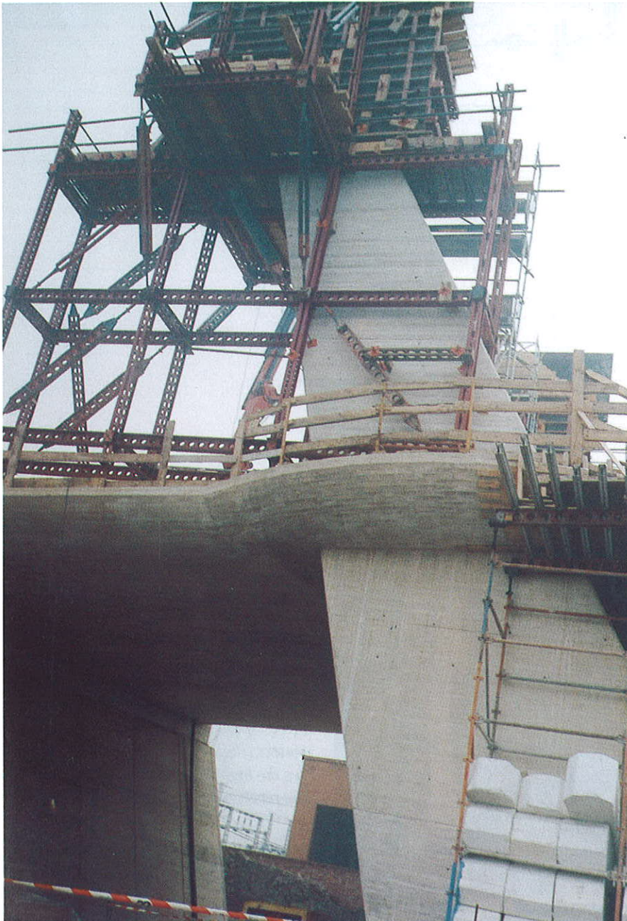
Figura 6. Vista de las plataformas en torno a las pilas. Figure 6. Platform view around the piers.
