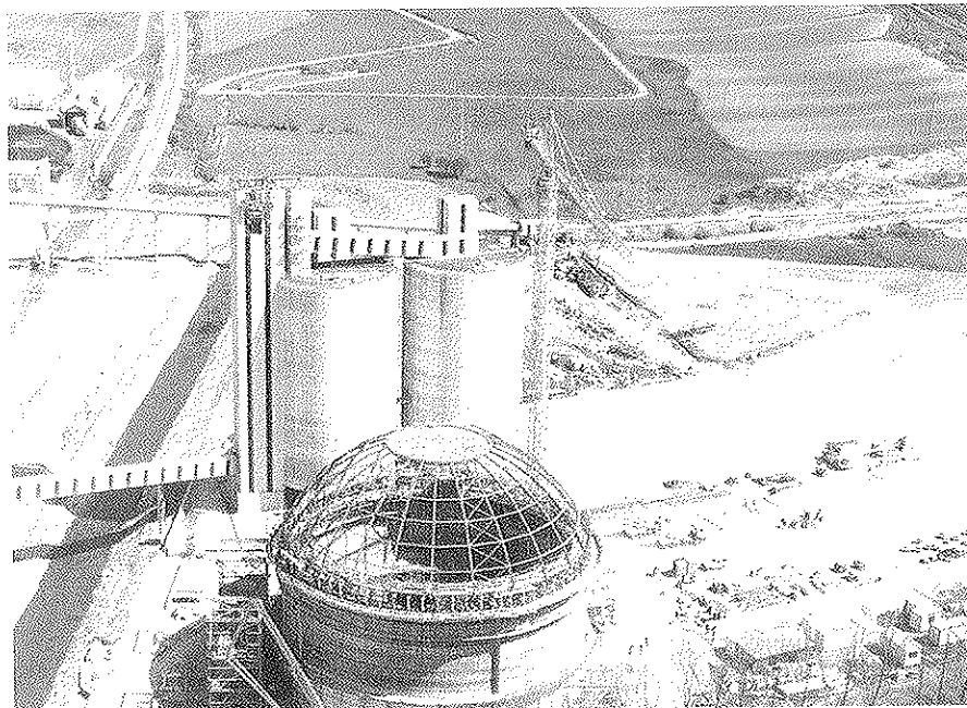
Figura 24. Aspecto general de la obra en el inicio de la construcción del fuste con encofrado deslizable y elevación simultánea de la cúpula metálica.
