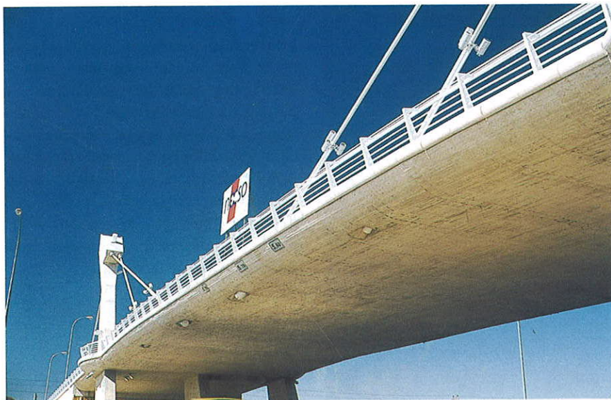
Figura 8. Vista inferior del tablero. Figure 8. Deck - Bottom view.
