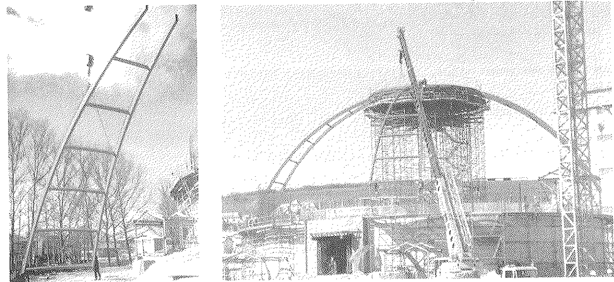
Figura 23. Montaje de las piezas metálicas que constituyen los meridianos de la cúpula sobre la estructura perteneciente al encofrado deslizable y unión, mediante soldadura, con la plataforma metálica apoyada sobre cimbra.
