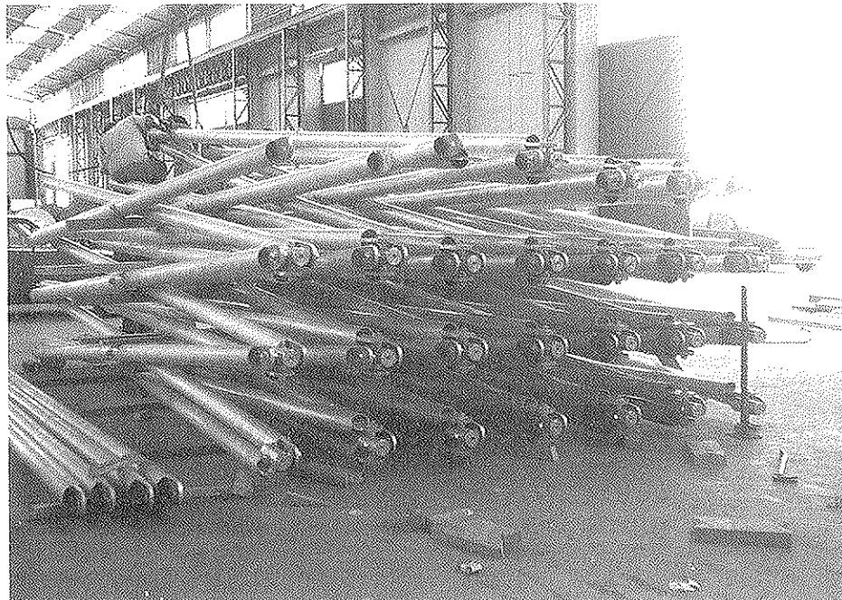
Fig. 29. Montaje de las primeras filas de barras.
