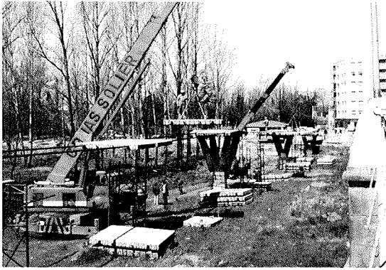
Fig. 1. Montaje de fosas prefabricadas sobre los cables.
