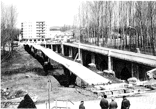
Fig. 3. Vista general con las fosas montadas sobre los cables.
