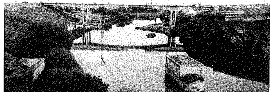
Avance en voladizo.
