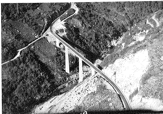
Fig. 4. Puente de Chantada. Vista general.
