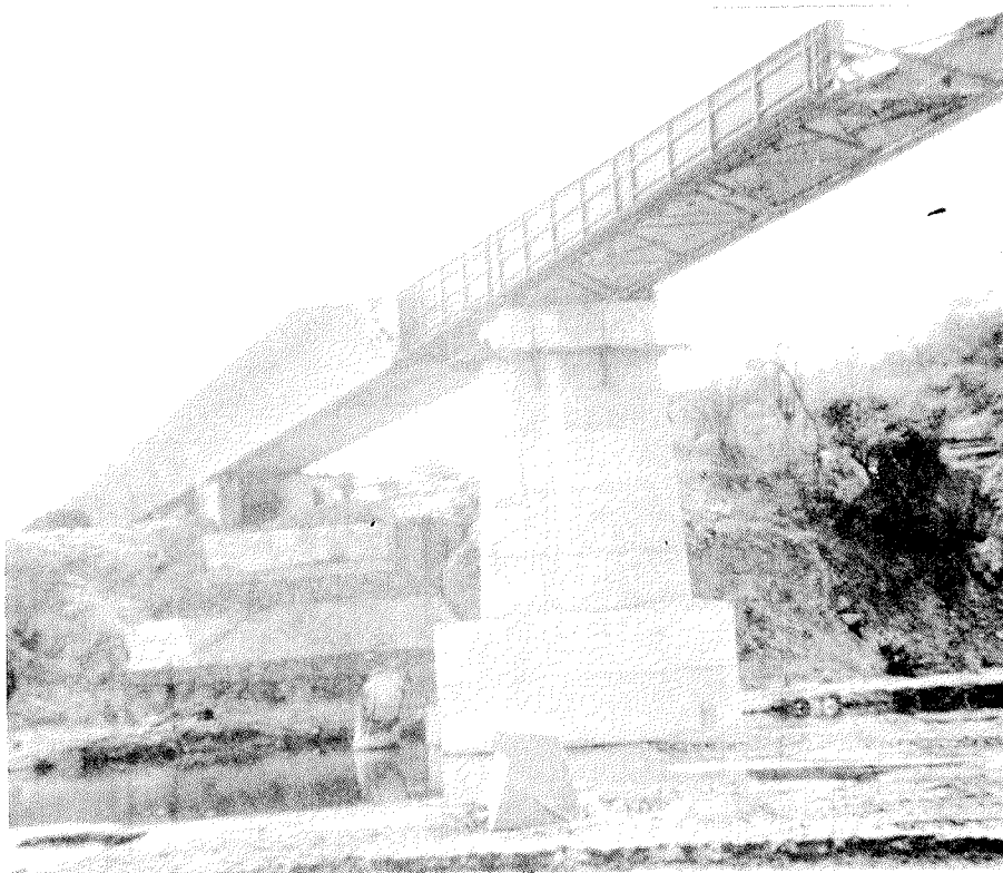
El puente de Badiraguato, durante el empujado.
