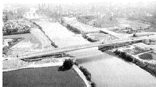
Fig. 3. Puente de las Fuentes. Voladizos terminados. Encofrado de zona sobre cimbra.
