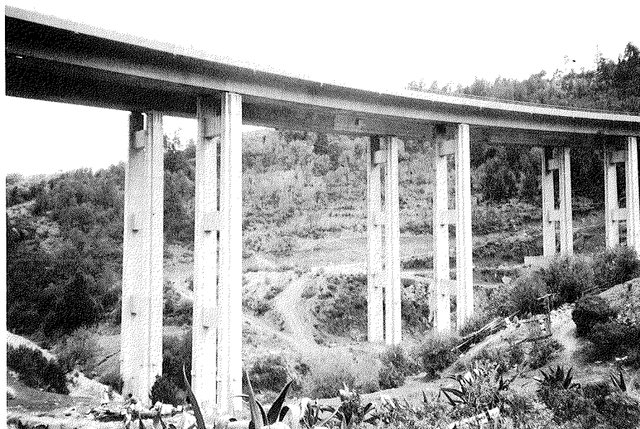
El viaducto de la Marquesa, terminado.
