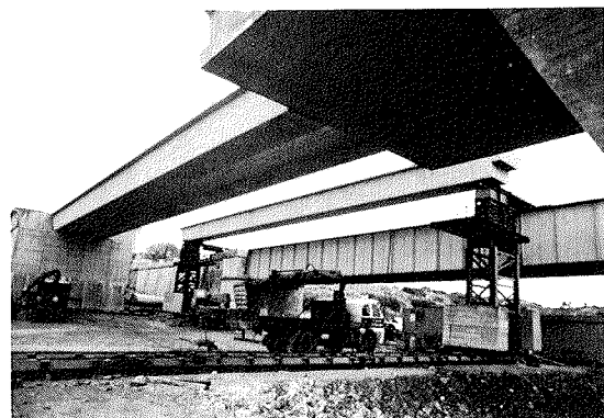
Foto 1. Proceso de montaje de vigas.
