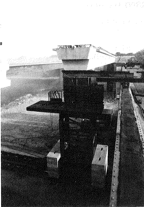
Foto 2. Detalle de ripado transversal.
