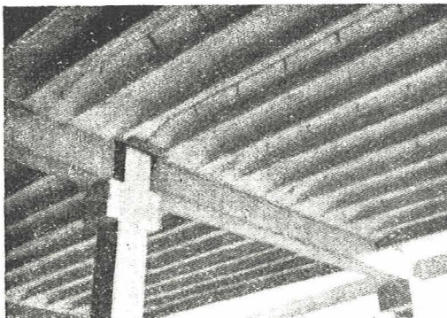
Fig. 24c.—Las placas del forjado vistas por su parte inferior.
