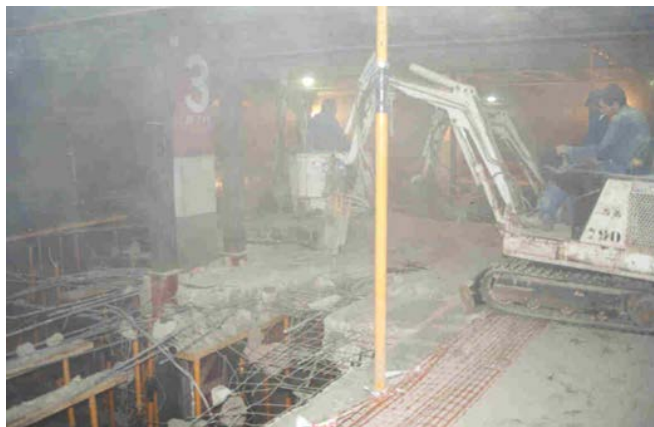
Figura 32. Aparcamiento P2. Proceso de demolición en la zona con daños irreversibles.
