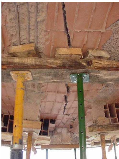
Figura 21. Rotura de la "capa de compresión" en las inmediaciones del foco de la explosión (Edif. C/ Martín Gaité, Leganés, Madrid, 2004).
