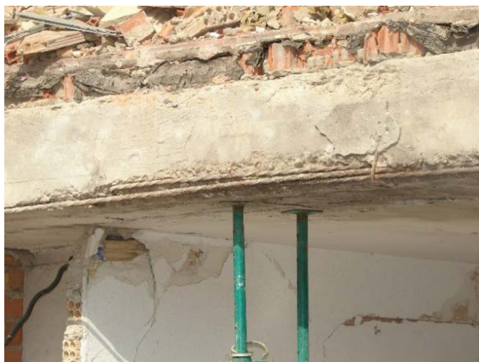
Desconchones en el hormigón.
