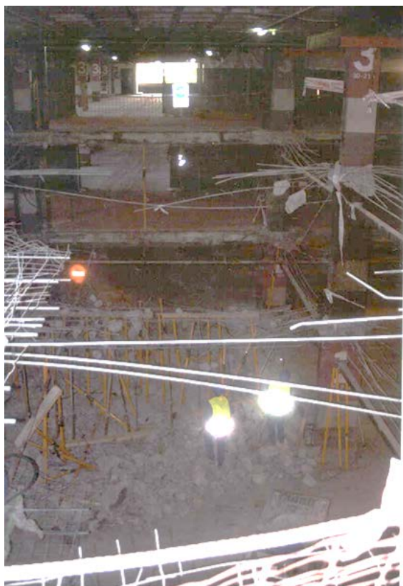
Figura 6. Ejemplo de fallo progresivo hacia plantas inferiores por punzonamiento (fotografía izquierda) y cortante (fotografía derecha) a la salida de ábacos (Aparcamiento P2 del Aeropuerto de Barajas 2001, y Centro Comercial en Zaragoza 2002).
