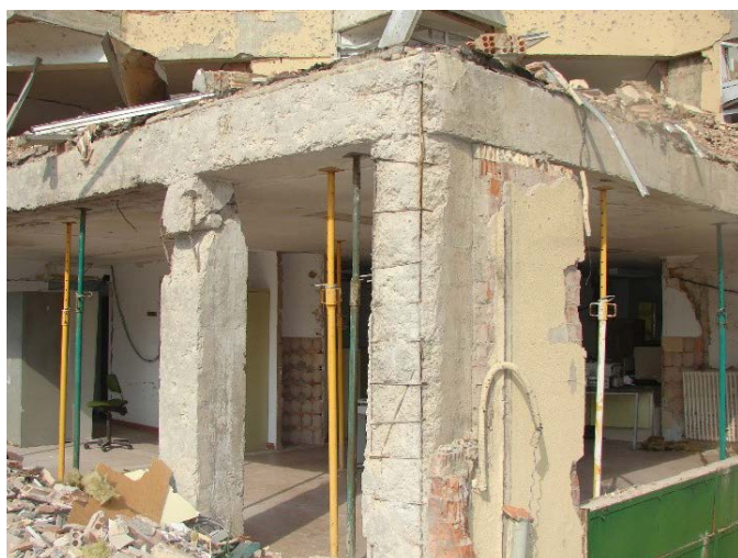
Daños en cabeza de un soporte por una explosión exterior junto a un cuerpo de una única altura adyacente al edificio principal.
