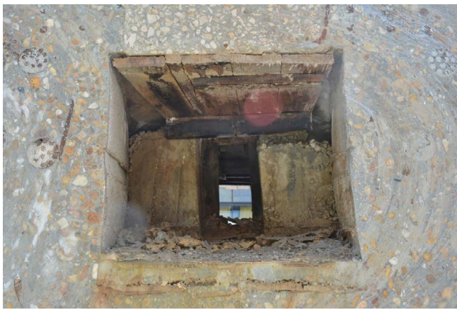
Figura 9. Cajetines de pretensado en uno de los alvéolos de una de las dovelas cortadas en el proceso de desmontaje (foto de los autores).
