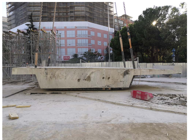
Figura 38. Sistemas de izado de piezas empleados: con balancines inferiores (izda.) y con eslinga de abrazo inferior (dcha.).
