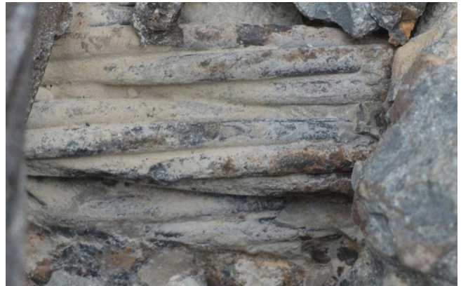
Figura 17. Calicata sobre pila 6. Foto de los autores, 12.02.2020.
