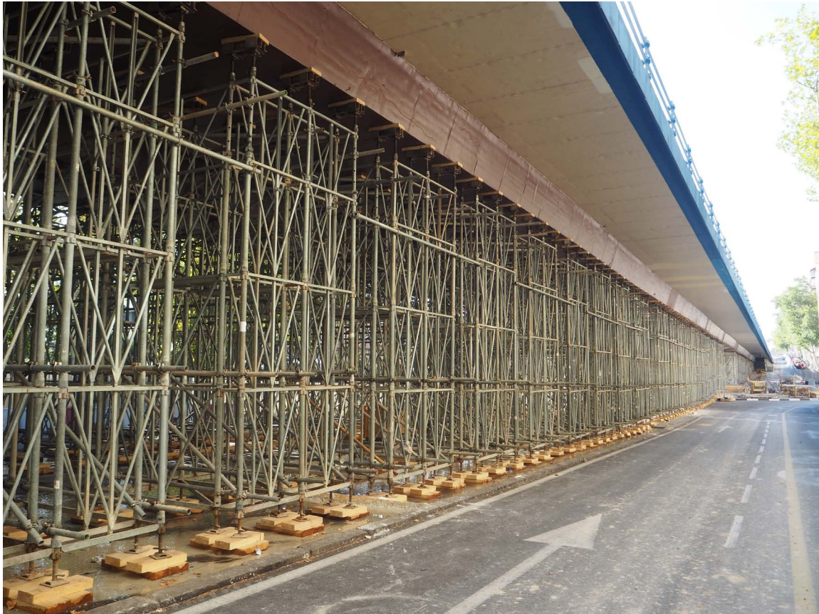
Figura 33. Cimbra cuajada instalada por ULMA. Vista desde pila P4 a estribo E2-1.
