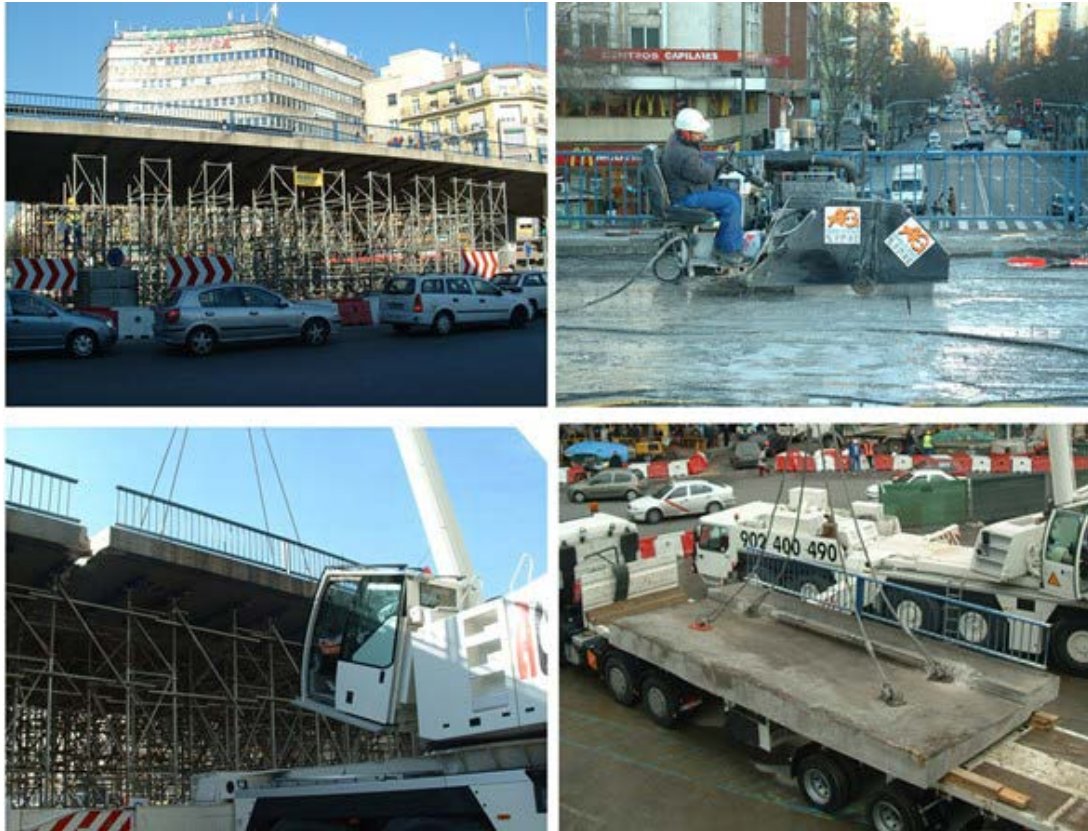
Figura 31. Ejemplo de desmontaje de paso superior urbano: el paso superior de Cuatro Caminos (Madrid).
