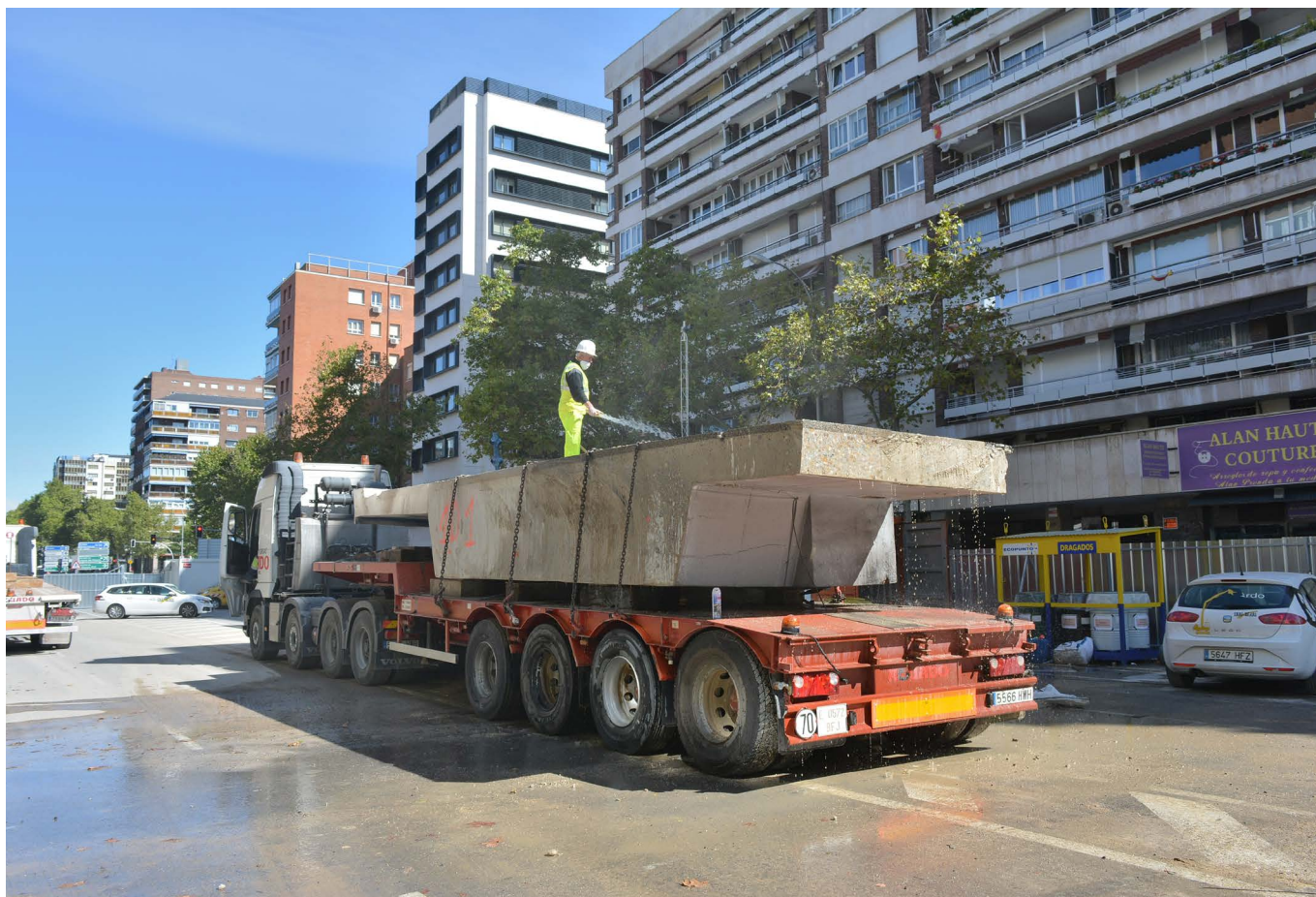
Figura 40. Transporte de pieza del tablero sobre plataforma.
