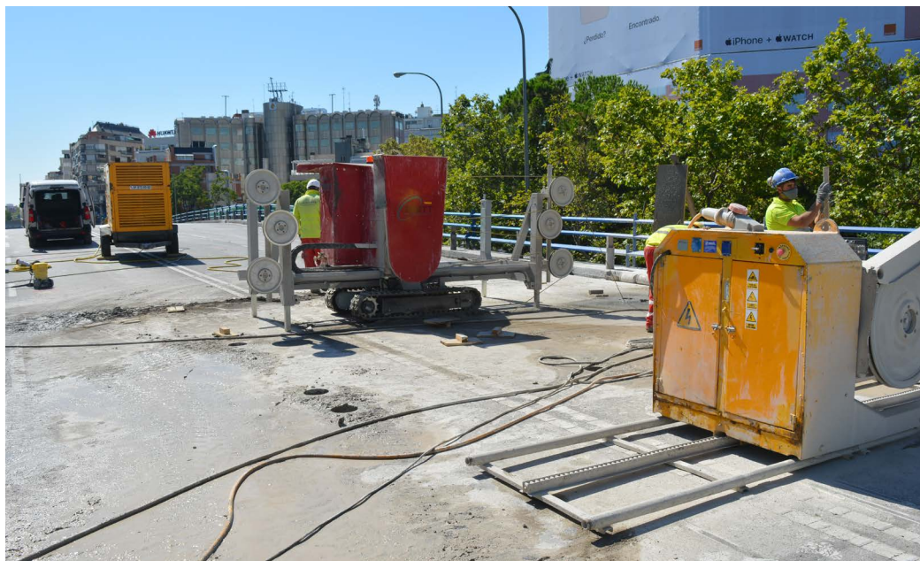
Figura 36. Equipos de corte con hilo de diamante.
