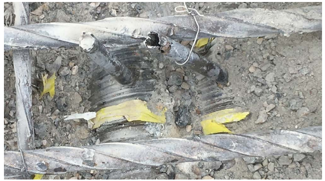
Figura 16. Vainas y tubos de purga sobre pila 6. Armadura pasiva estirada en frío, típica de la época (foto de los autores, 12.02.2020).
