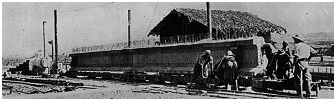
Figura 7. Viga prefabricada de 19 metros de luz del puente sobre el río Oued-Fodda, Argelia, 1936. (Reproducida de [7]).
