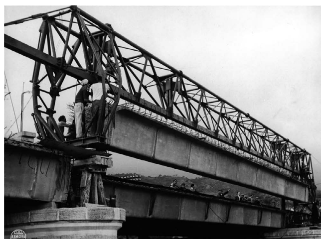
Figura 13 - Vigas cajón para los tableros de los viaductos Agrò y Fiumidinisi. (Reproducida de [31]).
