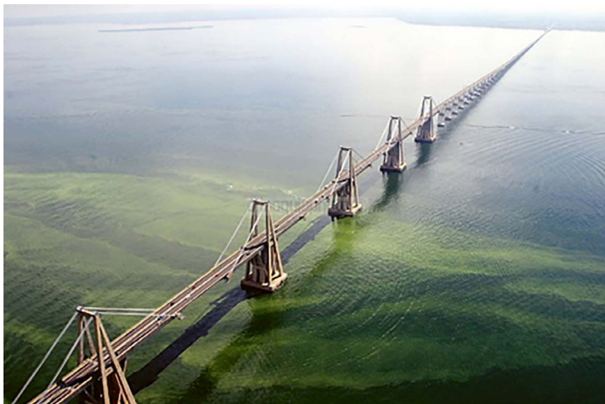
Figura 15 - Viaducto General Rafael Urdaneta en Maracaibo - Venezuela (1962) (Reproducida de [33]).
