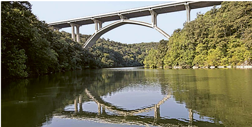
Figura 18 - Viaducto de Levane (1962-1963) (Reproducida de [34]).
