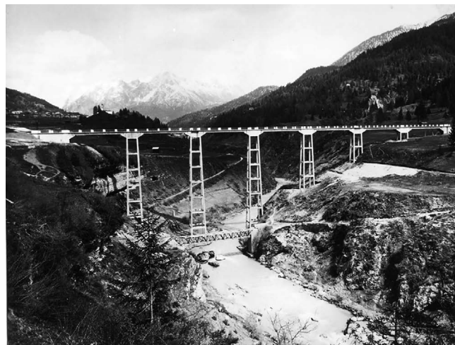
Figura 11 - Viaducto de Vallesella sobre el Piave (1949) (Reproducida de [28]).
