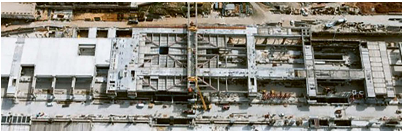
Figura 16. Vista aérea durante la construcción de la parte singular de la cubierta de la nueva estación intermodal de la Sagrera.
