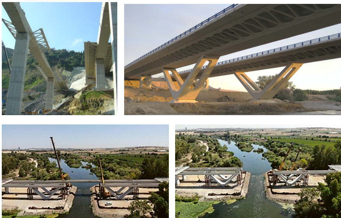
Figura 14. Imágenes de puentes de pilas en V prefabricadas y con jabalcones.
