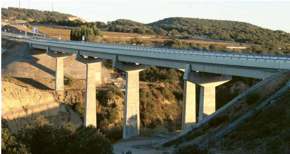
Figura 6. Imágenes de la duplicación del puente sobre el río Alcanadre (Huesca): vista inferior durante el montaje con lanzavigas, vista inferior y vista general acabado.
