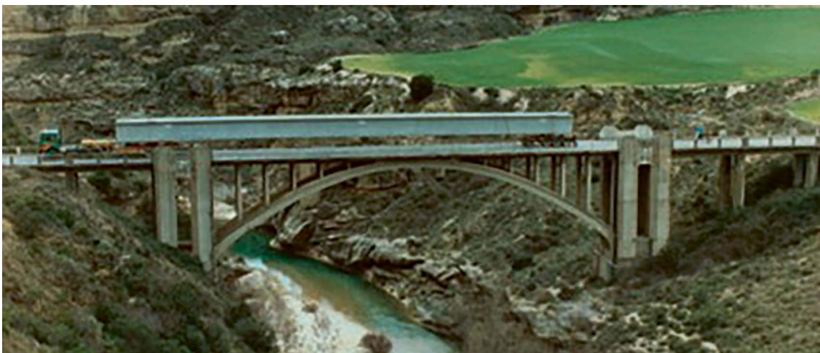
Figura 5. Imágenes del puente sobre el río Alcanadre (Huesca), 1989: vista inferior acabado, colocación de vigas del vano centra y paso del transporte de las vigas por el puente existente sobre el río Alcanadre.
