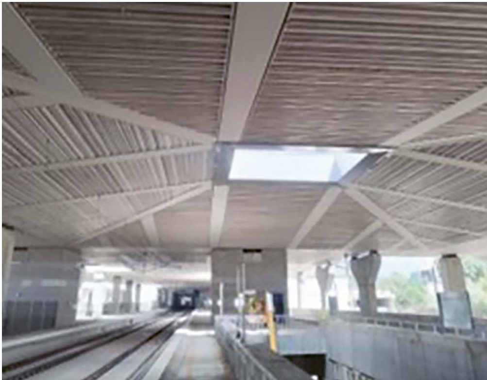
Figura 19. Imagen inferior de una cúpula completada.
