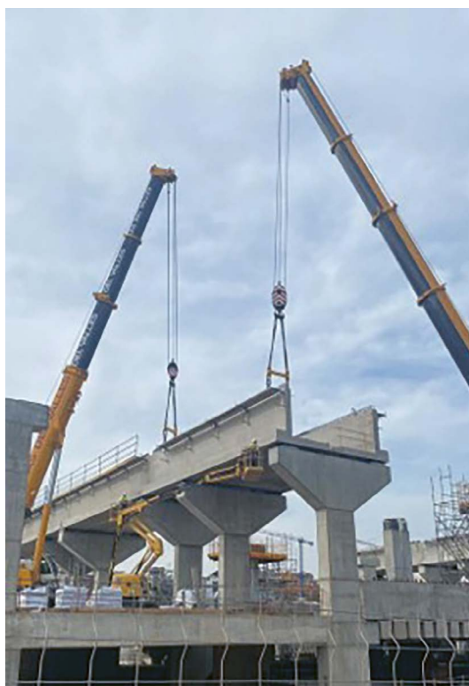
Figura 17. Imágenes de la colocación de semivigas para la construcción del entramado principal de cajones.
