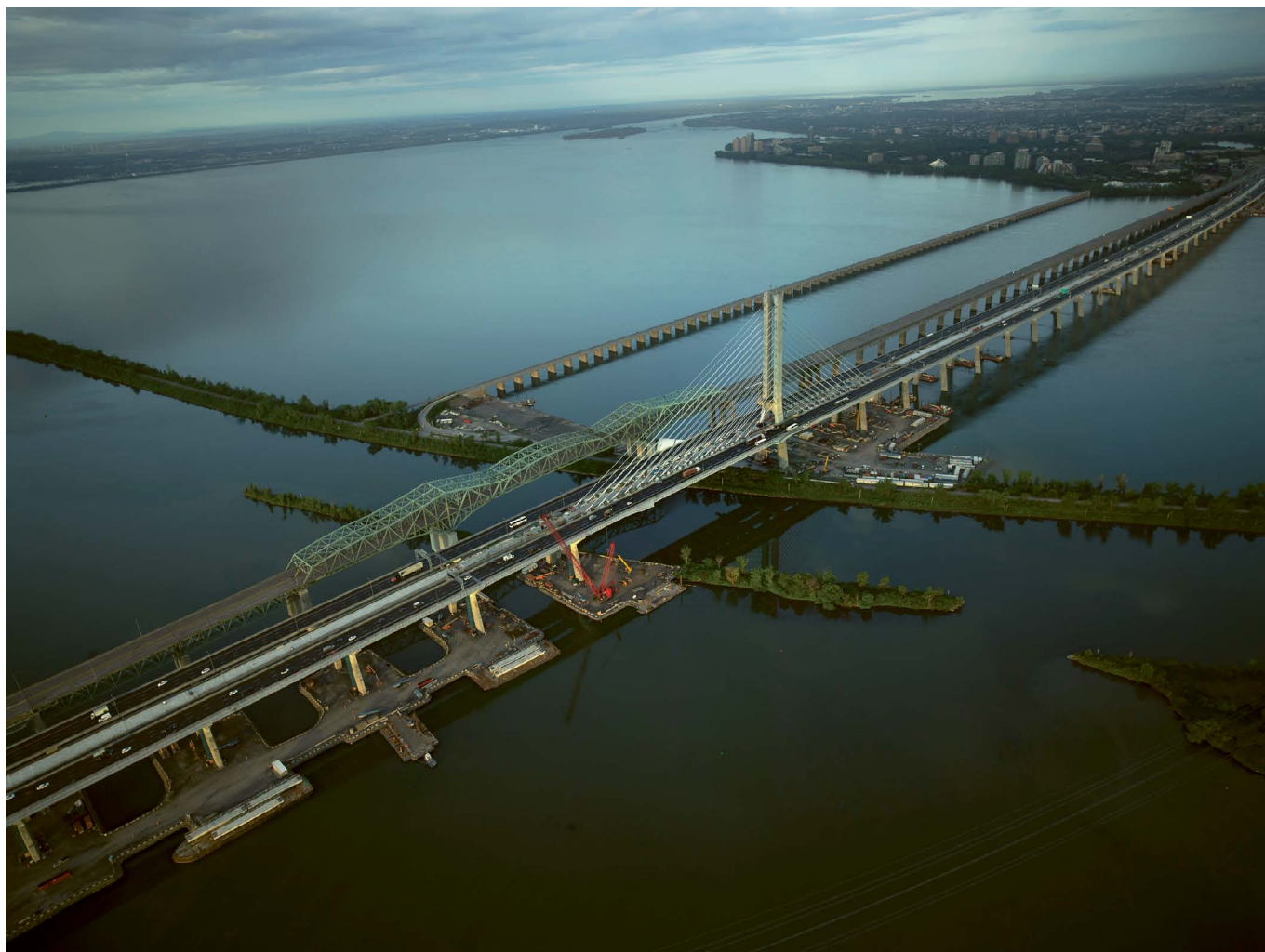
Figura 25. Nuevo Puente Samuel de Champlain. ©Thomas Heinser.
