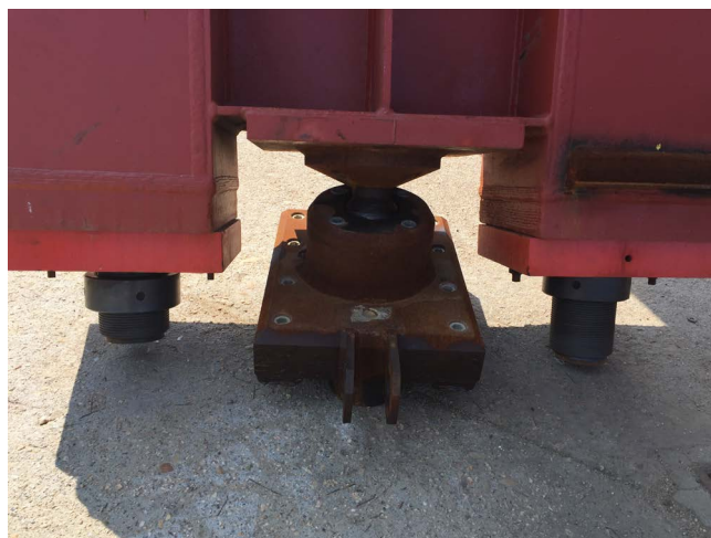
Figura 23. Sistema de apoyo doble del carro trasero. Ampliación del Puente de Rande.
