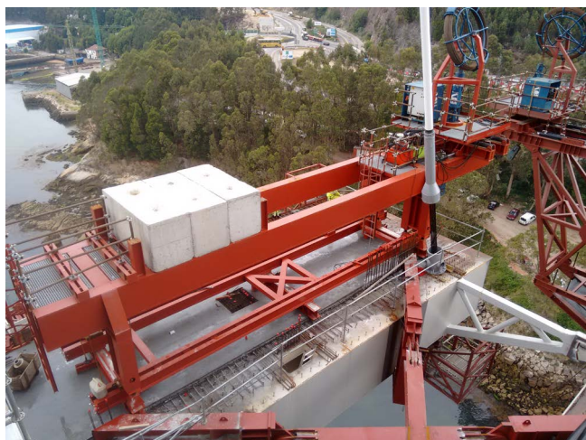
Figura 22. Carro de izado trasero empleado en la ampliación del Puente de Rande.
