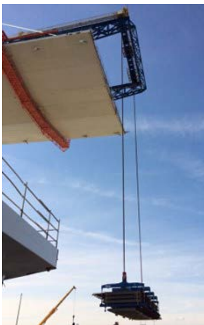
Figura 4. Izado del paquete de losas prefabricadas con el carro de izado. Puente de la Constitución de 1812.
