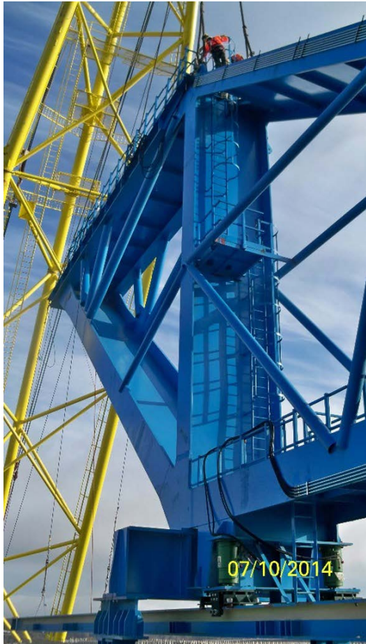
Figura 13. Carro izado dovelas. Queensferry Crossing.
