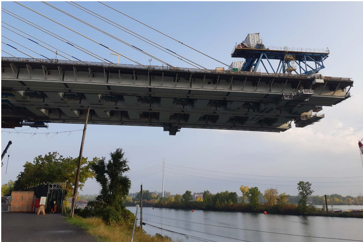
Figura 31. Vista del Seaway durante el avance en voladizo. Puente de Champlain.
