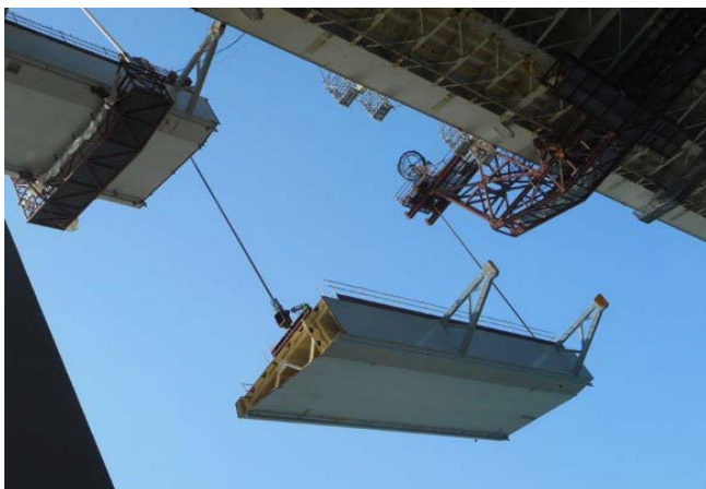
Figura 20. Dovela izándose en la ampliación del Puente de Rande.
