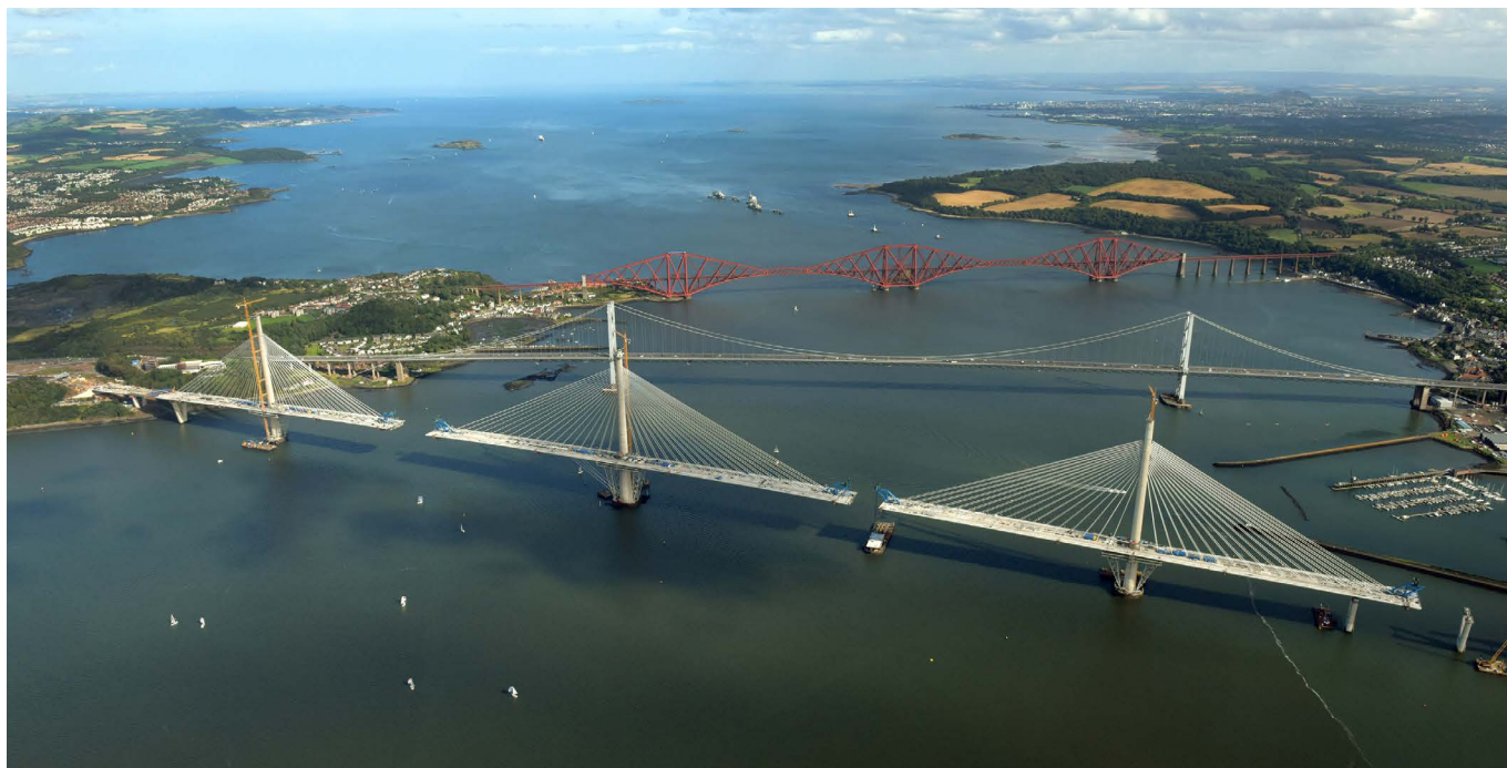
Figura 10. Vista de los tres puentes del estuario del Forth. Queensferry Crossing.
