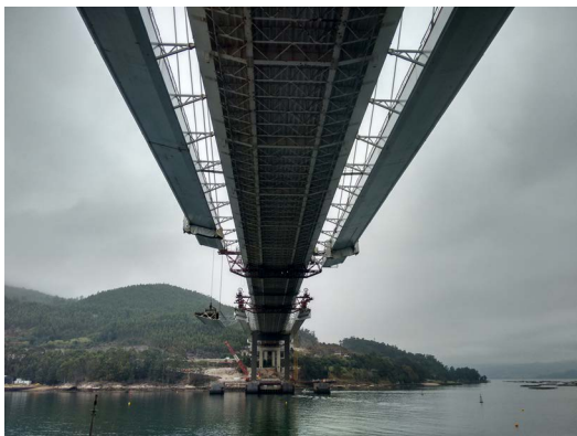
Figura 18. Vista inferior del tablero original durante la construcción de la ampliación.
