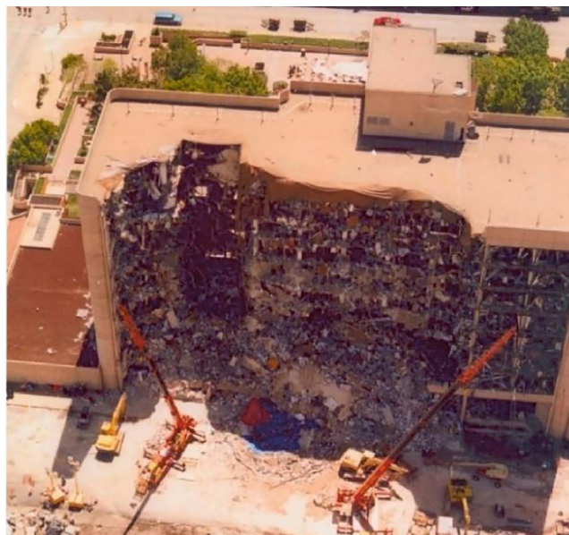
Figura 1. Edificio federal A.P. Murrah tras un ataque terrorista perpetrado con una furgoneta cargada de explosivos (Oklahoma, 1995) [2].
