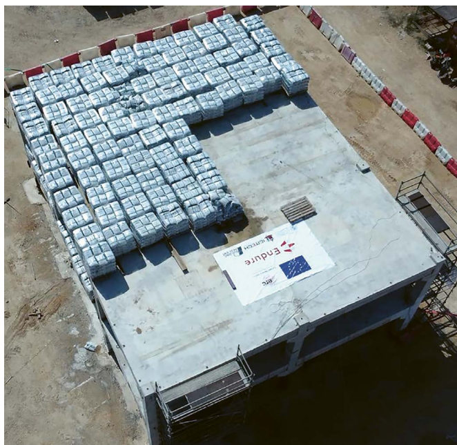
Figura 11. Foto del edificio de hormigón prefabricado construido dentro del proyecto ENDURE antes del ensayo.
