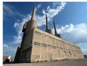
Chimeneas Central Térmica Sant Adrià del Besòs 2018
