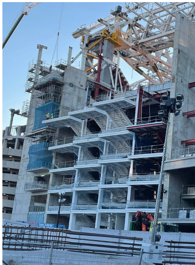
Figura 27. Escalera volada en ejecución.
