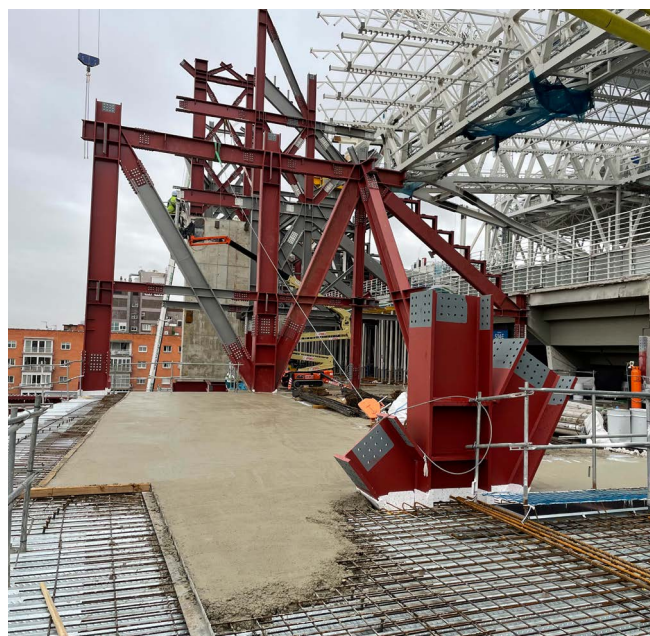
Figura 11. Pórtico tipo principal en ejecución.
