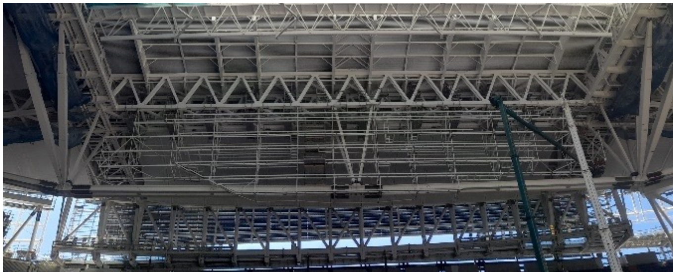
Figura 46. Estructura de fondos totalmente ejecutada.
