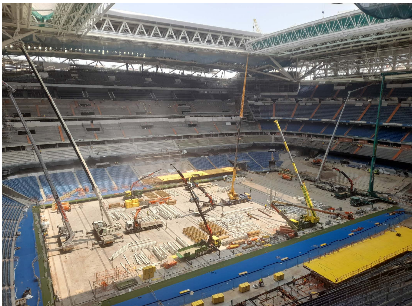
Figura 45. Izado del resto de la estructura.
