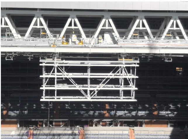
Figura 65. Izado del módulo central. Módulo 3.
