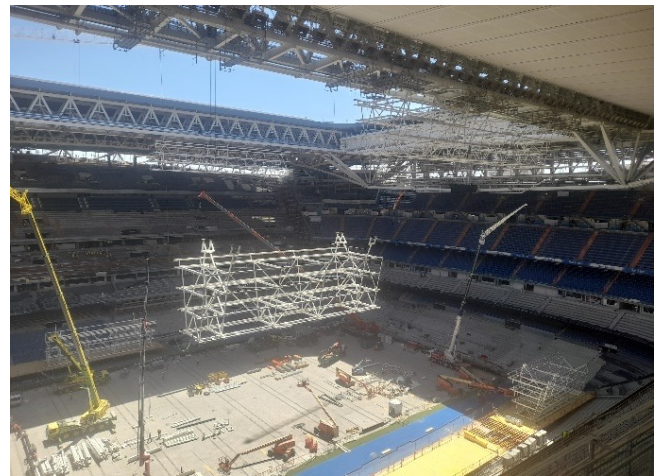
Figura 66. Izado de los tramos 2 y 4.
