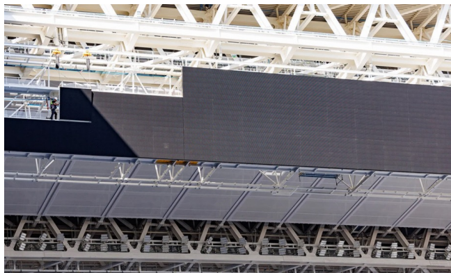
Figura 69. Instalación de las pantallas del videomarcador.
