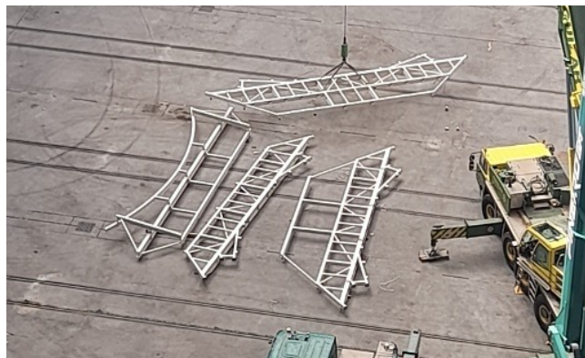
Figura 70. Estructura horizontal de la zona de curvas.
