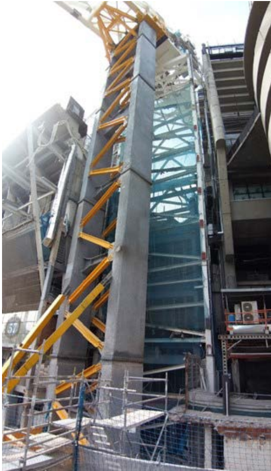
Figura 3. Torreón Sur, el nuevo péndulo de la cubierta a la izquierda, y el torreón tras la primera fase de demolición, a la derecha. Se aprecia como le torreón está encajado entre gradas del estadio.
