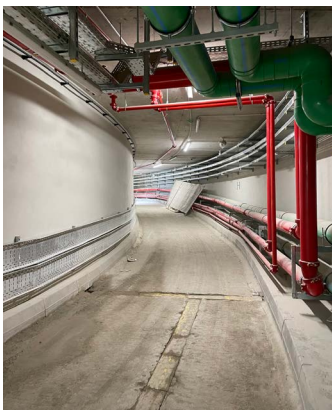
Figura 14. Imagen de la galería en proceso avanzado de construcción. Imagen procedente de visitas a obra equipo arquitectura.
