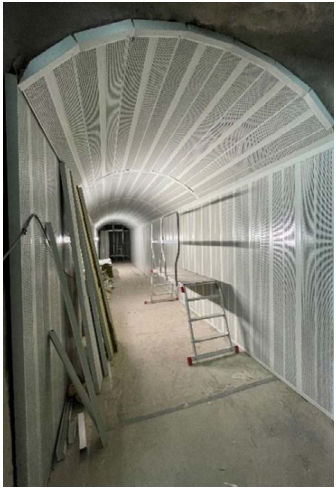
Figura 39. Imagen de galería subterránea de extracción de aire en el momento de instalación de paneles acústicos. Fotografía tomada por equipo de diseño en visita a obra.
