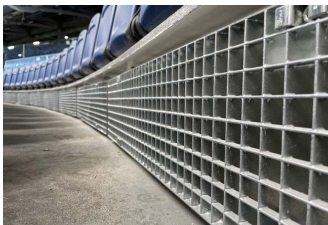
Figura 36. Imagen de tabicas de rejilla metálica en zona de grada baja para toma de aire. Imagen tomada por equipo de diseño en visita a obra.
