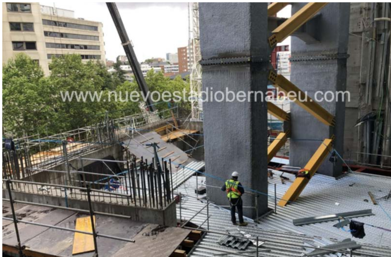
Figura 4. Imagen de obra de ejecución de la estructura del péndulo de torreón norte. Imagen procedente página web del club.
