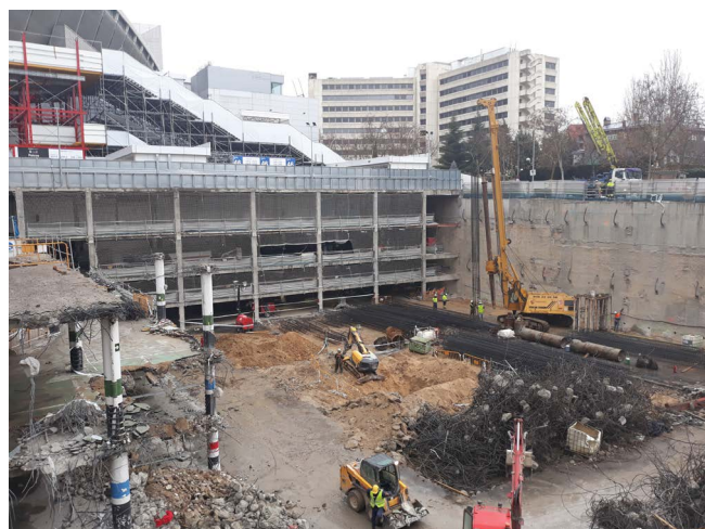
Figura 18. Demolición del lado sur del centro comercial.
