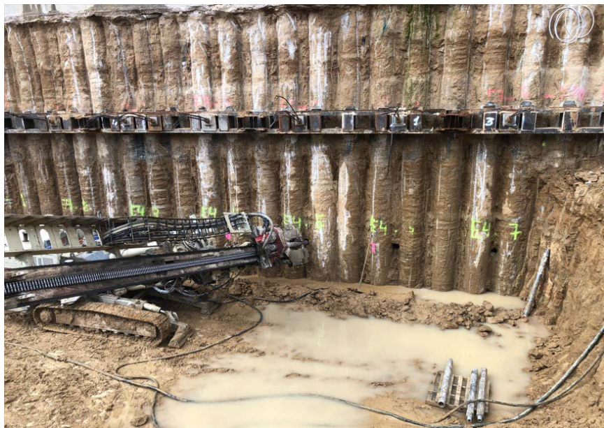
Figura 22. Ejecución de anclajes al terreno.
