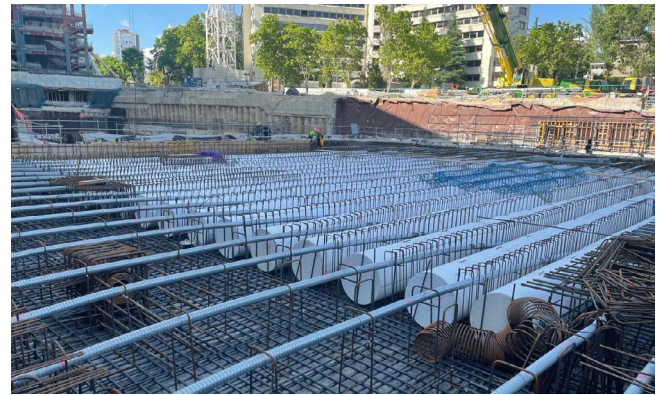
Figura 9. Ejecución de losa aligerada.
