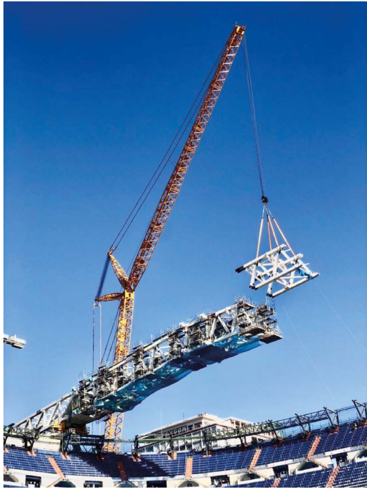
Figura 40. Izados con grúa de gran tonelaje y heavy lifting
