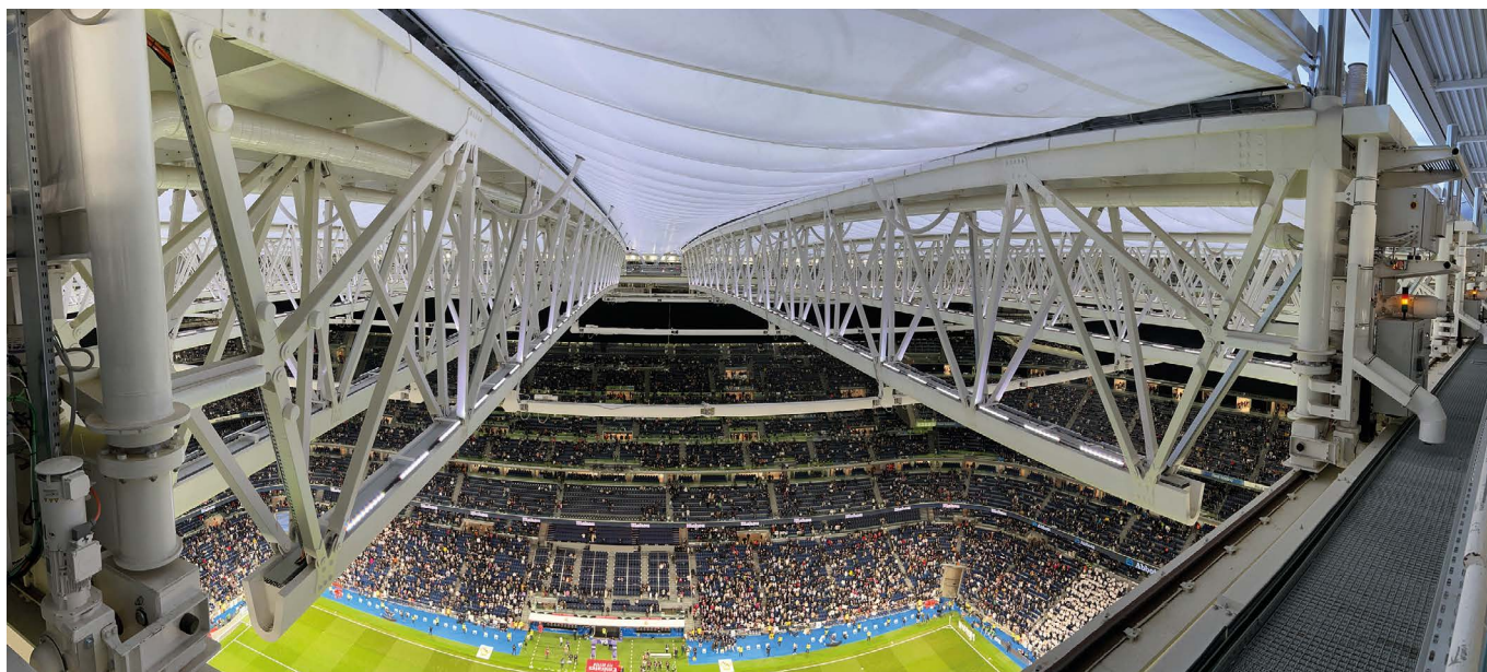
Figura 45. Vista interior de la cubierta retráctil.
