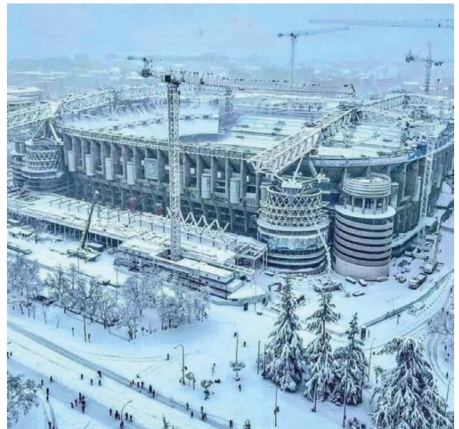
Figura 41. El estadio en obras cubierto de nieve.
