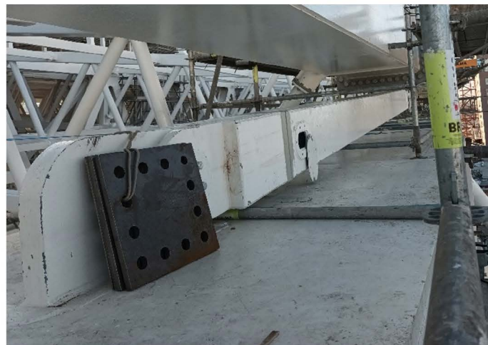
Figura 13. Bielas de bloqueo Norte/sur entre Corona y Cubierta.
