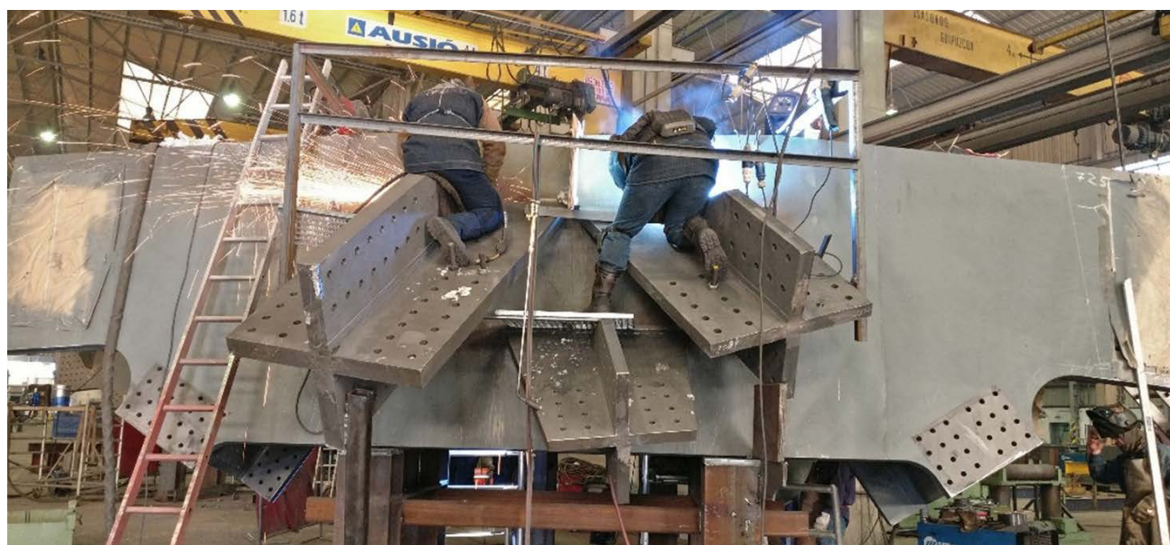
Figura 12. Ejecución de nudo corona en taller.
