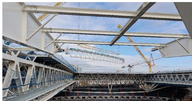
Figura 48. Montaje cerchas cubierta retráctil.
