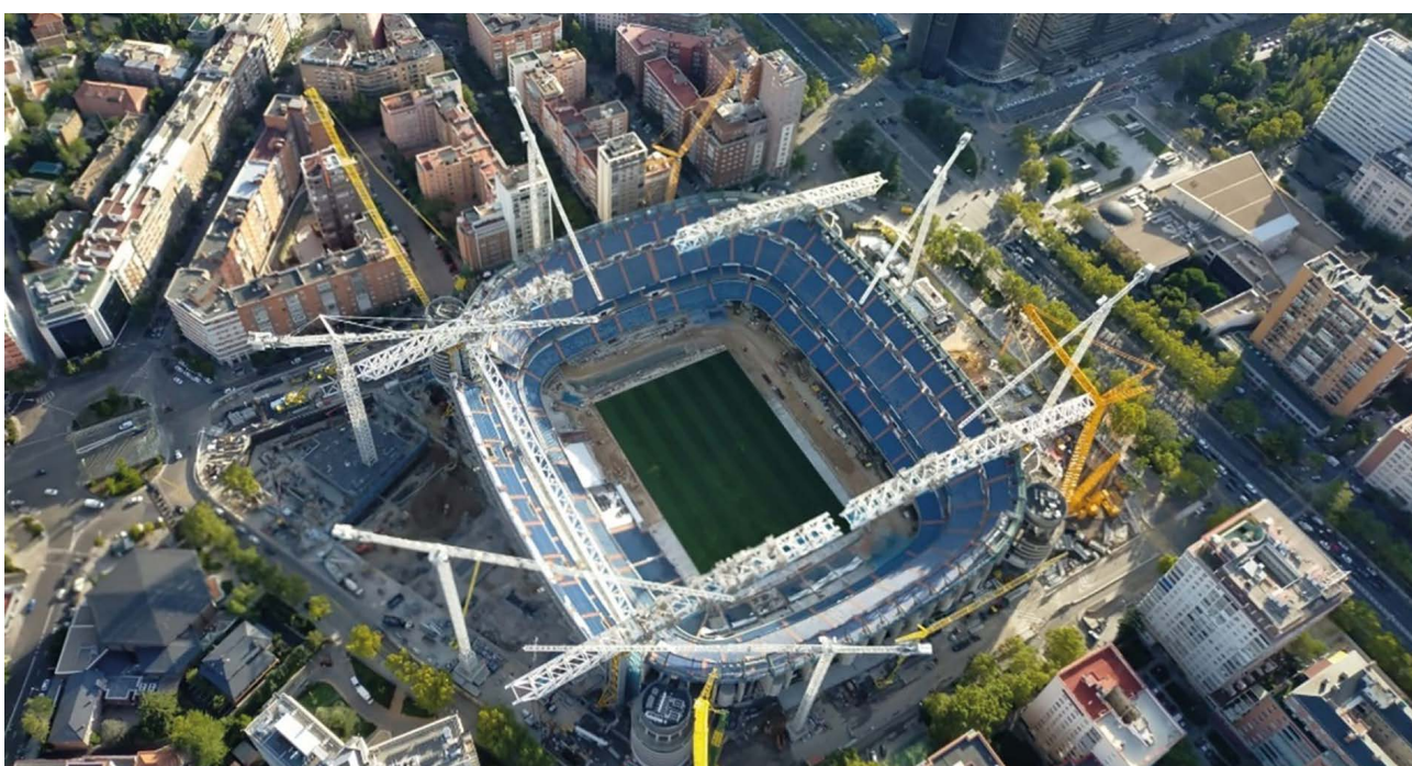
Figura 37. Vista aérea montaje cerchas atirantadas.
