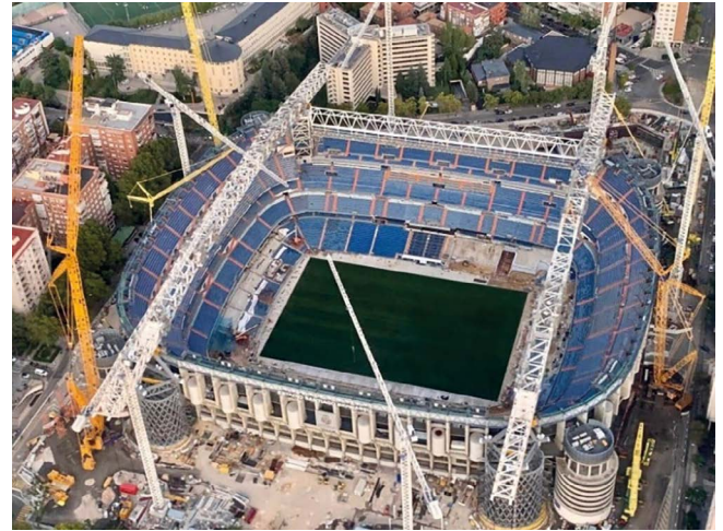
Figura 34. Vista montaje cerchas atirantadas.
