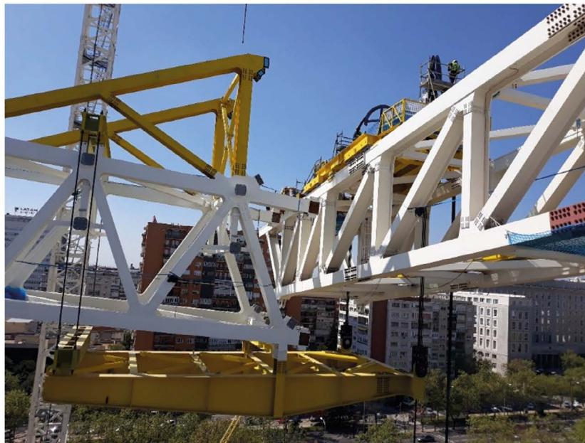
Figura 49. Vista estructura de izado.
