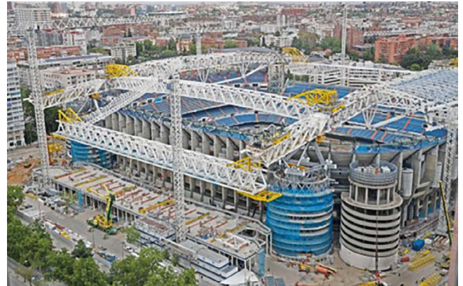
Figura 44. Elevación cerchas transversales.
