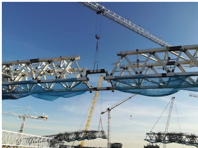
Figura 38. Vista cierre cercha atirantada.
