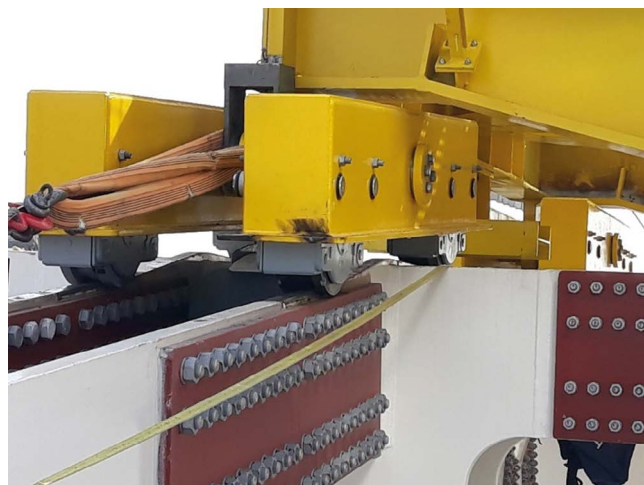
Figura 42. Unión atornillada cercha atirantada y paso de carretones.
