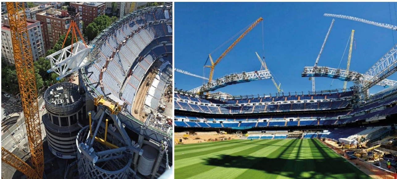
Figura 36. Vistas montaje cerchas atirantadas.
