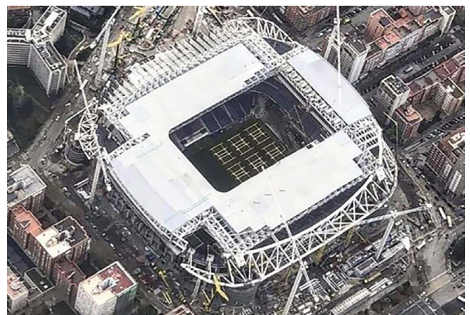
Figura 47. Vista aérea montaje de la cubierta.
