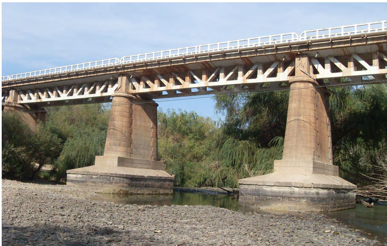
Figura 20. Tramos de la margen derecha, con las pilas levantadas sobre los cimientos romanos. Foto del autor.
