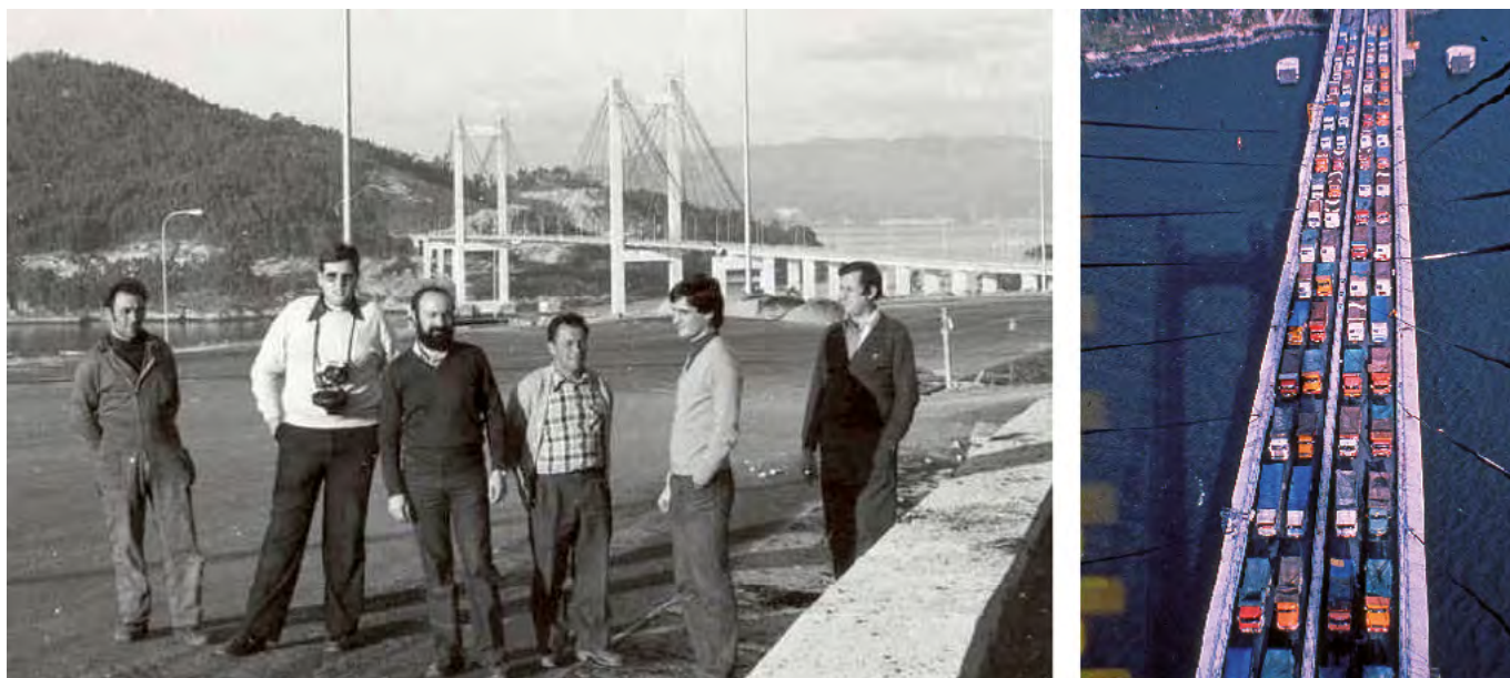
Figura 16. Prueba de carga del puente de Rande (1975-1977). Personal del Laboratorio Central: Luis Ortega y Rafael Astudillo (segundo y tercero por la izquierda) y Heliodoro García y Carlos Castejón (primero y segundo por la derecha).
