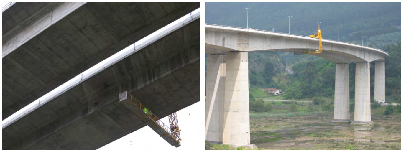
Figura 17. Inspección de los puentes de Ontón y Oriñón (1998).
