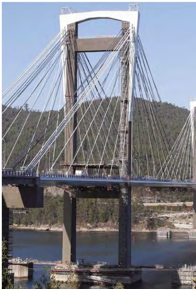
Figura 16. Puente de Rande. Recrecido de la torre.
