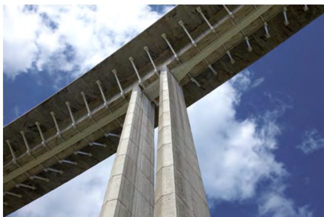
Figura 10. Viaducto de San Pedro de la Ribera. Vista inferior.
