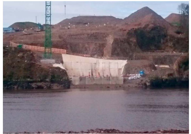
Figura 3. Cruce del río durante la construcción (P4 central -derecha- y P3 lateral -izquierda-).
