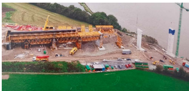
Figura 10. Tramo de cimbra sobre el vano 1 y 2.
