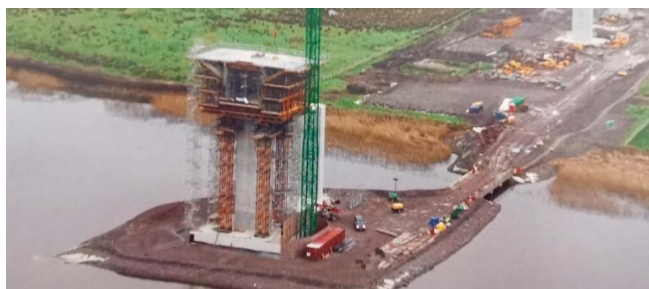
Figura 17. Dovela "0" sobre pila 4. Construida sobre cimbra.
