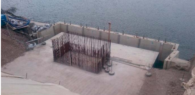
Figura 4. Cruce del río durante la construcción (P4 central -derecha- y P3 lateral -izquierda-).
